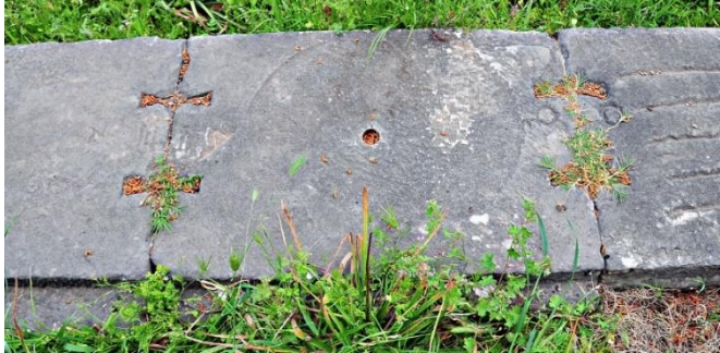
Ilustración 14. Replanteo Sillares Templo Atenea. http://traianvsnet.blogspot.com.es/2013_01_01_archive.html
