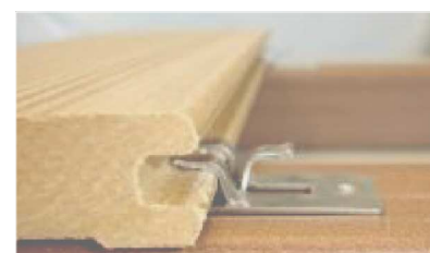
Sistema de anclajes ocultos del pavimento exterior
