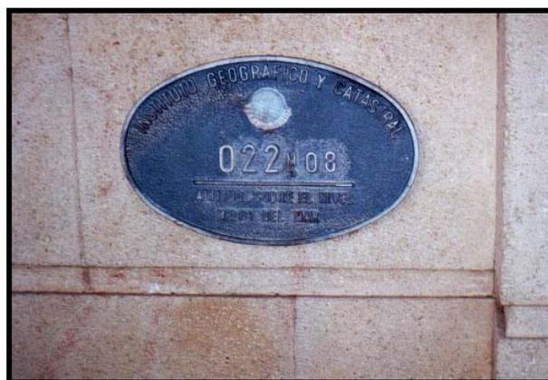
**Figura 3.5:** Placa ovalada situada sobre la señal NP en la estación de ferrocarril de Almansa.
