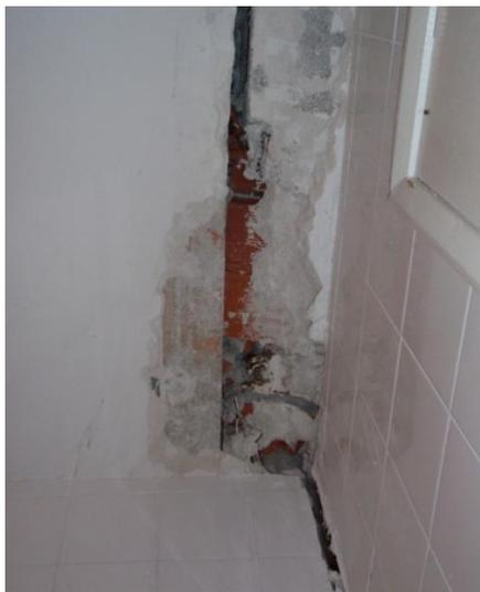
*Figura 13 Fisura zona interior. Año 2012. Fuente: elaboración propia.*
