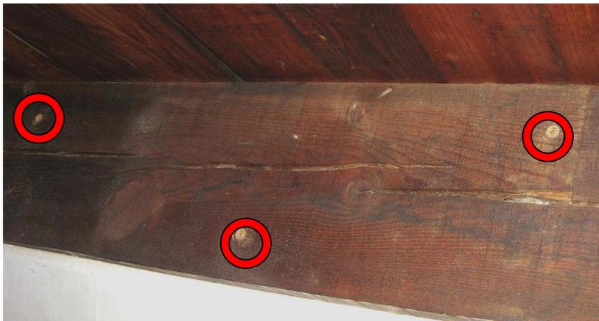
*Figura 42 Inyección producto anticarcoma. Fuente: eliminacionplagas.com*
