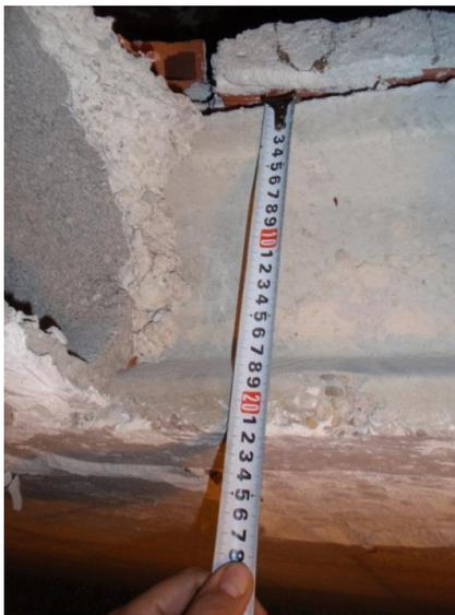
*Figura 8 Forjado sin capa de compresión ni negativos. Año 2012. Fuente: elaboración propia.*
