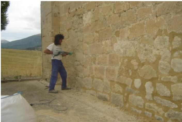
*Figura 68 Rejuntado de piedra exterior. Año 2009. Fuente: elaboración propia.*
