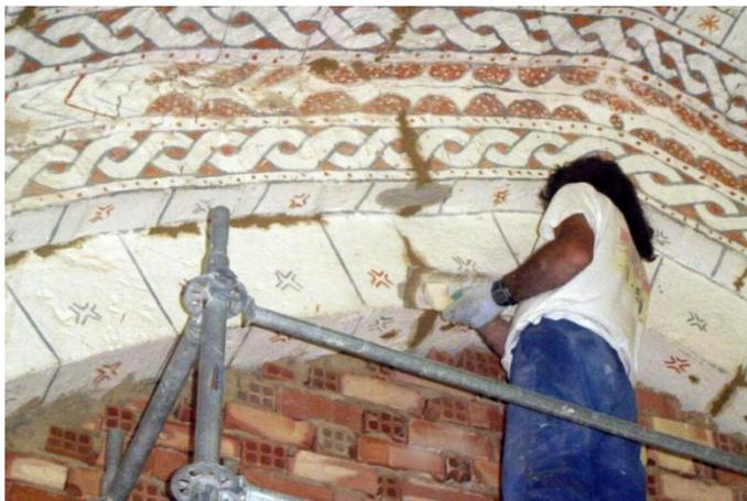
*Figura 66 Cosido de piedra 5 (retacado de varilla). Año 2009. Fuente: elaboración propia.*
