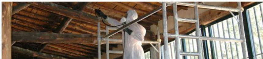
*Figura 43 Tratamiento de carcoma con pulverización. Año 2015. Fuente: plaguiplan.es*
