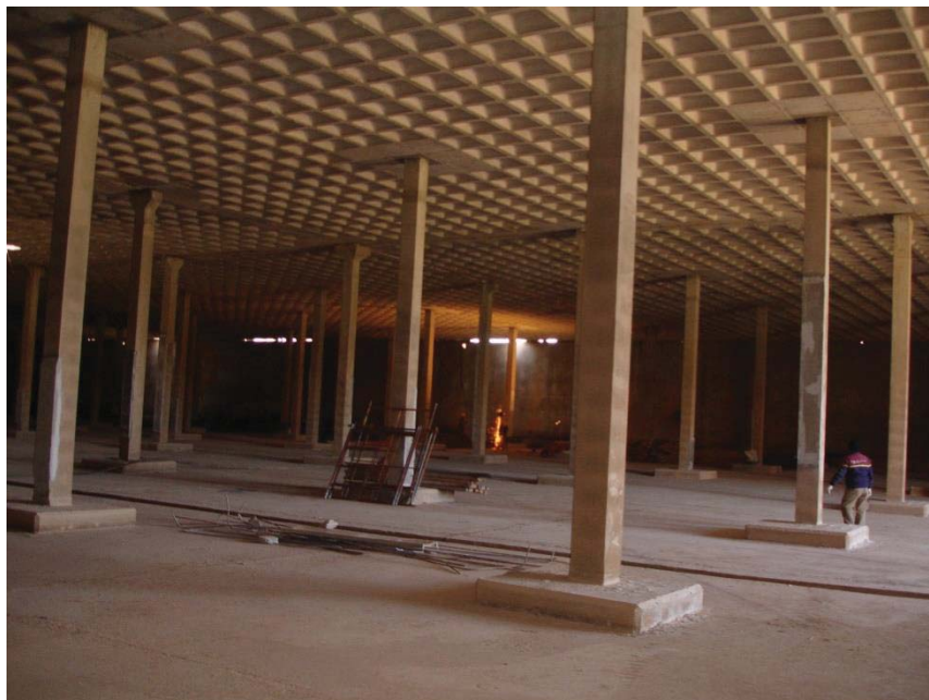
Figura 6: Interior del depósito
