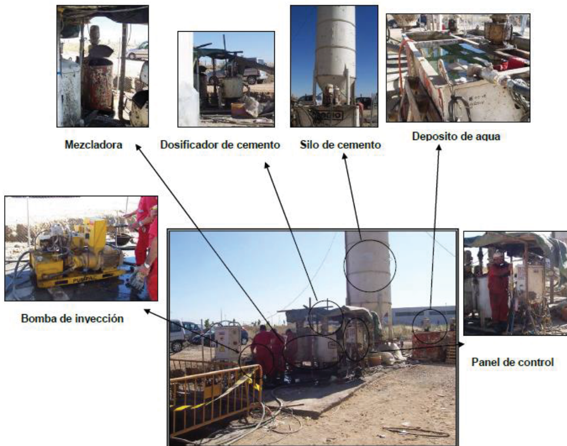
Foto.- 8.16 Planta de fabricación de lechada. (Foto del Autor)
