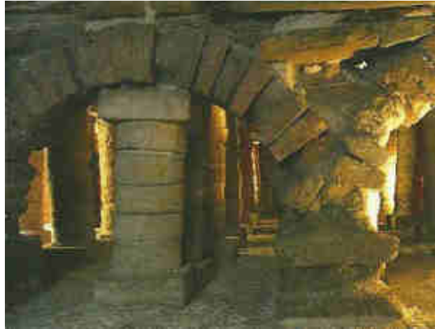
Figura8 : Hipocausto de arquillos de las Termas de Campo Valdés (Gijón). Año: 2011. Fuente 3 : Menuda es la Historia [W8] [w8r]
