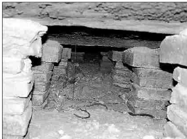
Figura9 : Túneles que formaban parte del sistema de calefacción subterráneo del hipocausto de La Vega de Valduno (Asturias). Año: 1 de Octubre 2006. Fuente: http://www.grao.net/avisos/avisos34.html
