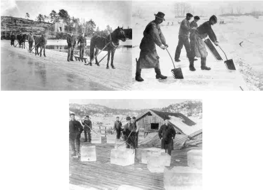
Figura17: Fotografías que detallan las operaciones de cómo se trabaja el hielo en la Wenham Lake Ice Company, a principios del siglo XIX. Fuente : London Canal Museum.
