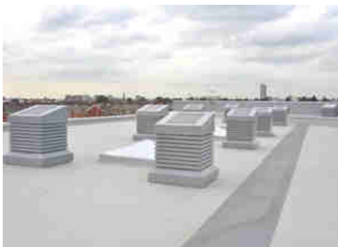
Figura27 :Monodraught en un edificio contemporaneo.2014.Fuente:Monodraught
