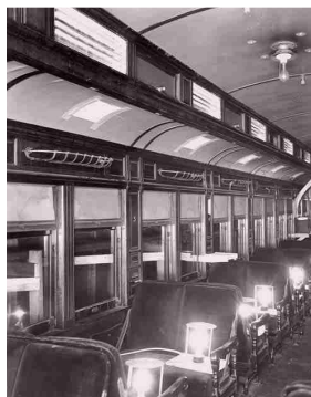
Figura31 : El interior de la demostración del coche de ferrocarril que Carrier utiliza luces para imitar el calor desprendido por los pasajeros. 1930. Fuente: Carrier
