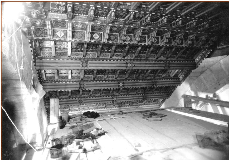
*Ilustración 96. Trabajos de construcción de la réplica del artesanado y plataforma de trabajo situada a tal efecto.*
