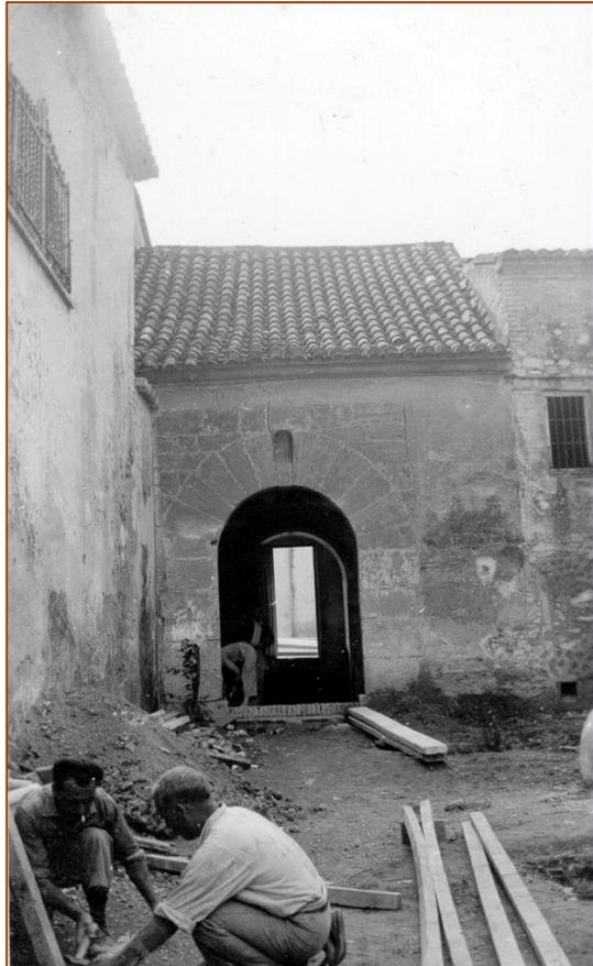
Para consolidar el artesonado se decidió liberarlo de cargas, eliminando la cubierta que se apoyaba sobre él. En su lugar, se construyó una nueva cubierta resistente que cubría toda la sala. El artesonado original, se ancló mediante tirantes a la nueva estructura, pasando de tener un papel resistente a sólo un papel ornamental.
