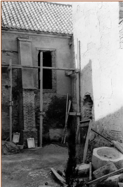
*Ilustración 95. Imágenes de construcción del estribo y del recrecido del muro hasta alcanzar la cota de la nueva cubierta.*
