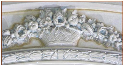
Para estos casos, la técnica utilizada ha consistido en realizar fotografías lo más ortogonales y a la mayor distancia posible de los elementos, para tratar de evitar la vista en proyección. Estas fotografías se han insertado en el entorno de Autocad y se les ha calculado y aplicado el factor de escala necesario para darles en el dibujo las dimensiones reales, previamente medidas insitu o bien estimando sus medidas por comparación con otras medidas conocidas.
