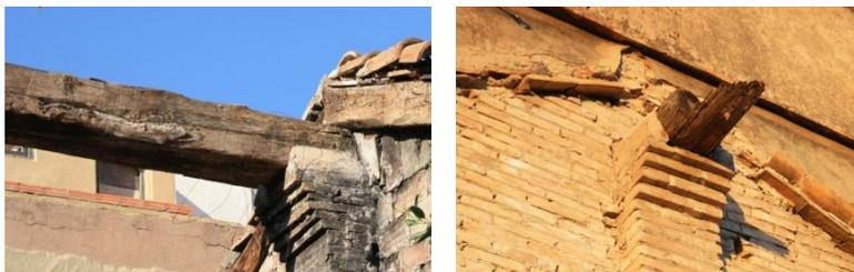
Immagine 6.14 | Dettaglio costruttivo pilastro-trave;
