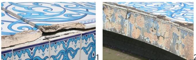
Immagine 4.7 | 1\_ Deformazione, distacco e rottura della piastrella, causata da una eccessiva cristallizzazione del sale;
