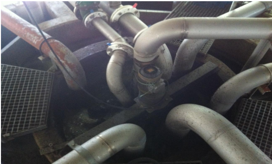
Figura 3.17: Cámara de mezcla de fango, entrada a digestión anaerobia de la EDAR de Arazuri (Fotografía de Mikel Sanz).
