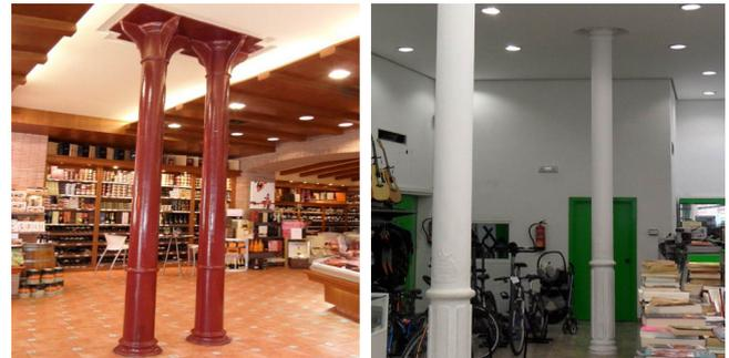
Figura 6. Pilares de fundición en planta baja.
