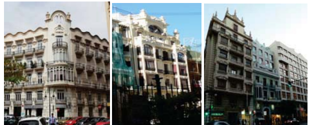
Figura 2. Edificios del barrio de Pla del Remei
