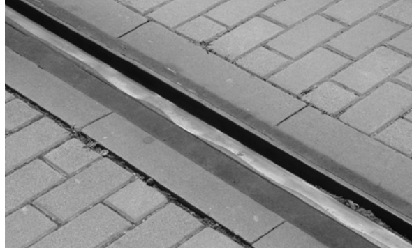
Figura 2.3. Corrugación resonancia P2 en una vía de tranvía.
