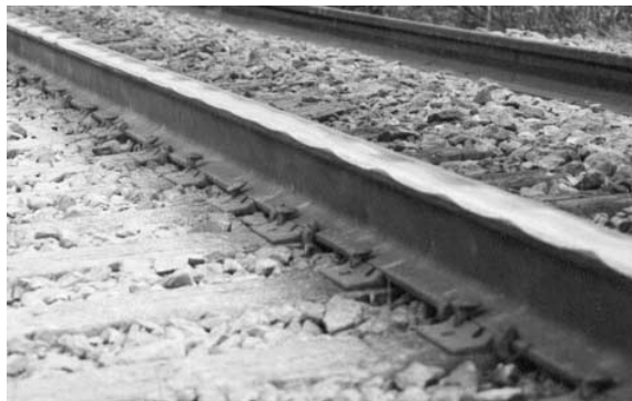
Figura 2.2. Corrugación heavy haul. De la referencia [69].
