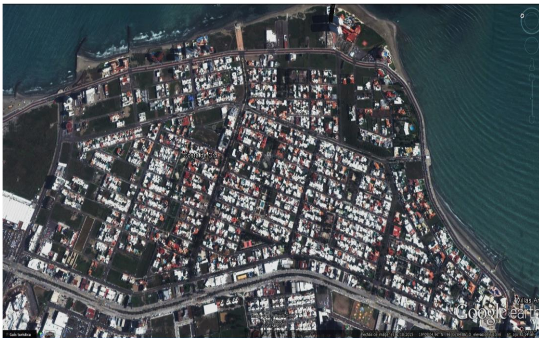
Figura 60. Fraccionamiento Costa de Oro en Boca del Río, Mex. Fuente: Google Earth (2015).
