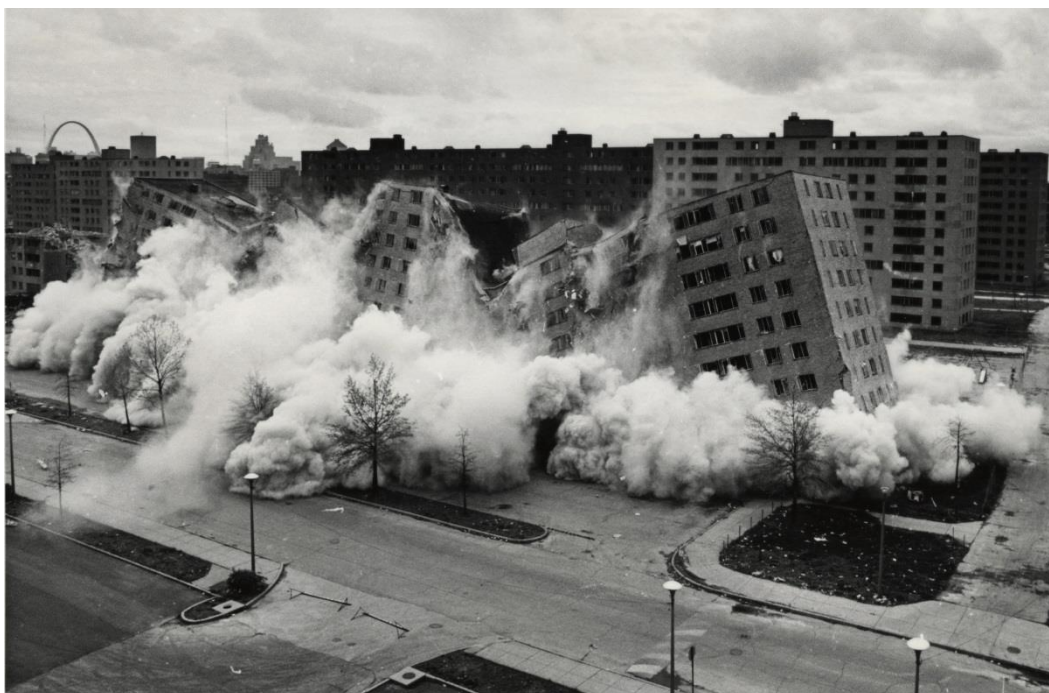
Figura 41. Demolición del conjunto residencial Pruitt Igoe en Missouri, USA. Fuente: sustainablecitiescollective.com. consultado el 14/05/15.
