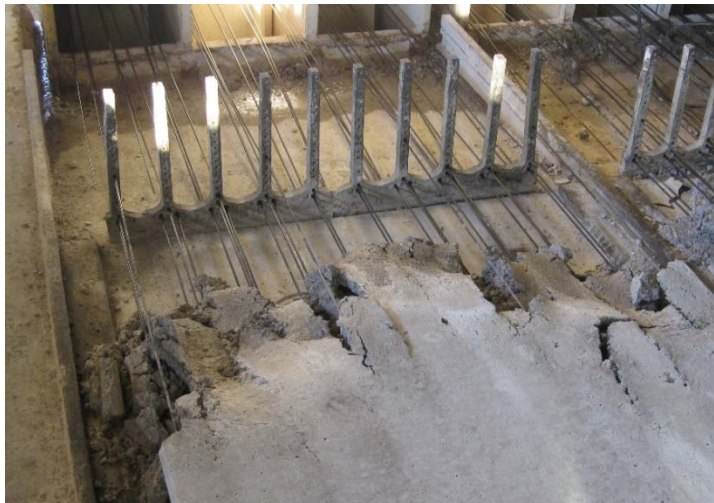
Figura 3-5 Plantilla de alineación de cables (Imagen cedida por HORVITEN VALENCIA, S.A)
