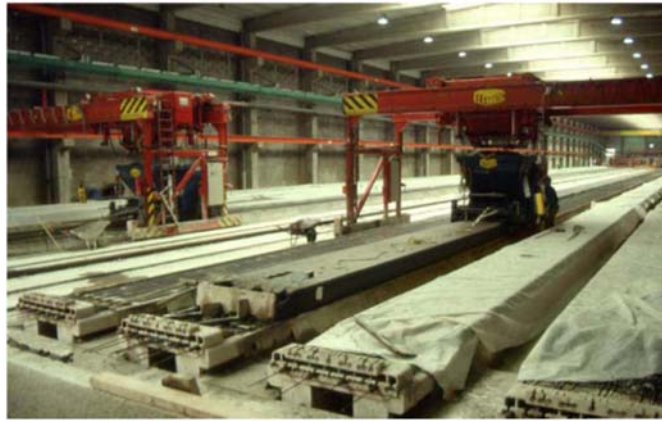
Figura 3-10. Curado con recubrimiento con lámina plástica
