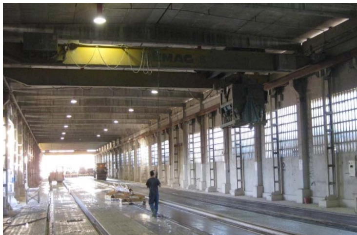
Figura 3-8 Cubilote de transporte de hormigón (Imagen cedida por HORVITEN VALENCIA, S.A)
