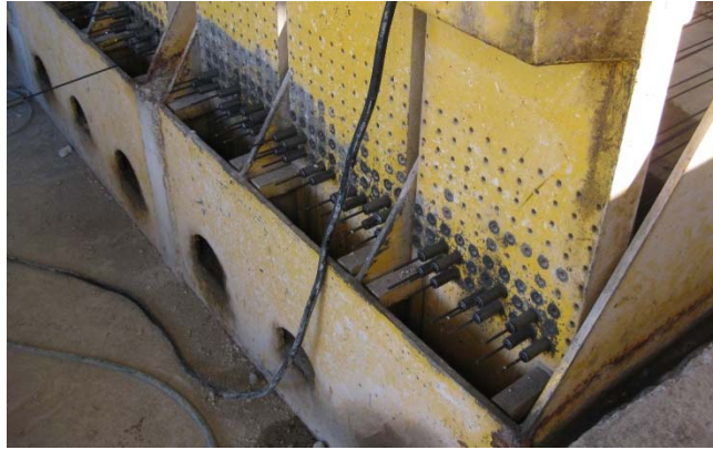
Figura 3-4. Bancada de tesado con anclaje de tendones (Imagen cedida por HORVITEN VALENCIA, S.A)
