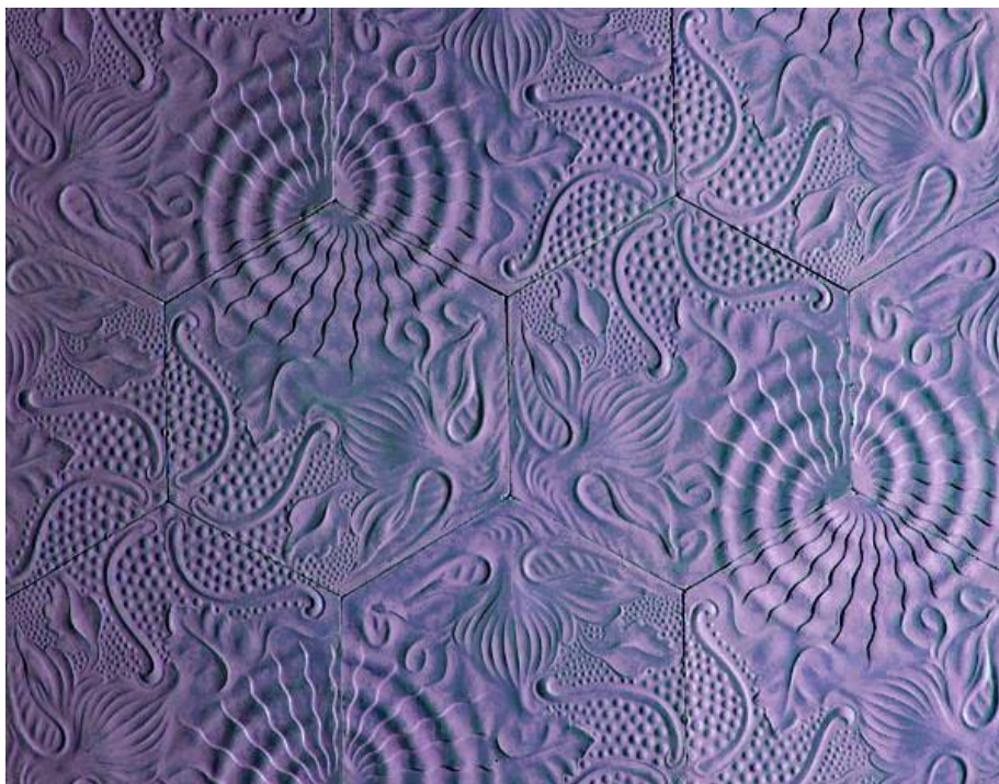
Fig. 12. Pavimento hidráulico diseñado por Antoni Gaudí, entre 1904 y 1906 para la rehabilitación de la casa Batlló, producido por Escofet, S.A. y luego colocado en el Paseo de Gracia de Barcelona.
