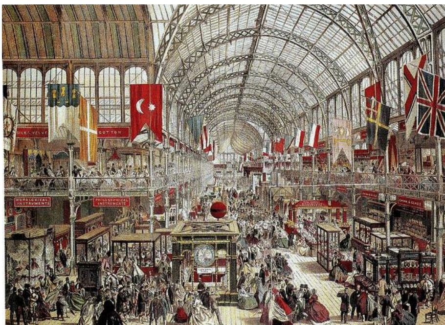
Fig. 10. Imagen del Palacio de Cristal en Hyde Park, inaugurado por la Reina Victoria, fue construido totalmente en cristal y hierro en nueve meses.
