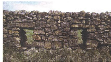
Figura 79 - Desagües de bancales. Fuente: F. Miralles.
