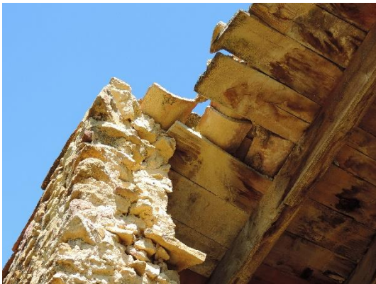
Figura 98 - Entablado y vigas que sustentan una cubierta. Fuente: Propia.
