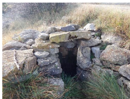
Figura 54 - Pozo con cobertura de piedra en seco. Fuente: Propia.
