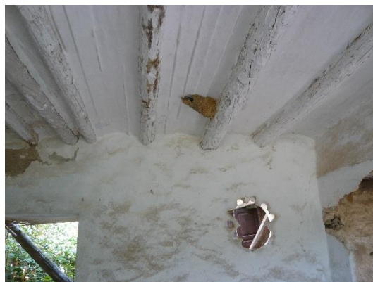
Figura 92 - Forjado resuelto con un encofrado de yeso. Fuente: Propia.
