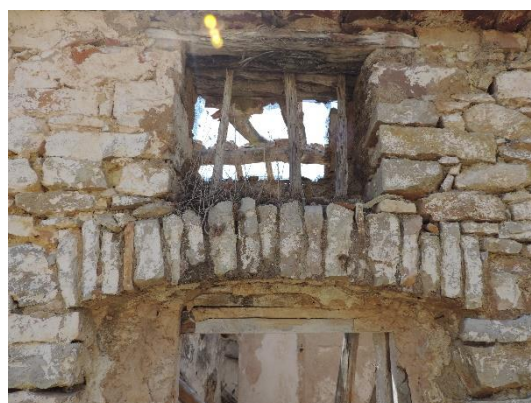
Figura 89 - Dintel y reja de enebro. Fuente: Propia.
