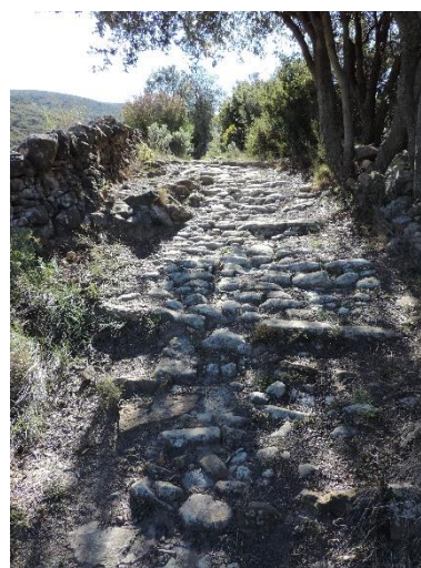
Figura 95 - Zona pavimentada, les Useres. Fuente: Propia.
