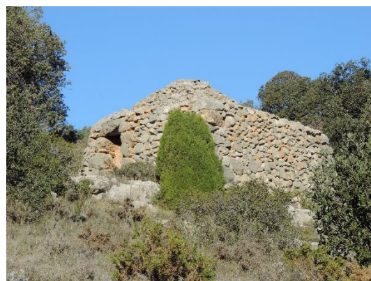
Figura 81 - Ejemplo de construcción de piedra en seco. Fuente: Propia.
