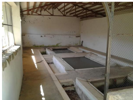
Figura 37 - Lavadero de Vistabella. Fuente: Propia.
