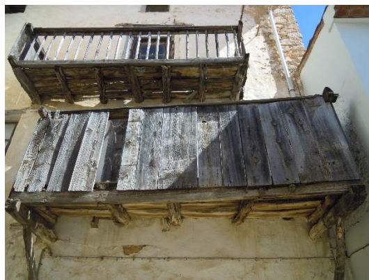
Figura 44 - Detalle de un balcón de construcción más simple que en caso anterior.
