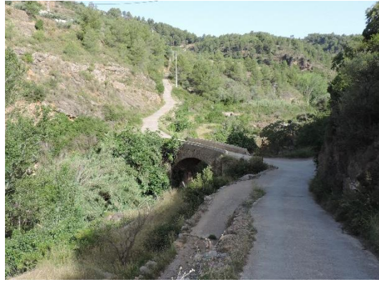
Figura 71 - Puente en el río Llucaena. Fuente: Propia.
