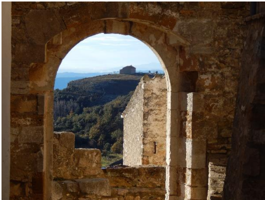
Figura 49 - Portal restaurado en el centro histórico de Culla. Fuente: Propia.
