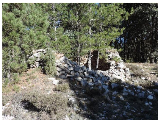
Figura 90 - Horno de cal. Fuente: Propia.
