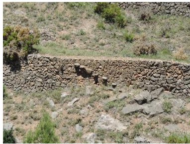
Figura 76 - Escaleras de sillar en un muro de piedra. Fuente: Propia.
