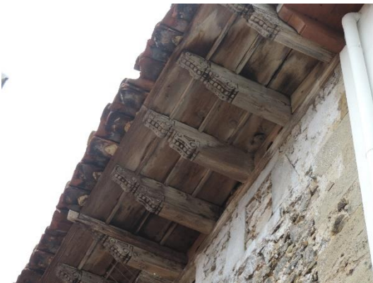
Figura 41 - Detalle del alero de una vivienda de clase alta. Fuente: Propia.
