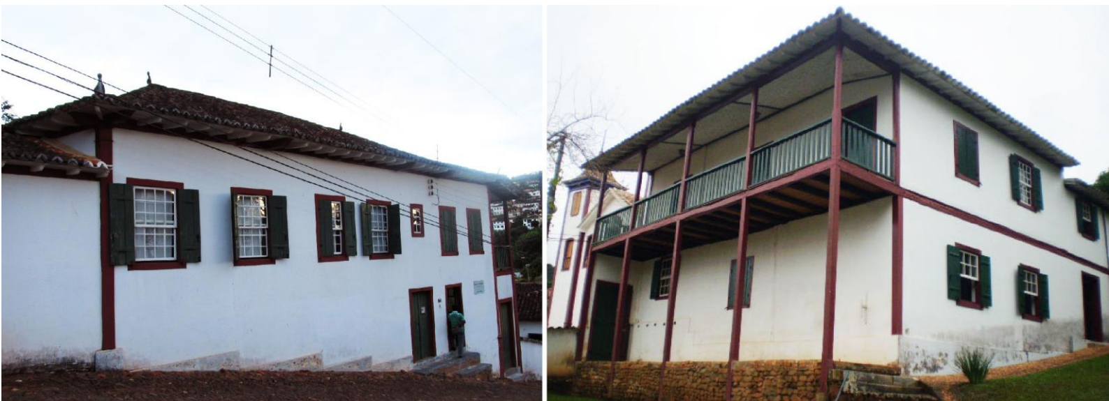
Fig. 61. Fachadas Noroeste y Suroeste
