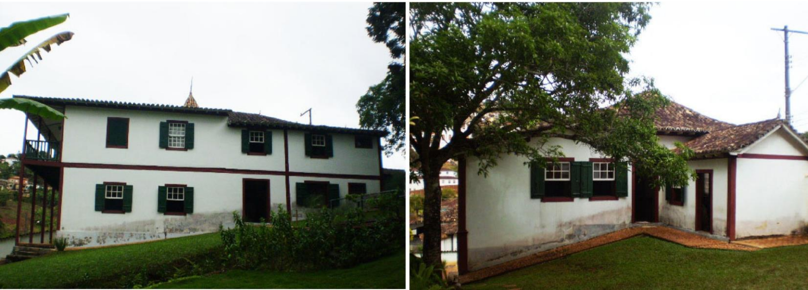
Fig. 62. Fachadas sureste y Noreste
