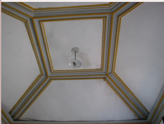
Fig.40. Forro inclinado tipo gamela en la casa Borba Gato-museo do Ouro
