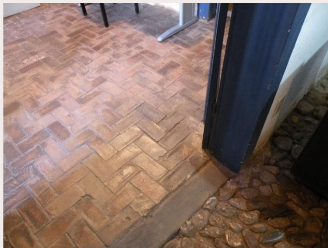
Fig.42 Pavimento de barro en la Casa Borba Gato
