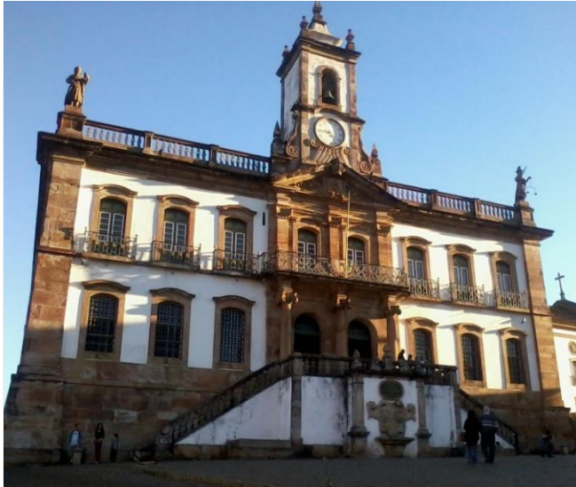
Fig.27. Fachada del museo da Inconfidência , en sillería con ornamentación también en piedra
