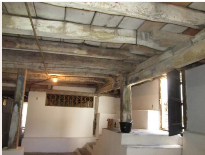
Fig.37. Forjado en madera del museo do Diamante
