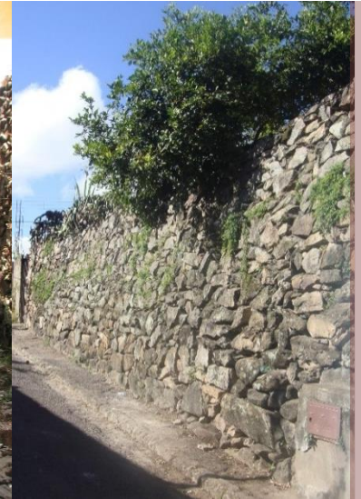
Fig.29. Muro a seco del terreno del museo Regional de Caeté
