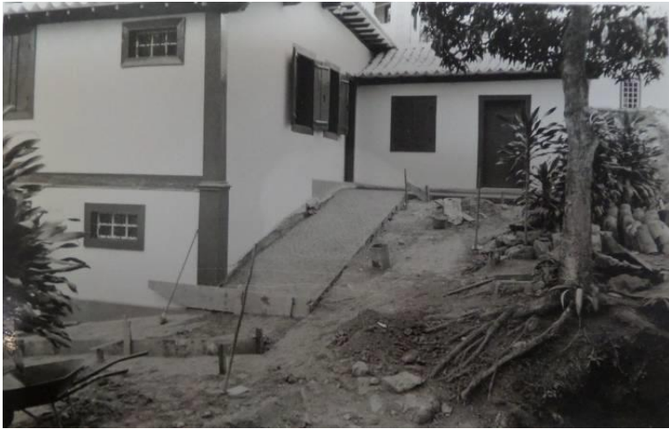
Fig.75. Acera construida en la intervención
