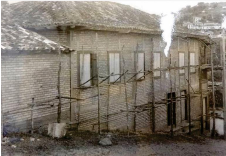
Fig. 73. Substitución del adobe por ladrillos en la fachada
