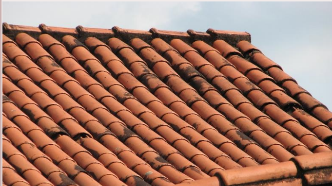
Fig.46. Teja cerámica tipo canal en la casa Borba-Gato
