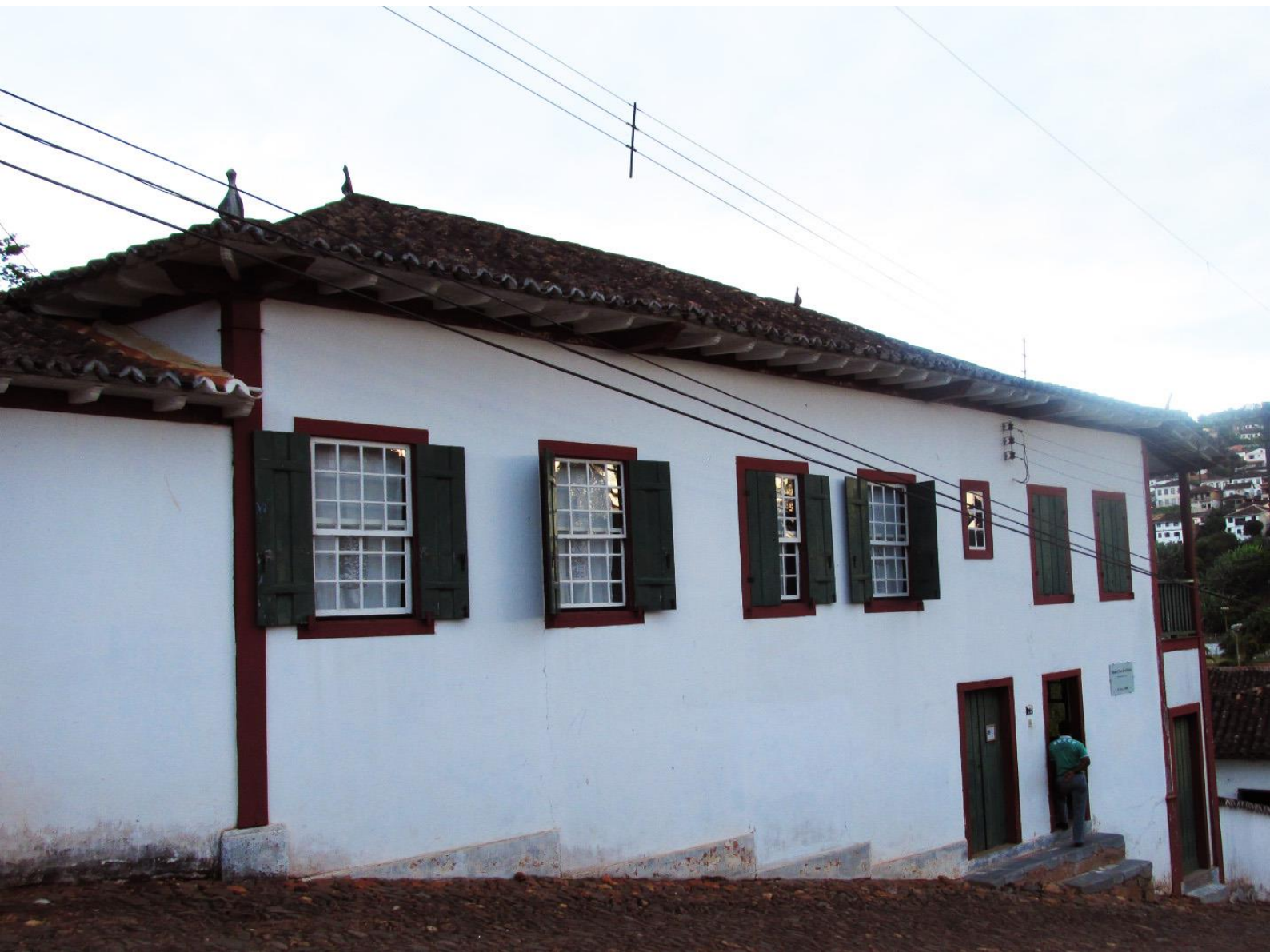
Fig.1. Fachada principal del museo Regional Casa dos Ottoni
