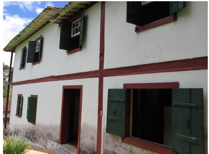
Fig. 85. Revestimiento de la fachada
