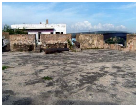
Figura 20. Vista fuerte Santa Bárbara. Fuente: Jemmy Bello (2013)
