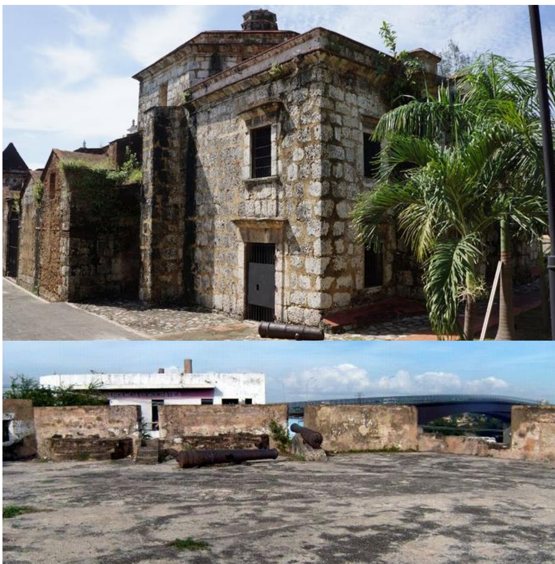
Figura 124. Iglesia Santa Bárbara, lateral izquierdo, presencia de patologías: alto grado de suciedad, humedades y algas verdes epilítico, y el fuerte estado ruinoso. Fuente: Jemmy Bello (2012)
