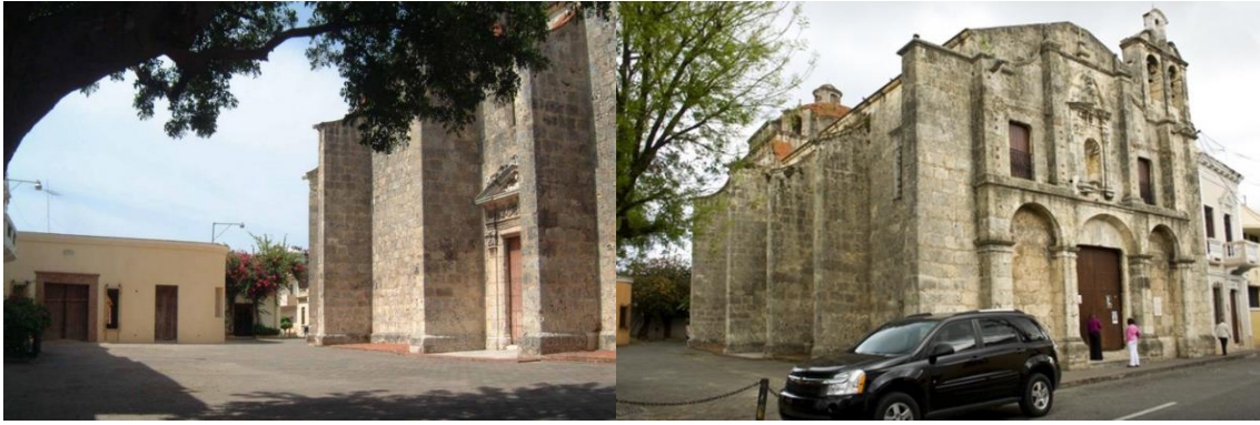
Figura 31. Fachada este, vista de contrafuertes. Fuente: David. F (2014)
