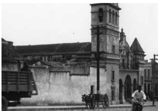
Figura 83. Vista desde el oeste, se aprecia que en el lugar de la puerta hay un espacio techado, probablemente con una losa plana. AGN. En las fotos se menciona Ciudad Trujillo (a partir de 1936). Observar la modificación de la puerta inferior del campanario.
