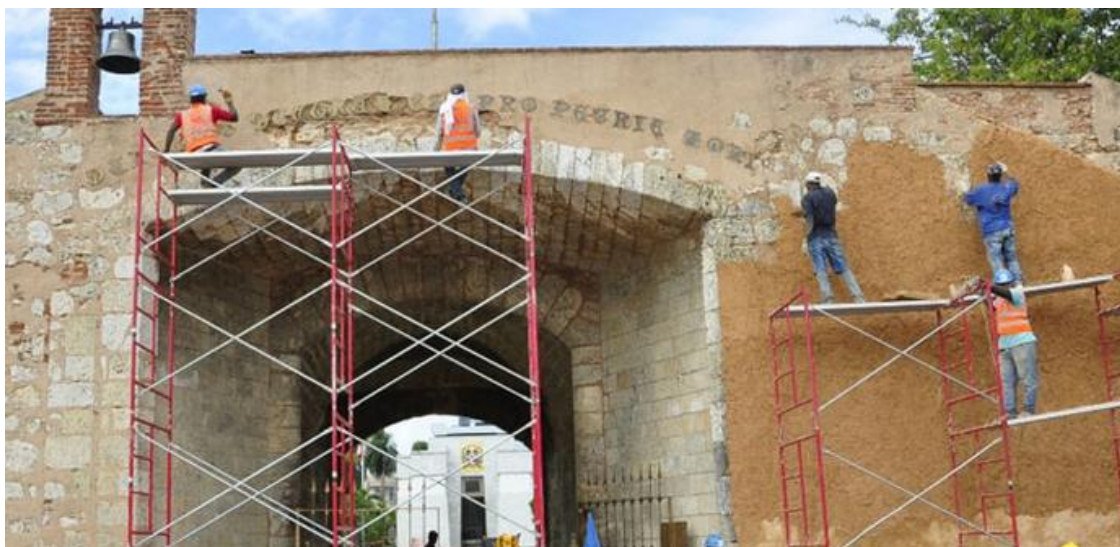
Figura 105. Puerta del Conde, intervención. Fuente: David. F (2012)
