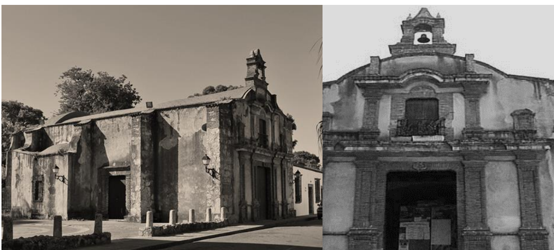
Figura. 57 Lateral derecho, vista de la plaza que la une al convento Dominico, iglesia Tercera Orden (1975)
