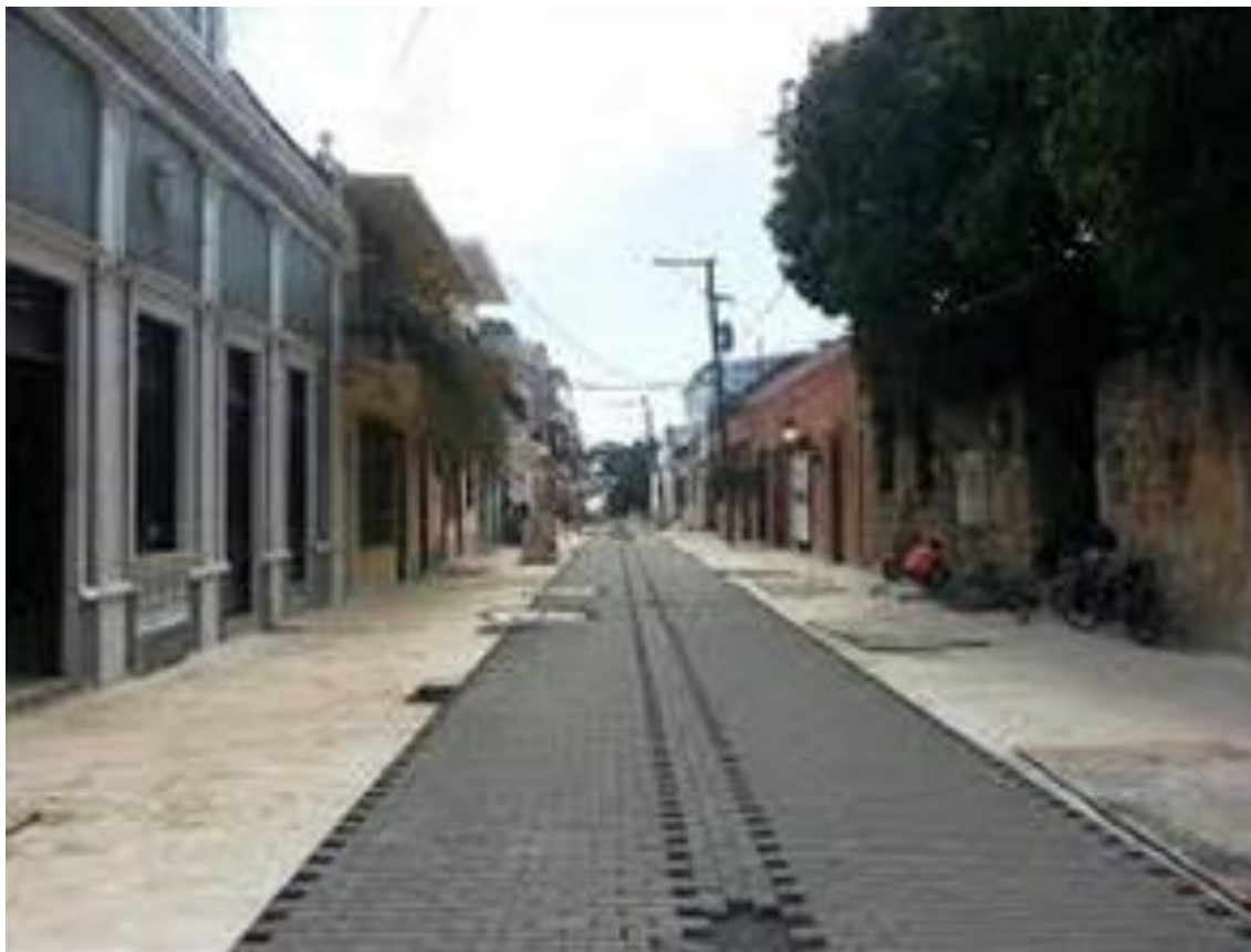
Figura 132. Rehabilitación Urbana fase 1, zona colonial. Fuente: Jemmy Bello (2014)
