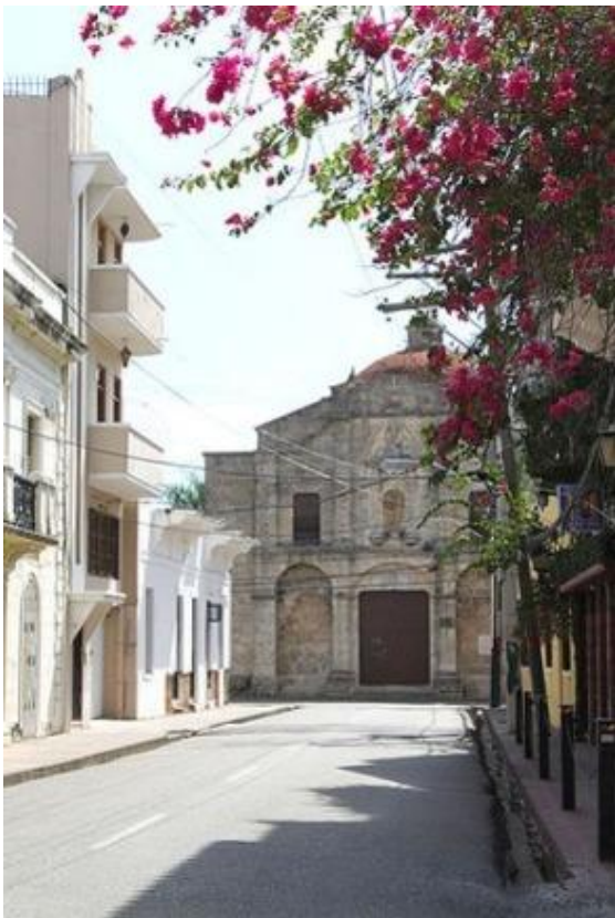
Figura 32. Vista norte del entorno inmediato. Fuente: Johan Almonte (2014)
