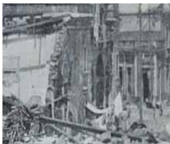
Figura 82. El derrumbe de la edificación muestra el muro de mampuestos y el arco de acceso en la puerta. 1930
