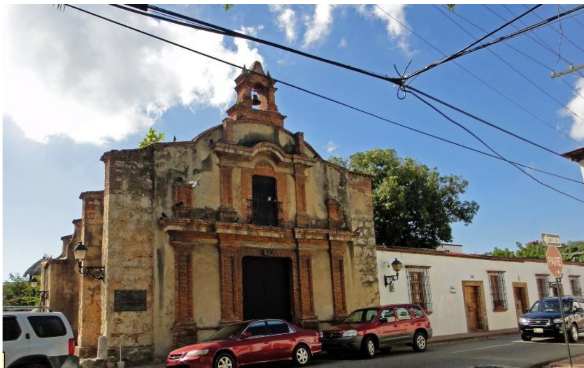
Figura 126. Iglesia la Tercera Orden, fachada frontal, apreciación de patologías y palomas posadas en la fábrica. Fuente: Johan Almonte (2013)
