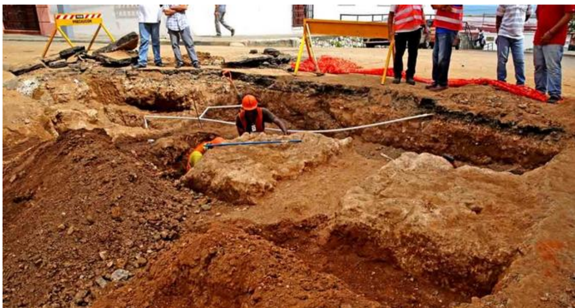
Figura 159. Calle Arzobispo Meriño, área núcleo de la ciudad primitiva, violación de normas. Fuente: http://www.diariolibre.com . Consulta (1/12/2014)
