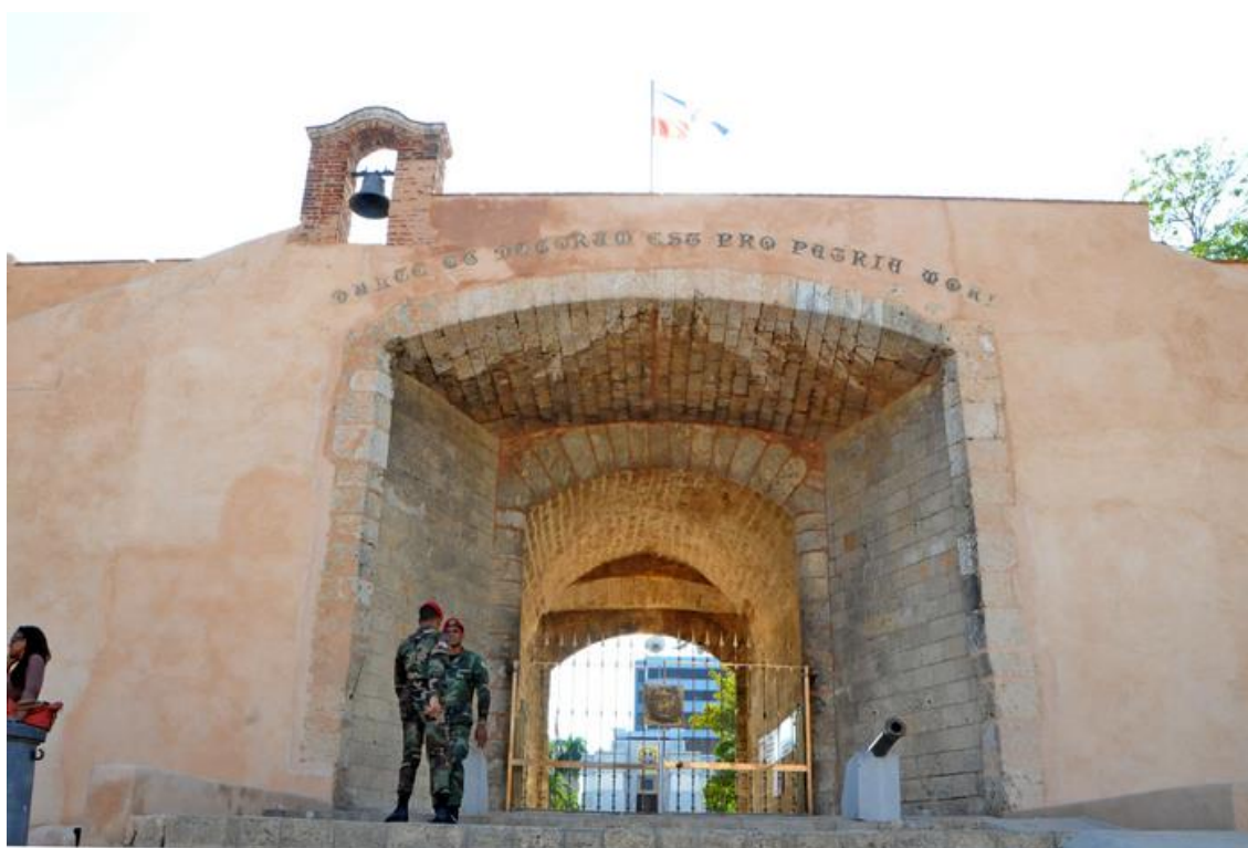
Figura 107. Puerta del Conde, intervención. Fuente: David. F (2014)
