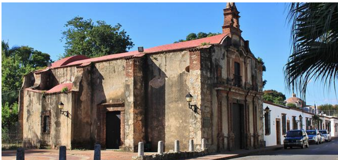
Figura 47. Lateral este vista de Contrafuerte. Fuente: jemmy Bello (2013)
