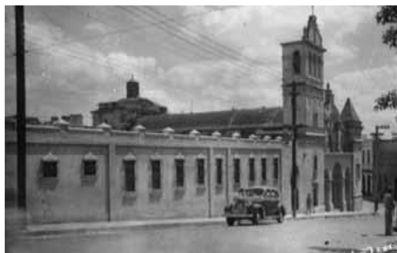
Figura 86. Última construcción anexa a la iglesia realizada por el Ing. Báez López-Penha durante el Gobierno de Trujillo. Nótese el sistema constructivo de vigas y columnas de H. A. demolida a principios de los años de 1970. AGN. Fuente: Icoms Dominicanos 2006
