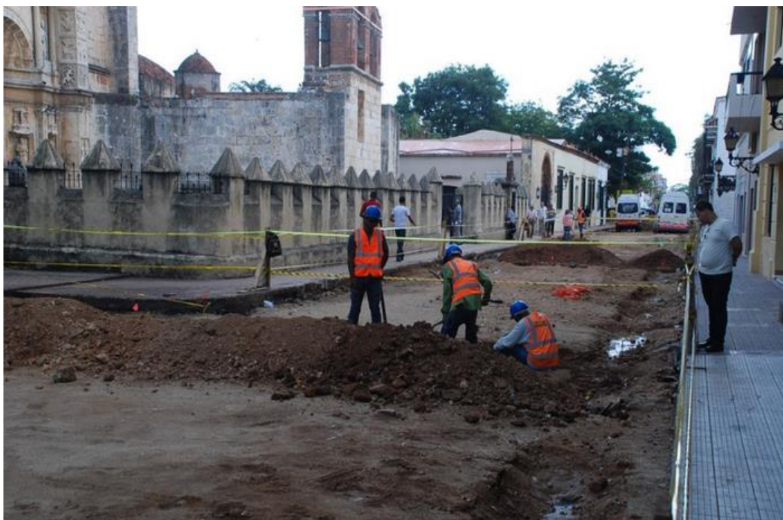
Figura 133. Rehabilitación urbana. Fase 1, zona colonial. Fuente: Jemmy Bello (2014)
