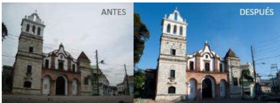
Figura 150. Colaboración en la mejora eléctrica del cableado de la Iglesia Santa Bárbara (2014)
