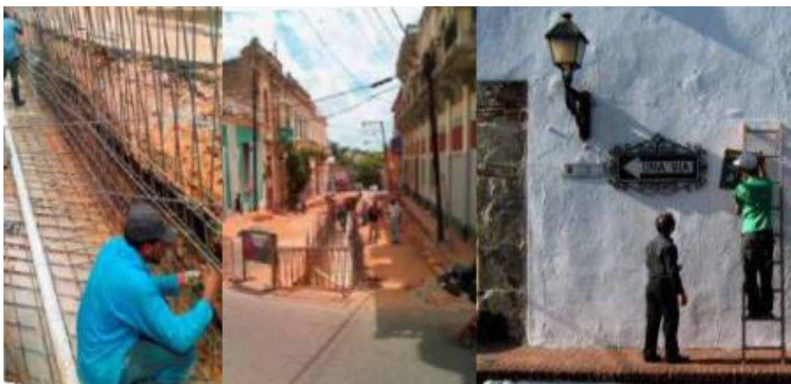
Figura 151. Reparación del hoyo generado por una falla del canal de drenaje pluvial obreros del mismo barrio de Santa Bárbara. Fuente: Proyecto Santa Bárbara (2014)
