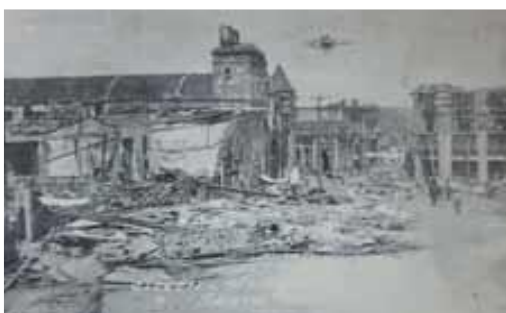
Figura 81. Fotografía de los estragos causados por el ciclón de San Zenón en 1930. Nótese la destrucción total de la escuela y del campanario. Puede verse también la constitución de los muros y el anexo de columnas en concreto en la parte posterior. AGN
