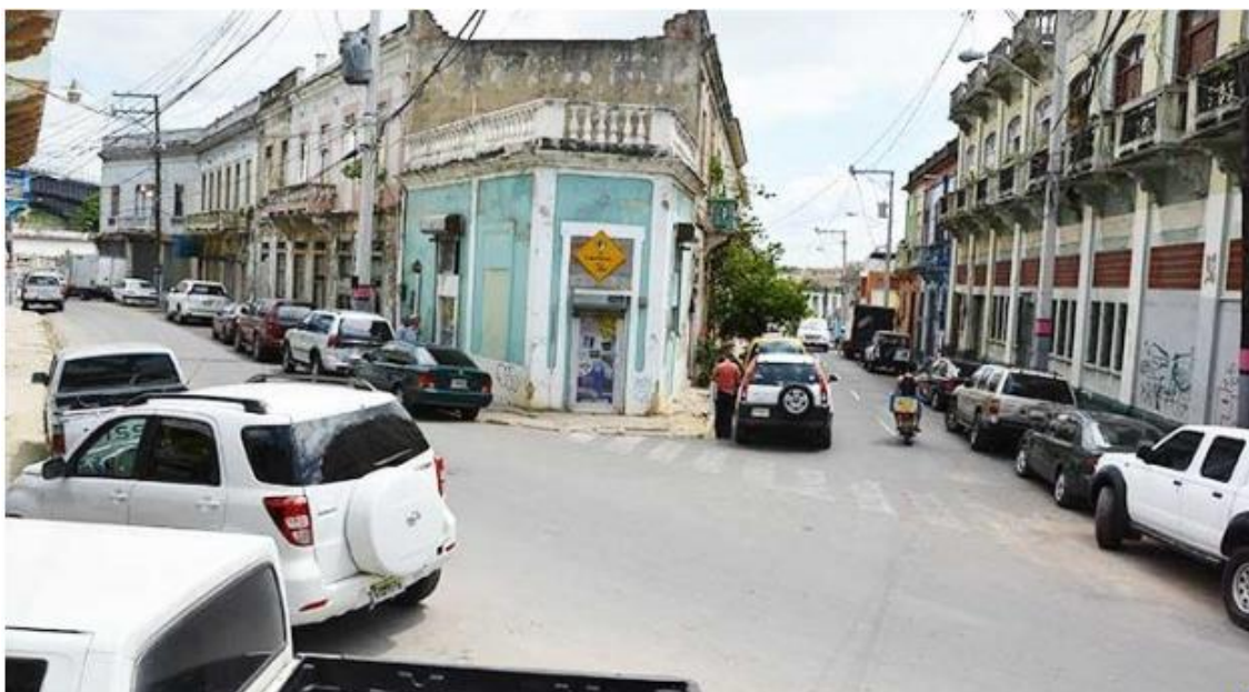
Figura 101. Vista de la barrida de Santa Bárbara tráfico vehicular, mal estado de las edificaciones por emanación del monóxido de carbono. Fuente: Jemmy Bello (2013)
