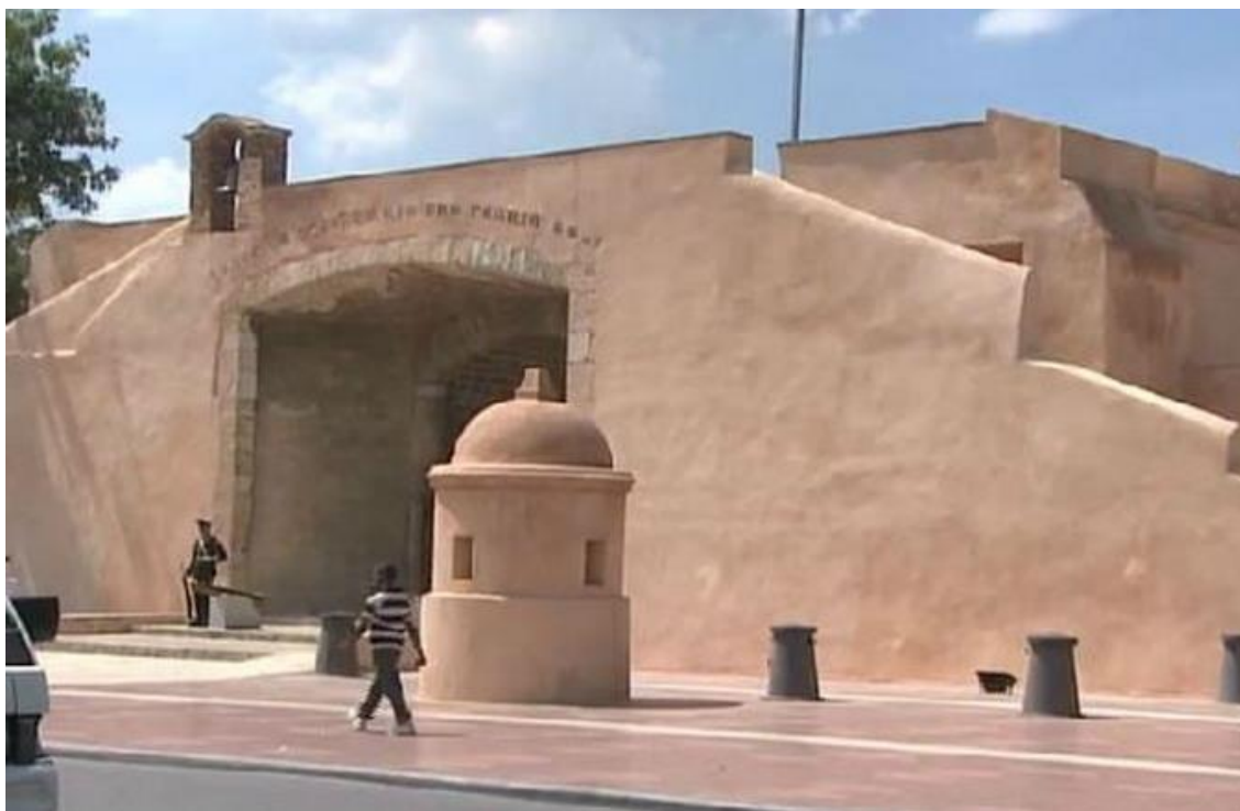
Figura 106. Puerta del Conde, intervención. Fuente: David. F (2014)
