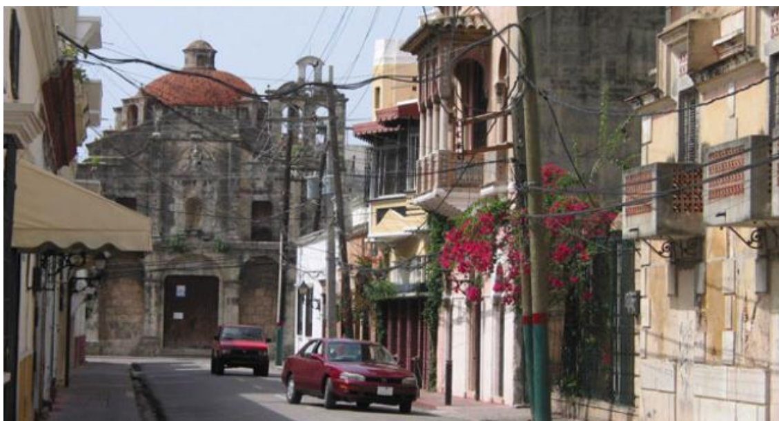
Figura115. Iglesia Regina Angelorum, tendido eléctrico del entorno y estado ruinoso de la fachada, Zona Colonial. Fuente: Johan Almonte (2013)
