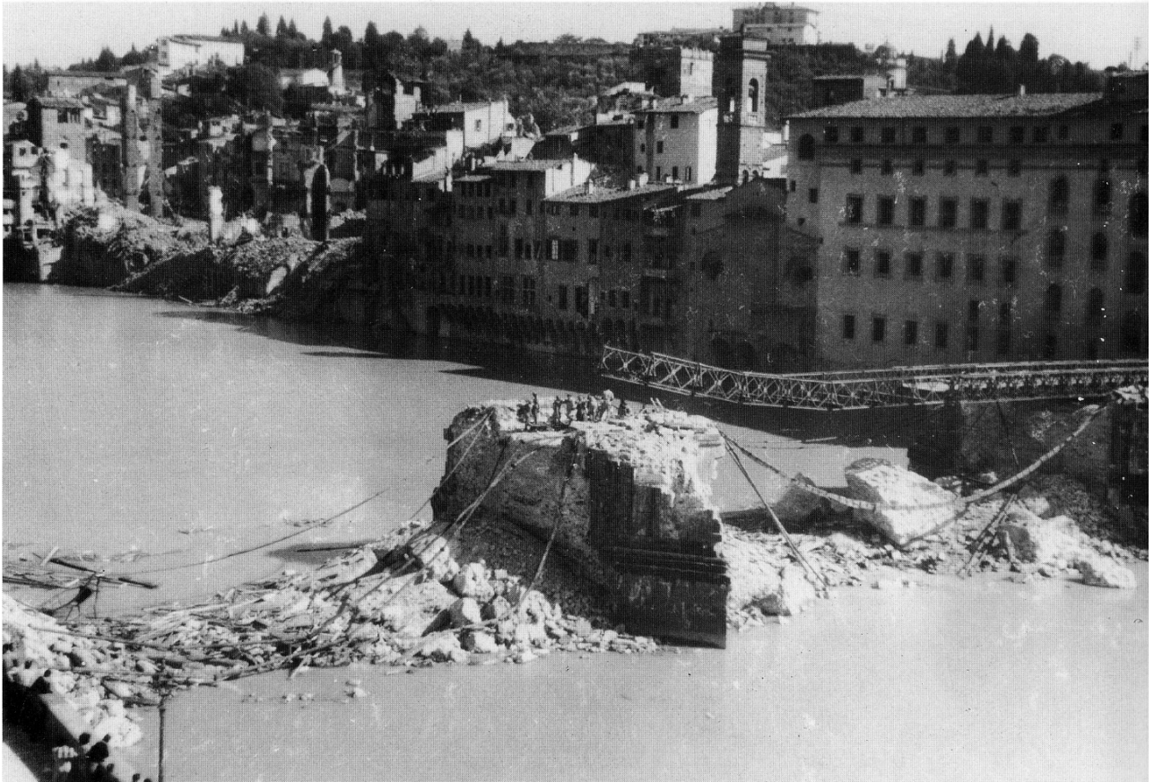
21 Puente de Santa Trinità . Instalación del puente Bailey sobre los restos de las pilas una vez acondicionadas.
