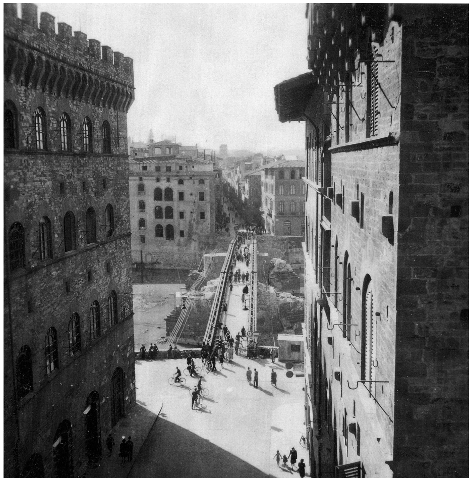
22 Vista del puente Bailey desde la orilla norte.
