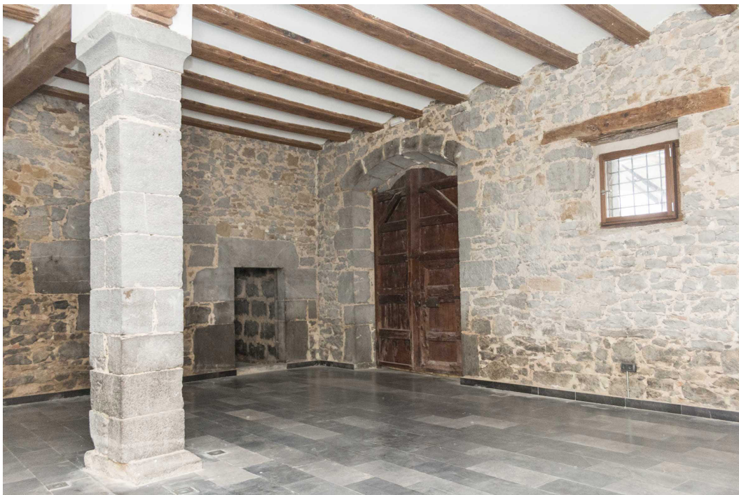
Fig. 45. Vista del pósito.
