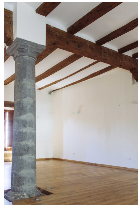
Fig. 71. Intervención en una de las columnas de la Sala Noble.
