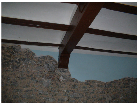
Fig. 70. Mampuesto original de los muros de la Sala Noble.
