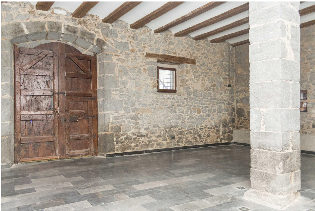
Fig. 56. Interior del pósito.
