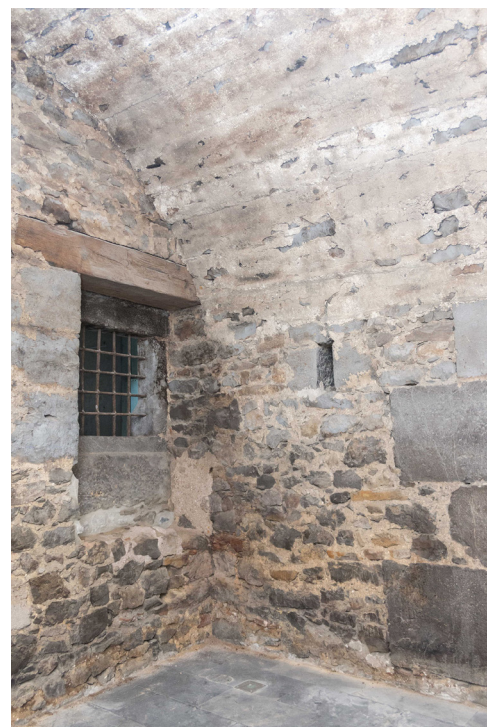
Fig. 52. Bóveda vaída de la cárcel.
