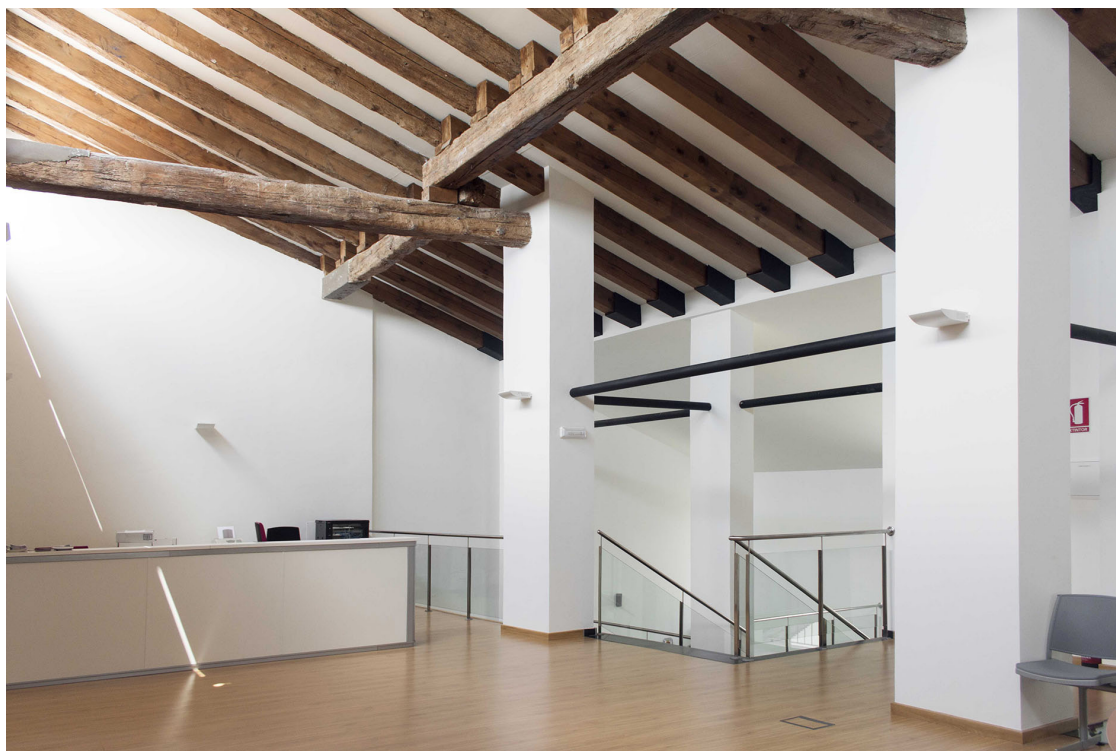
Fig. 63. Vista del núcleo de comunicación añadido en la intervención de la "Cámara".
