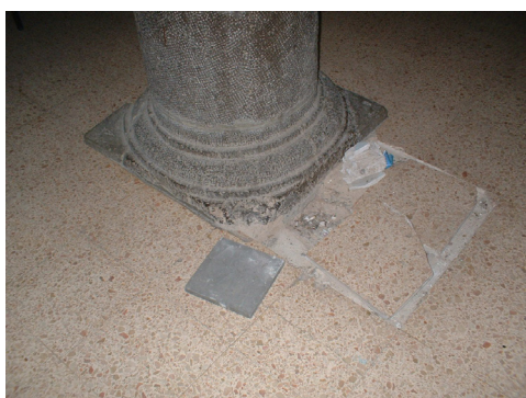
Fig. 69. Base de una de las columnas de la Sala Noble.
