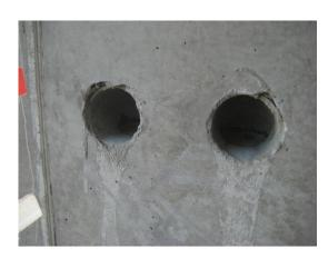
Holes in the columns to pour the concrete
