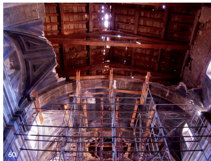
Bóveda - Estado Actual
