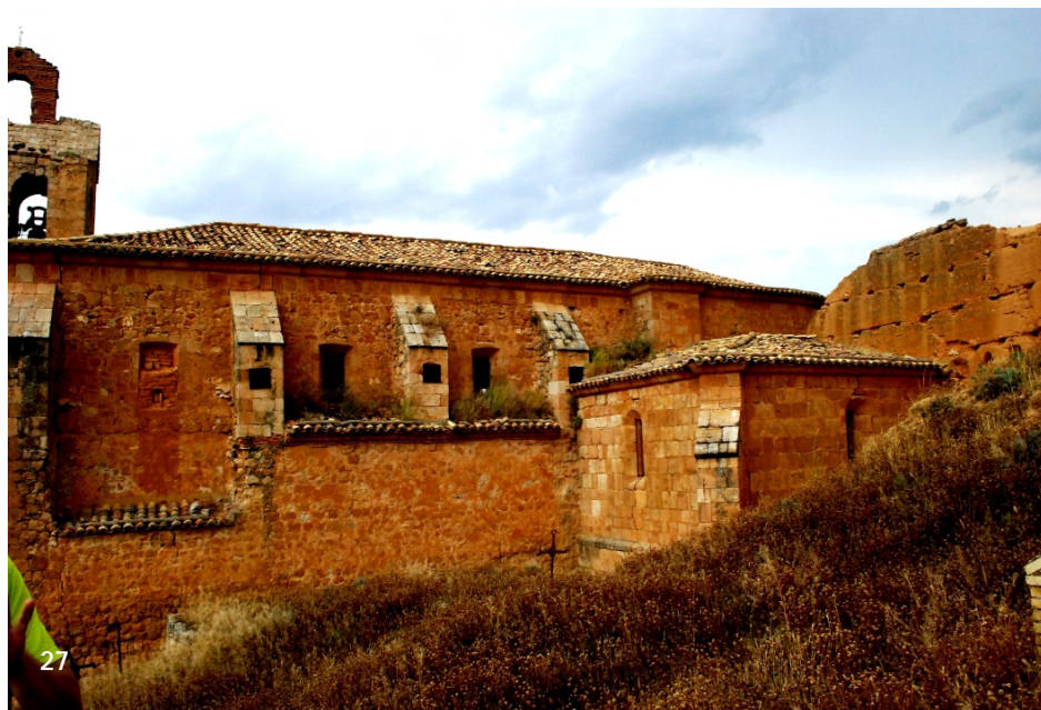
Nivel del suelo por encima del pavimento de la iglesia
