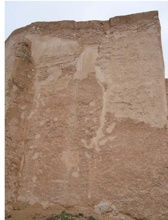
Figura 6.42. Imagen de la reintegración de lagunas realizada en la intervención en el Castillo de Calatayud.
