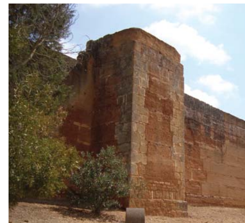
Figura 6.16. Imagen actual de una zona de la Muralla de Niebla en la que aún es posible apreciar el falso despiece de sillería en las superficies.
