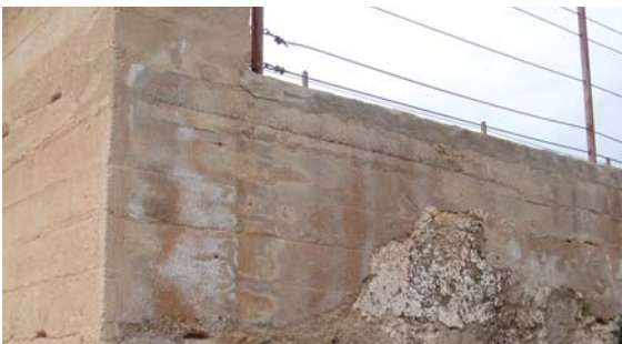
Figura 9.16. Detalle de la sección del muro en el que se aprecia la unión del nuevo material con la preexistencia.
