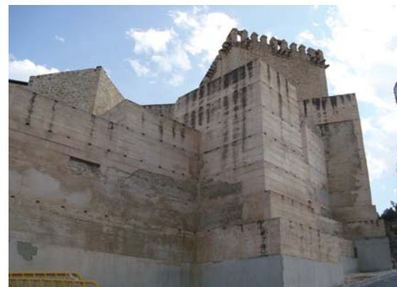
Figura 7.25. Imagen actual del Castillo de Moratalla, donde es posible ver los recrecidos en la coronación con nuevas tapias.
