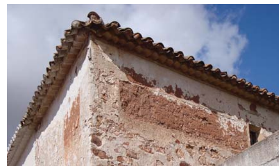
Figura 3.32. Muro de tapia con brencas y rafas de yeso en una vivienda en el Rincón de Ademuz.
