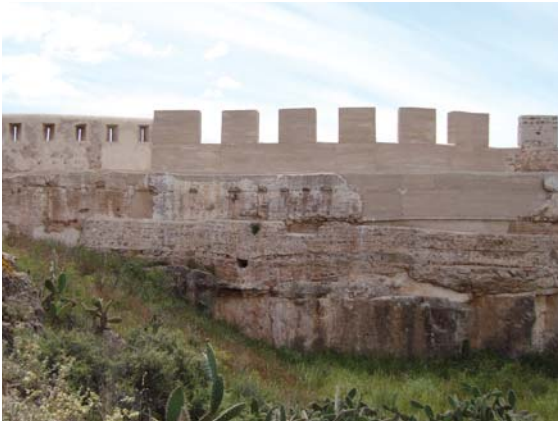
Figura 7.8. Detalle de la intervención en la coronación en uno de los lienzos del Castillo de Sagunto. Ejemplo de reconstrucción de coronación incluso con reconstrucción de almenas.
