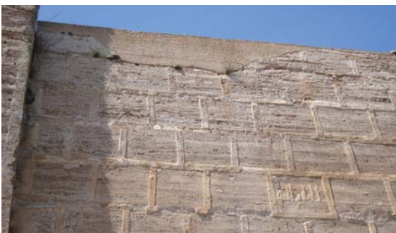
Figura 3.40. Bandas de cal en las juntas simulando sillares en el Castillo de Alcalá de Xivert (Castellón).
