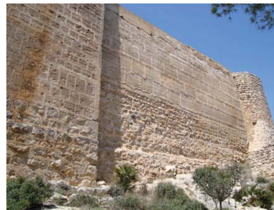
Figura 6.20. Imagen actual de la intervención realizada en el Castillo de Alcalá de Xivert (Castellón).
