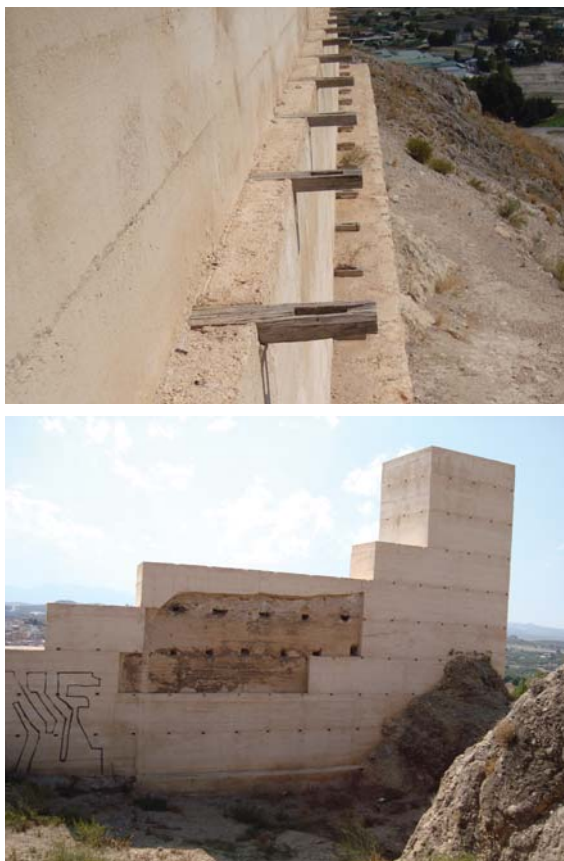
Figura 7.24. Imagen actual de la intervención en el Castillo de San Juan de Calasparra en Murcia. Sup: Imagen de las agujas empleadas en los encofrados de la intervención.
