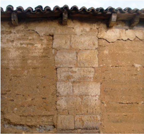
Figura 3.37. Muro de tapia con machones de sillería en Arcediano, Salamanca (V. Cristini).
