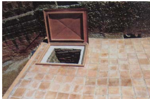
Figura 9.31. Imagen de las trampillas de las cubiertas. Extraída del expediente A97.0050E.23BC del archivo de la Consejería de Cultura de la Junta de Andalucía.
