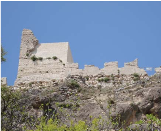
Figura 8.8. Imagen actual del Castillo de Moclín en la que se puede ver la vegetación en la coronación de los muros.
