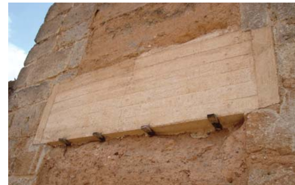
Figura 7.19. Imagen de detalle de la construcción de una nueva tapia adosada al material original en una de las torres de la Muralla de Niebla. En este caso se han dejado las agujas propias del encofrado.
