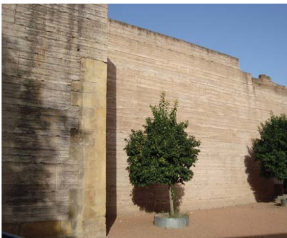
Figura 7.22. Imagen actual de la intervención en el Castillo de la Judería de Córdoba.
