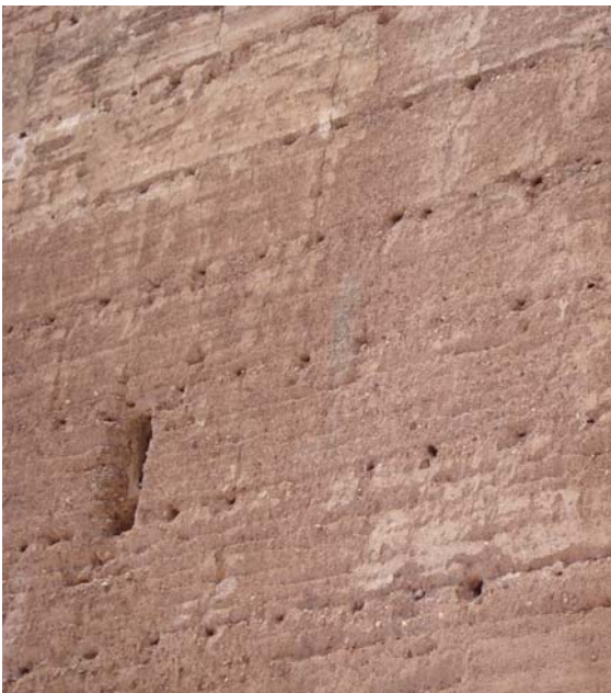
Figura 3.22. Imagen de los muros de tapia de la Muralla de Aledo (Murcia).
