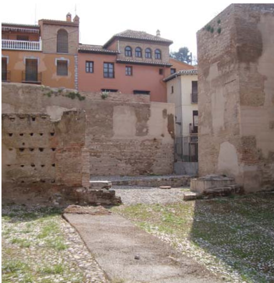
Figura 6.39. Imagen de la intervención en la Puerta de Elvira de la Muralla de Granada.
