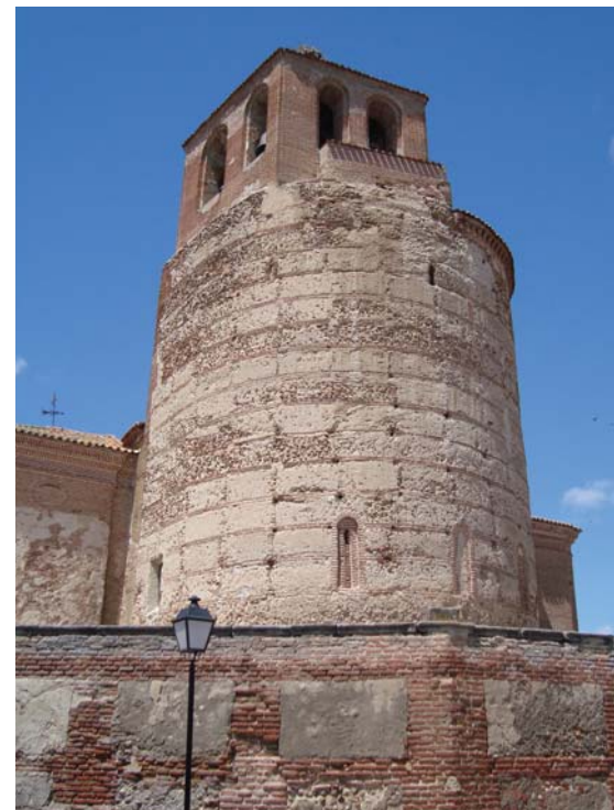
Figura 3.38. Muros circulares de tapia con verdugadas de ladrillo en la Iglesia de Barrroman (Ávila).
