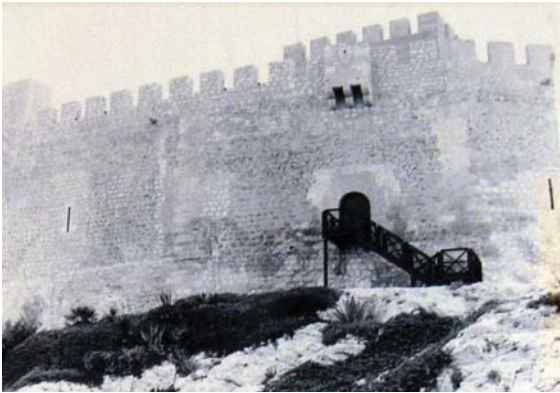
Figura 9.14. Imagen antigua posterior a la restauración de 1982 en la que se puede apreciar la escalera metálica del acceso. Imagen expuesta en el museo actual que existe en el castillo.
