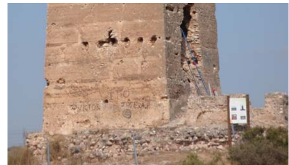
Figura 3.45. Construcción de una torre de tapia sobre una plataforma de mampuestos compactada que protege los muros del mecanismo de subida de agua por capilaridad. (Torre Bofilla, Bétera).
