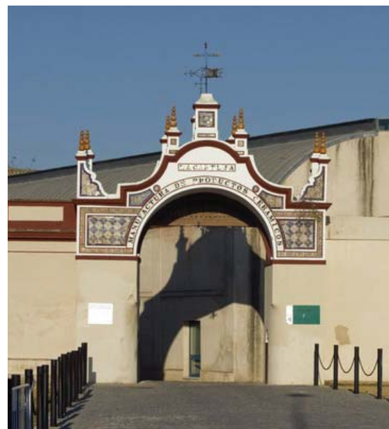
Figura 4.12. Imagen del acceso al Instituto de Patrimonio Histórico Andaluz.
