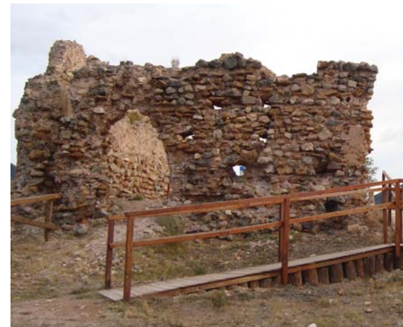
Figura 3.24. Muro de mampostería encofrada en el Castillo de Almonecir (Castellón).
