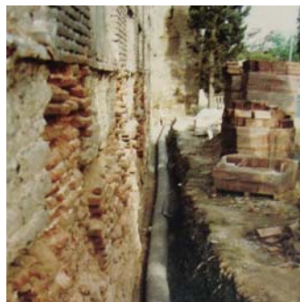
Figura 9.54. Imagen de la apertura de la zanja de drenaje durante la realización de la obra. Expediente PI 0829.02 del archivo del IPCE.
