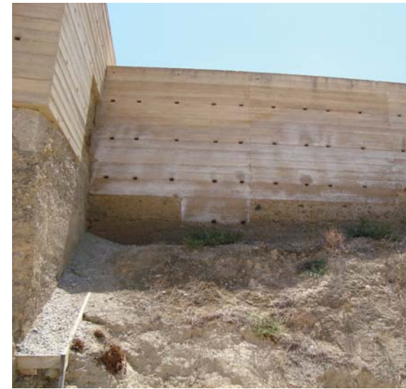
Figura 8.17. Imagen actual del Castillo de Nogalte en la que se aprecian las manchas y eflorescencias de sales propucidas por el agua que asciende por capilaridad.
