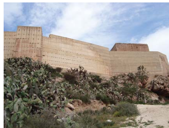
Figura 9.5. Imagen actual del lienzo sur en la que se distinguen dos intervenciones: la obra de principios de los 90 a la izquierda de la imagen y la de principios del 2000 a la derecha, trabadas entre sí con una junta escalonada que corresponde a las diversas tapiadas. Se observan también las agujas perdidas de los encofrados..
