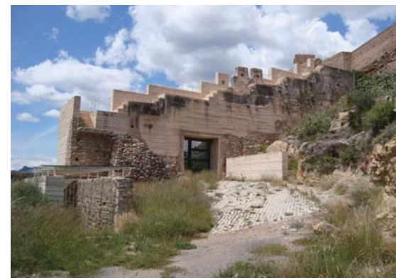
Figura 7.11. Imagen actual de la intervención en la coronación en una zona del Castillo de Sagunto. Ejemplo de reconstrucción de la coronación de forma escalonada, incluso con la reconstrucción de alguna almena.
