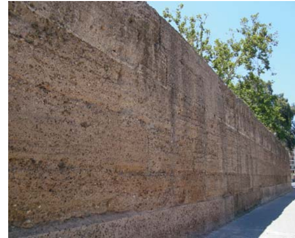
Figura 3.23. Muro de tapia con añadido de cal en la masa (tapia real) de la Muralla urbana de Sevilla.
