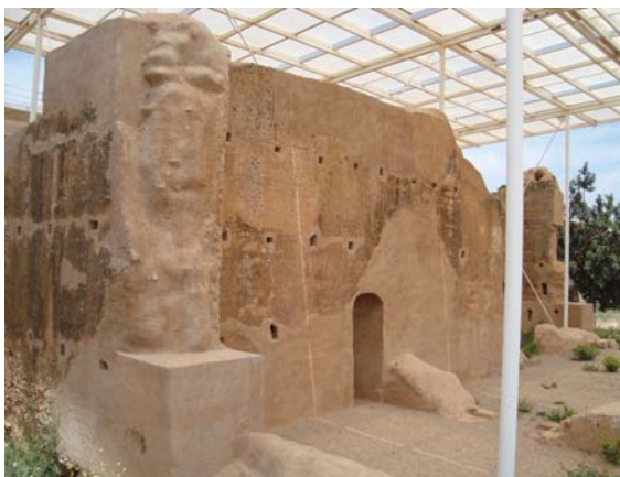
Figura 6.29. Imagen actual de la Castlania de Cambrils después de la Intervención.
