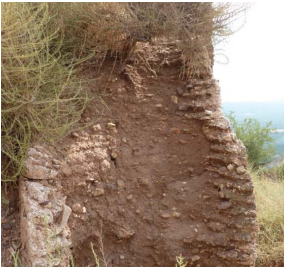
Figura 3.52. Ejemplo de proceso de abombamiento y lavado del núcleo por infiltración de agua (Castillo de la Vilavella en Nules, Castellón).
