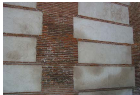
Figura 9.53. Imágenes de los trabajos en la coronación del muro. Sup: limpieza de los materiales disgregados. Inf: ejecución de la cumbra y pendientes del nuevo tejado de la muralla. Expediente PI 0829.02 del archivo del IPCE.
