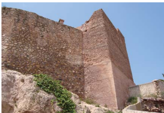
Figura 6.19. Imagen actual de la intervención realizada en la Muralla de Aledo (Murcia).
