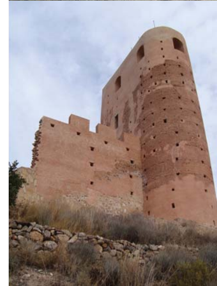
Figura 9.60. Iz: Imagen antes de la intervención, se aprecia las zonas inferiores de la torre que han perdido la capa superficial (web del Ministerio de Fomento). Der: Imagen actual tras la intervención.
