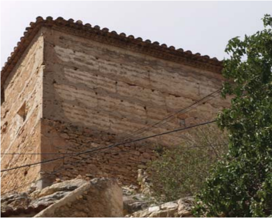
Figura 3.33. Muro de tapia con brecas y rafas de yeso careada con piedras en Castielfabib, el Rincón de Ademuz.
