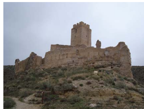
Figura 6.30. Imagen actual del Castillo de Cadrete después de la Intervención.
