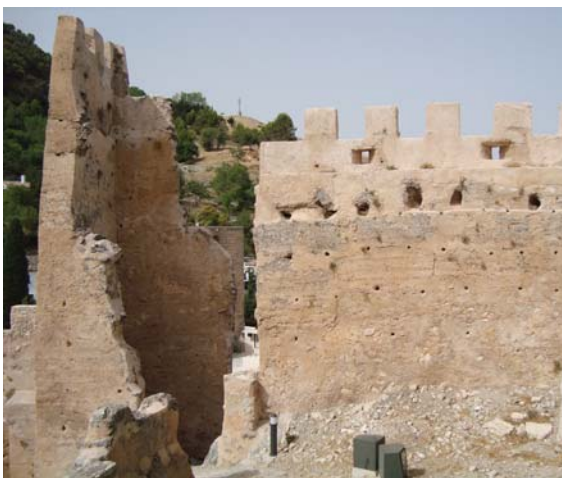
Figura 9.69. Estado actual de la zona interior de la muralla oeste tras la intervención donde se aprecia las actuaciones de consolidación y reintegración.
