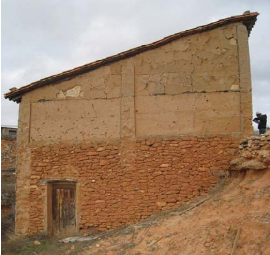
Figura 3.26. Muro encofrado de yeso en una vivienda en el Rincón de Ademuz. En la parte superior muro conoconfrado a una cara con lajas de piedra
