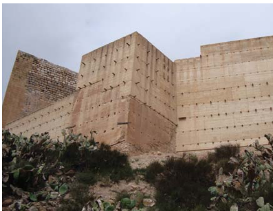
Figura 6.11. Imagen de la intervención en el Castillo de La Mola en la que puede verse que las nuevas tapias apoyan sobre una superficie plana de trabajo.
