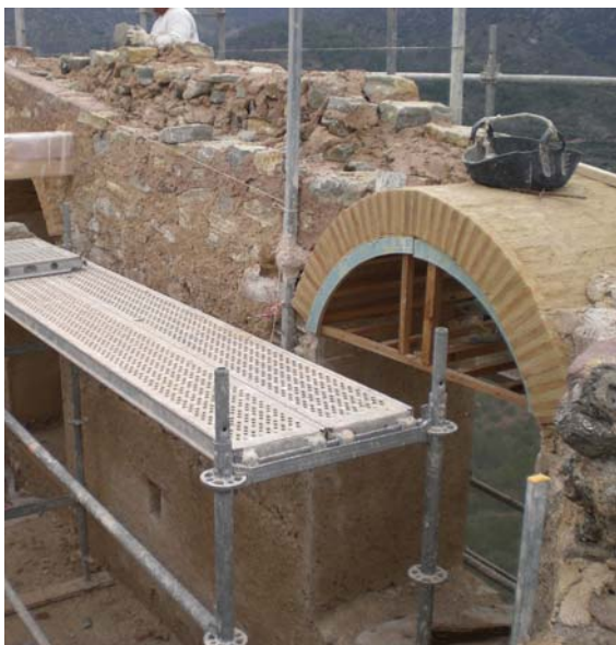
Figura 9.63. Imagen de la fase de reconstrucción de la coronación de la torre y los huecos preexistentes (web del Ministerio de Fomento).
