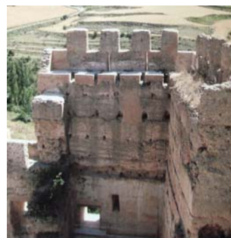
Figura 7.13. Detalle de la intervención en la coronación en el Castillo de Yanguas, en la que se han ejecutado nuevas tapias adosadas a la preexistencia. Expediente PI 1109.
