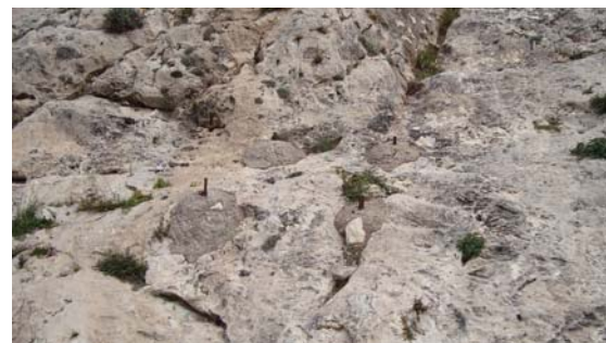
Figura 9.11. Detalle de los anclajes ejecutados en la loma del castillo.
