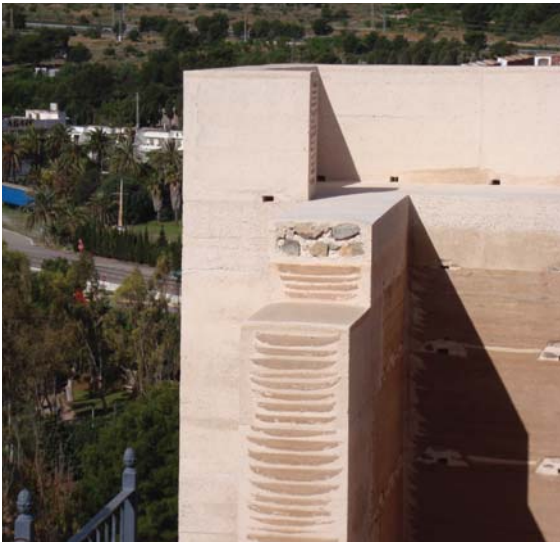
Figura 7.33. Imagen de la intervención en el Castillo de Oropesa del Mar, en el que se han construido los nuevos muros con tapias calicostradas, siguiendo la variante constructiva original.
