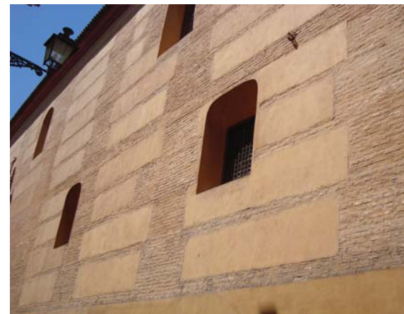
Figura 3.36. Muro de tapia con machones y verdugadas de ladrillo en el Convento de la Madre de Dios en Sevilla.
