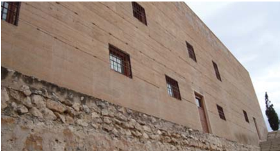
Figura 9.15. Imagen actual de la muralla exterior del castillo.
