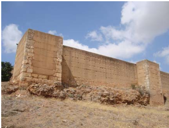
Figura 7.9. Imagen actual del sector correspondiente a la tercera fase de la intervención en la Muralla de Niebla a la que corresponde el detalle de coronación analizado en la figura 7.10.
