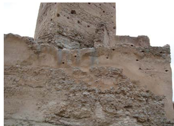
Figura 7.26. Imagen actual del Castillo de Cadrete, donde es posible ver las consolidaciones en las coronaciones de los muros.
