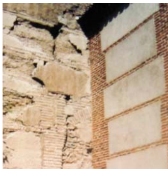
Figura 9.56. Imagen de la zona intervenida de la muralla con la no intervenida. Expediente PI 0829.02 del archivo del IPCE.
