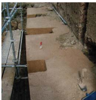
Figura 7.15. Imagen del estado actual de la coronación de una de las torres del Castillo de Yanguas después de realizar trabajos de consolidación en la coronación. Expediente PI 1109.
