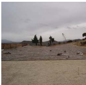
Figura 9.21. Imagen del proceso de pavimentación de la explanada (base de datos del Ministerio de Fomento).
