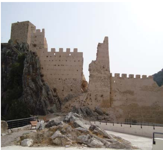
Figura 9.68. Estado actual de la muralla oeste tras la intervención donde se aprecia la recuperación de las almenas, y el mantenimiento del perfil original de la coronación en las zonas más degradadas.
