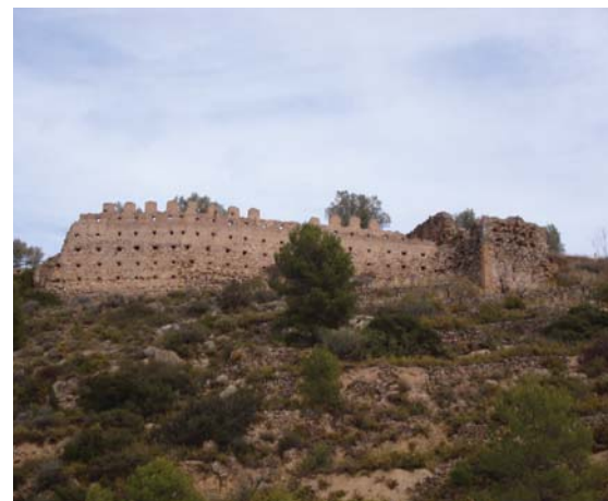
Figura 9.58. Imagen de la muralla exterior y de los restos de una de las torres, construidos con tapia de piedra o mampostería encajonada.
