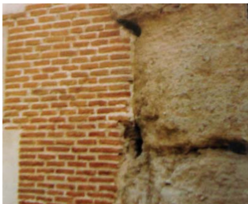
Figura 9.51. Detalle de la fábrica de ladrillo después de la intervención y la tapia original. Expediente PI 0829.02 del archivo del IPCE.
