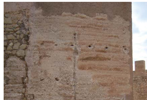
Figura 9.18. Detalles de algunas de las zonas de la Torre del Homenaje que se han consolidado y reintegrado con mortero de cal coloreado.
