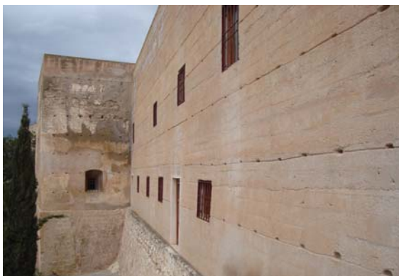
Figura 6.18. Imagen actual de la intervención realizada en la muralla del Castillo de Petrel (Alicante).
