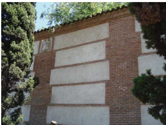
Figura 6.21. Imagen actual de la intervención realizada en la Muralla de Alcalá de Henares.
