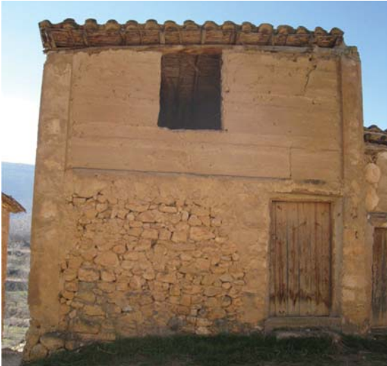
Figura 3.25. Muro encofrado de yeso en una vivienda en el Rincón de Ademuz, con pilares monolíticos de yeso ciclópeo.
