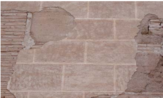
Figura 3.39. Muros de tapia entre machones y pilares de ladrillo ocultos por un enlucido con sillería fingida en el Monasterio de Los Jerónimos en La Ñora (Murcia).
