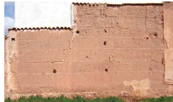
Figura 3.30. Muro de tapia con juntas horizontales en Villanueva de los Infantes (Ciudad Real).
