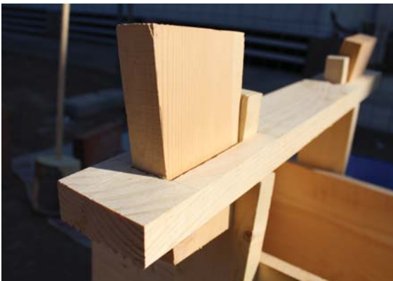
Figura 3.17. Detalle del encuentro entre la aguja superior, el costal y la cuña, siendo los tres elementos de madera.
