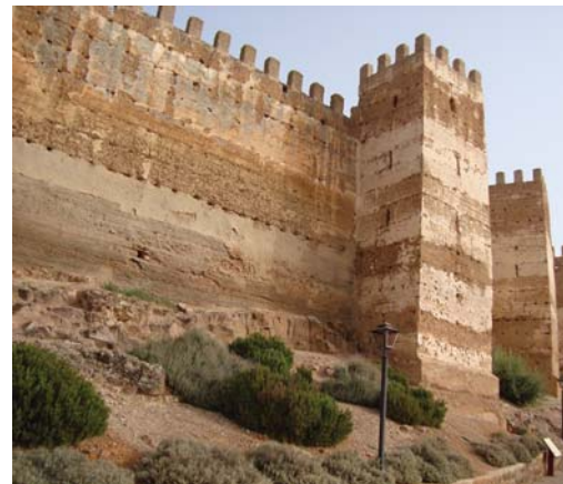
Figura 9.38. Imagen actual de los lienzos de muralla en las que se detectan intervenciones puntuales de reintegración de superficies.
