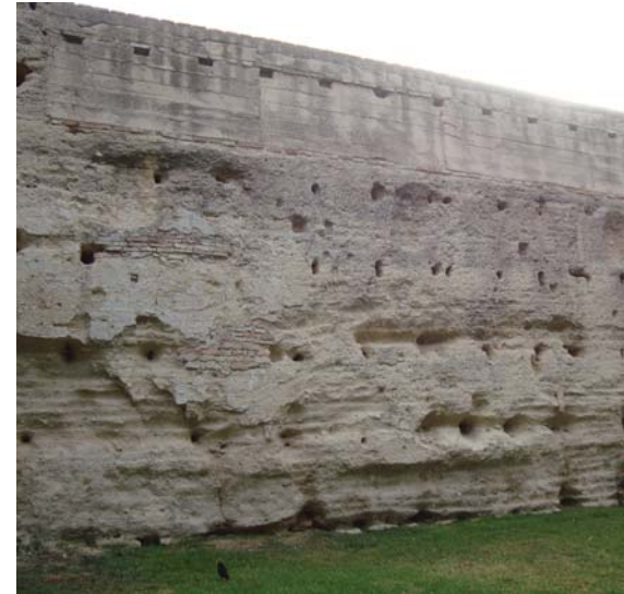
Figura 3.62. Ejemplo de degradación a partir de los mechinales de las agujas (Alcazar de Jerez de la Frontera).
