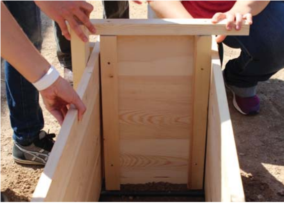
Figura 3.16. Imagen de la colocación de la frontera del tapial y su encuentro con las tablas y los costales.
