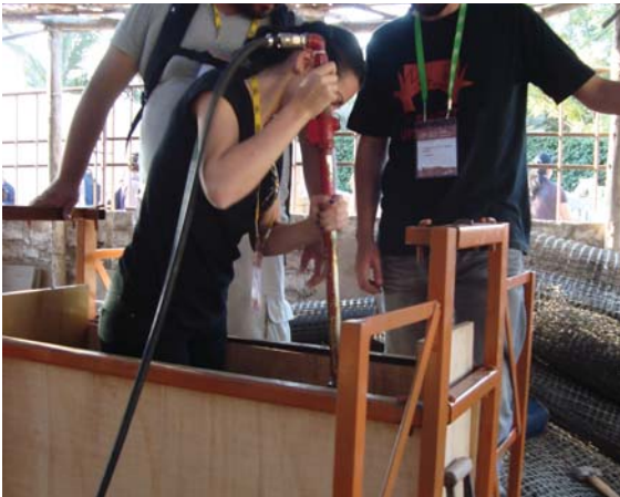
Figura 3.20. Ejecución de un muro de tapia con pisón mecánico durante los talleres del XII Seminario Iberoamericano de Arquitectura y Construcción con Tierra (SIACOT2012) en Lima, Perú.
