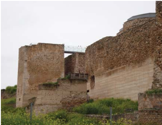
Figura 7.16. Imagen actual del Castillo de Calatrava la Vileja en Carrión de Calatrava. Intervención en la que se ha dejado el encofrado empleado en la misma a modo de ejemplo.
