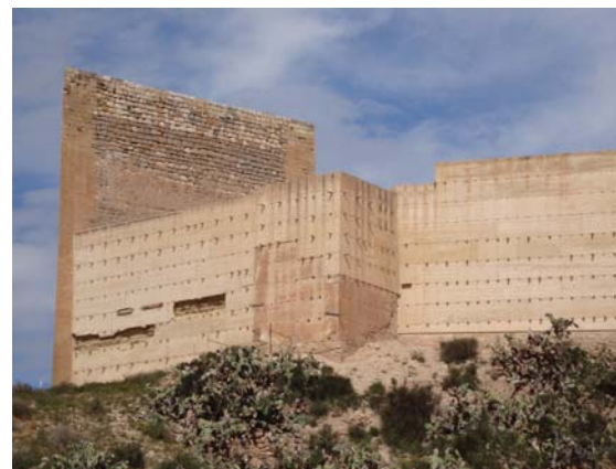
Figura 9.9. Imagen actual del lienzo sur en el que se han desprendido algunas tapiadas propias de la intervención de principios de los años 90.
