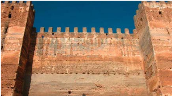
Figura 9.30. Imagen del lienzo del muro entre los torreones 3 y 4 previa al proyecto. Extraída del expediente I06.2117.23 del archivo de la Consejería de Cultura de la Junta de Andalucía.
