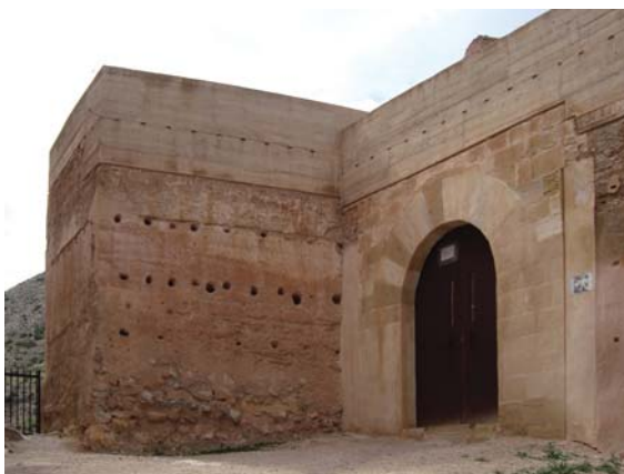
Figura 9.8. Imagen de la puerta sureste de entrada a la fortaleza después de la intervención de los años 2000.
