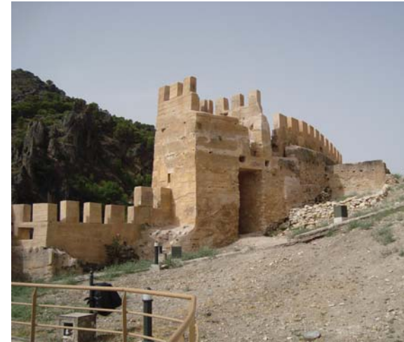
Figura 9.70. Imagen del estado actual de las coronaciones en el Castillo de la Iruela.
