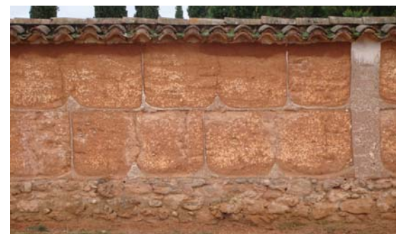
Figura 3.31. Muro de tapia con brencas de yeso en el cementerio de Torrebaja (El Rincón de Ademuz).
