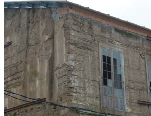
Figura 3.35. Muro de tapia con verdugadas y trabazón de madera en las esquinas.
