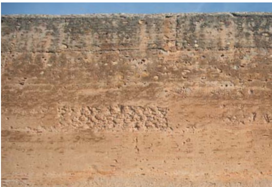
Figura 3.29. Muro de tapia en la Muralla de Mascarell (Castellón). Las hiladas superiores son de tapia careada con piedra y las inferiores son de tapia valenciana.
