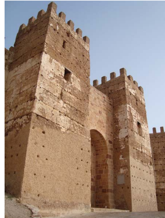
Figura 9.40. Imagen actual del acceso en la que se puede ver la intervención realizada en las bases de los torreones en 1997.
