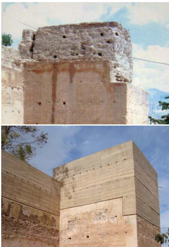
Figura 9.6. Imágenes de una de las torres antes y después del “Proyecto de Restauración del Castillo de la Mola, Novelda (2ª Fase)” realizado durante 2001 y 2002. (sup: imagen del expediente 00-0012-PA.).
