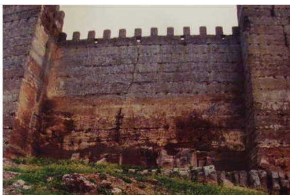
Figura 9.27. Imagen exterior del Castillo de Burgalimar previa a la intervención de 1997. Expediente A97.0050E.23BC del archivo de la Consejería de Cultura de la Junta de Andalucía.
