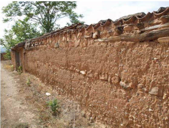
Figura 3.34. Muro de tapia con verdugadas de piedra en el Rincón de Ademuz.
