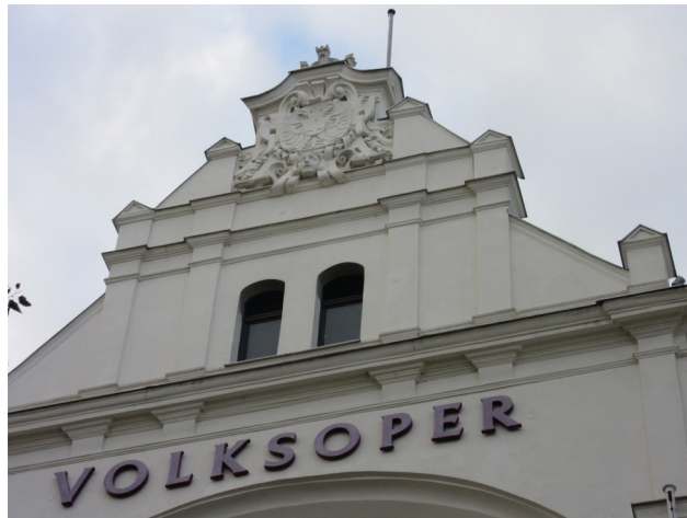
Fig. 126. Detalle de fachada de la Volksoper.
