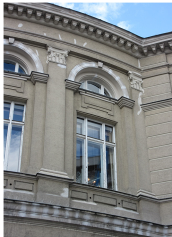
Fig. 157. Detalle de fachada del Raimund.
