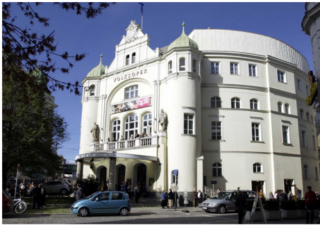
Fig. 146. Fachada principal de la Volksoper.
