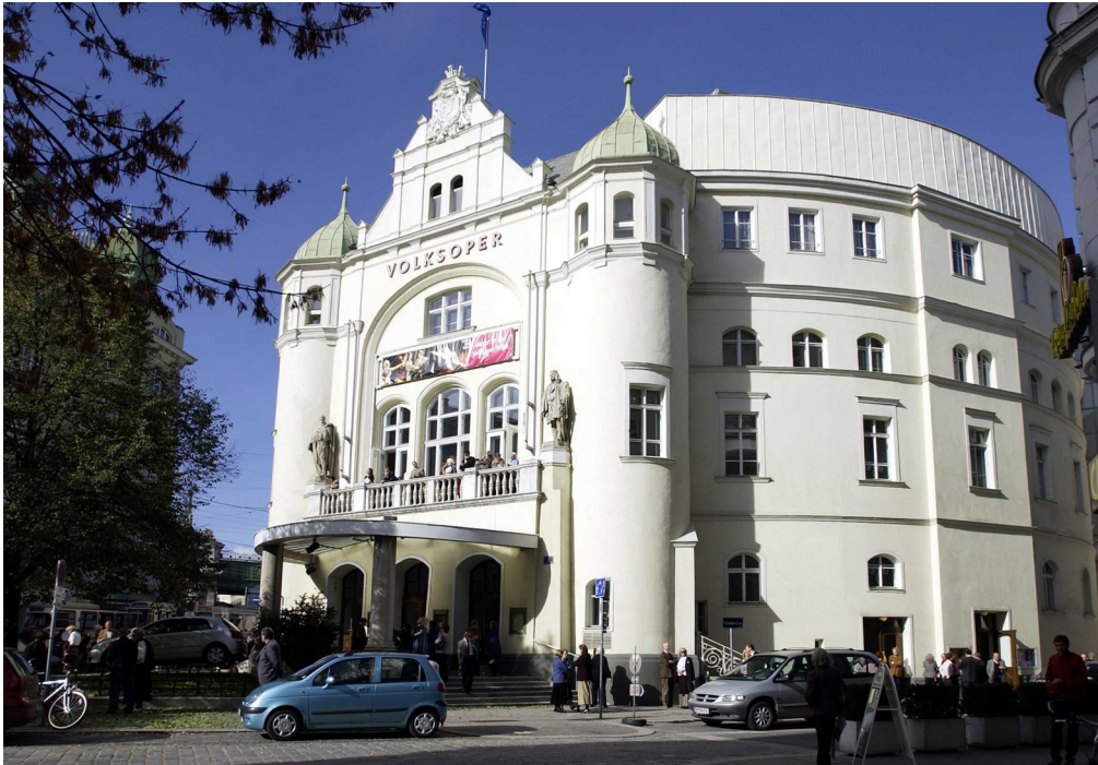
Fig. 124. Vista general de la Volksoper desde Währinger Gürtel.
