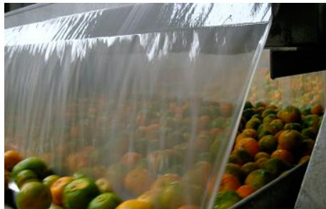
Ilustración 19 : Drencher de la marca Citrosol que usa Kanama Group.
