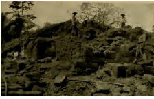
fig. 35 Excavación edificio A Fotografía de Sylvanus G. Morley. MORLEY 1913.:353
