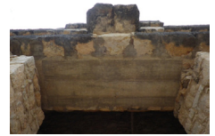
fig. 216 Edificio 1 Dinteles de hormigón en el acceso Nuria Matarredona, 2011
