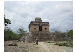
fig. 211 Edificio 1 Nuria Matarredona, 2011
