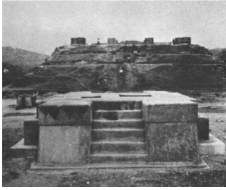
fig. 202 Edificio 11. Estado previo y posterior a los trabajos de 1946. Al fondo, el templo 1. S. H. BOGGS 1946.:18
