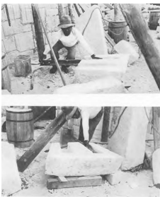
fig. 91 El Caracol. Colocación de las barras de acero en las ranuras esculpidas en las piezas de moldura 1926. RUPPERT 1935B.:figs.212-213
