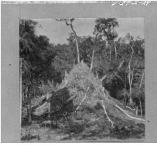
fig. 130 Edificio E-VII. Fachada este. Estado previo a la investigación. 1927. Archivos del Peabody Museum. 58-34-20/58862
