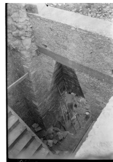
fig. 82 Templo de los Guerreros. Galería hacia el sub-edificio. Pueden apreciarse la escalera, viga y bóveda de nueva construcción 1928. Archivos del Peabody Museum. 58-34-20/32148
