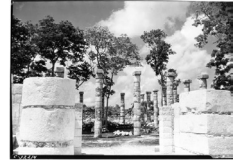
fig. 108 El Mercado. Detalle de la restauración de las columnas, presentando rajueleado en las juntas para diferenciar las piezas recolocadas de las originales Julio 1932. Archivos Peabody Museum. Colección CIW. 58-34-20/33463
