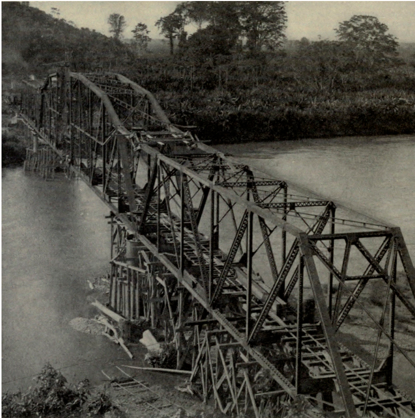
fig. 43 Construcción de la vía de tren a Quiriguá. 1914 ADAMS 1914:110
