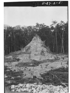
fig. 132 Retirada del edificio E-VII. Vista NE 1928. Archivos del Peabody Museum. 58-34-20/58915.1
