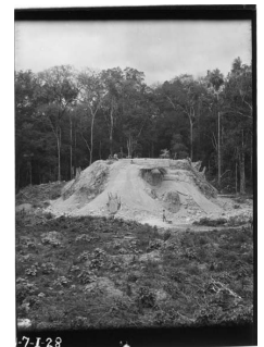
fig. 133 Retirada del edificio E-VII. Vista NE 1928. Archivos del Peabody Museum. 58-34-20/58921
