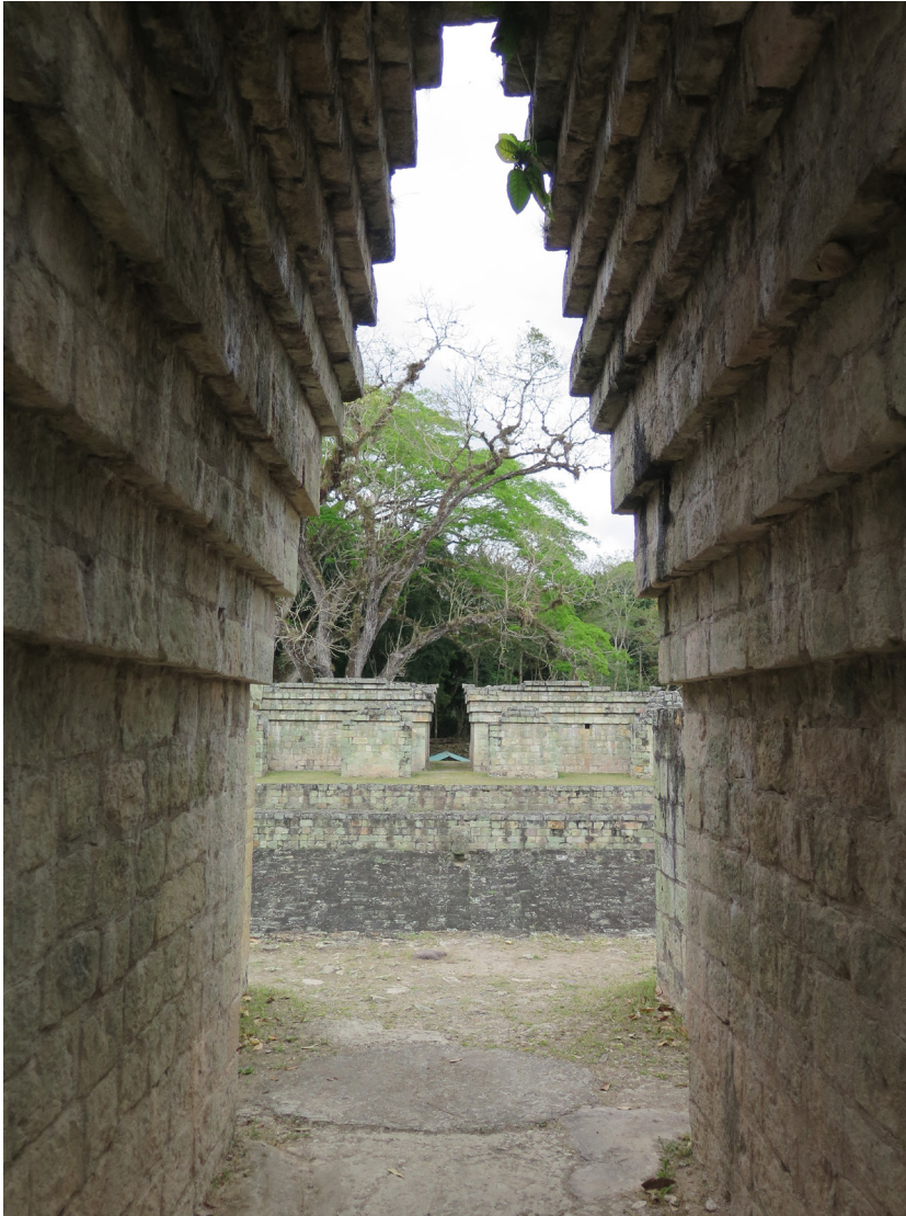
fig. 190 Bóveda edificio Este. Vista hacia Oeste. Fotografía de Laura Gilbert, 2015
