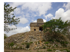
fig. 213 Edificio 1. Fachada posterior sin restaurar Nuria Matarredona, 2011
