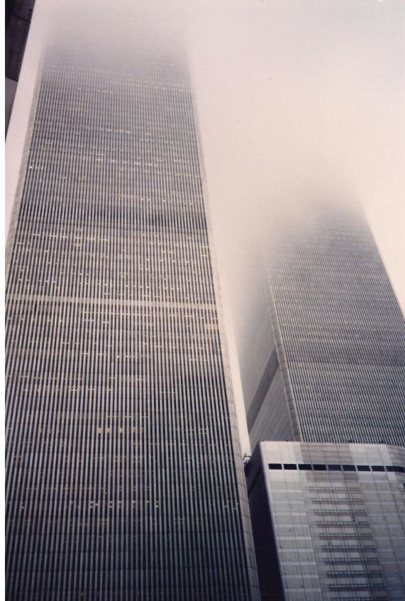
Figura 1.6: Vista de las Torres Gemelas desde la plaza del World Trade Center (Fuente: propia)
