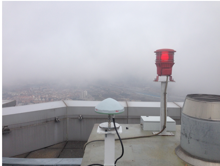
Figura 6.35: Antena GNSS 1 sobre pilar metálico en la azotea de Torre Espacio (Fuente: propia)
