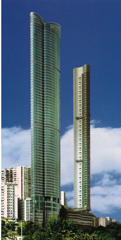
Figura 1.11: El edificio residencial “Highcliff” con su esbelta figura domina la bahía de Hong Kong (Fuente: TERRANOVA, A. y SPIRITO, G. 2008)
