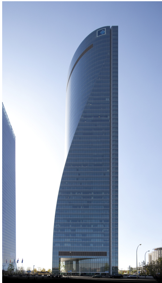
Figura 6.2: Torre Espacio: fachada Este (Fuente: www.torreespacio.com )
