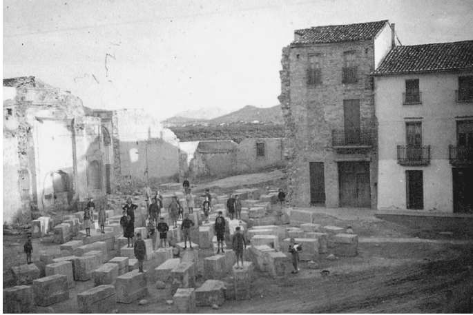
Imagen [10], [11] y [12]: Construcción iglesia actual. Las piedras para su cimentación fueron sacadas de la demolición de un puente de Gandía. Como vemos la estructura es de cerchas metálicas. Por último el resultado final al acabar la construcción.
