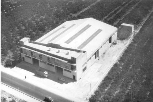
Imagen [04]: Uno de los almacenes de naranja. Concretamente la Cooperativa Agrícola. Construida en 1964 y en la actualidad activo.
