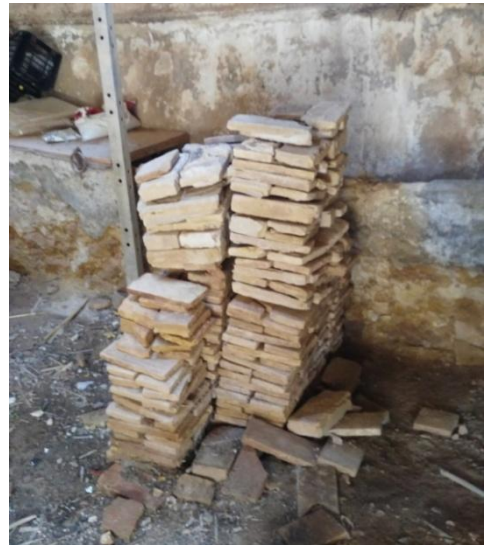
Ilustración 65. Acopio rasilla desmontada, Fuente: Propia.
