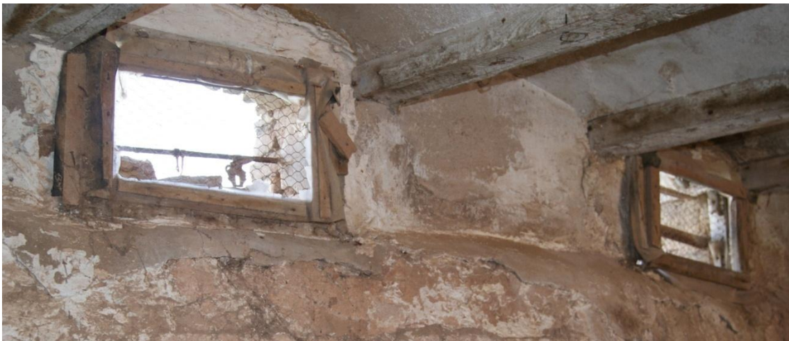
Ilustración 62. Marcos de madera en muro original. Fuente: Propia autora.
