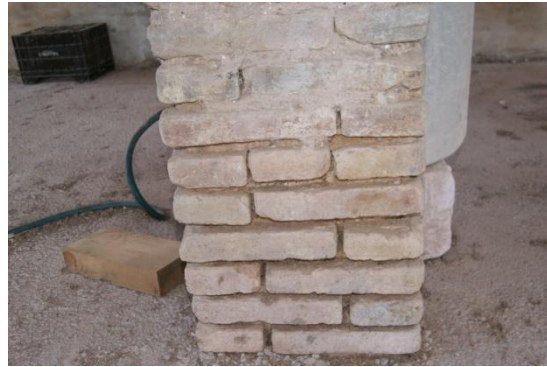
Ilustración 51. Encuentro pilar-viga Fuente: Propia. Ilustración 52. Base de pilar cerámico. Fuente: Propia.
