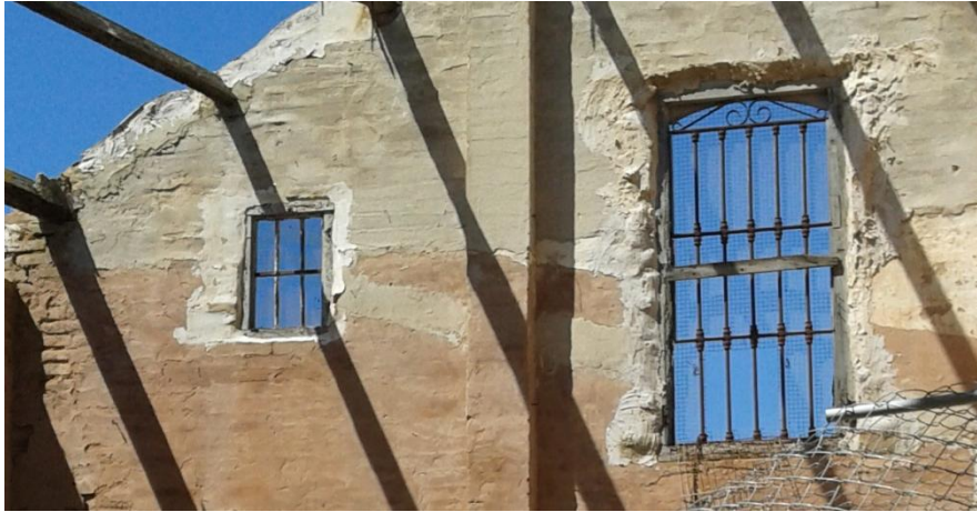
Ilustración 63. Rejas en muros originales.
