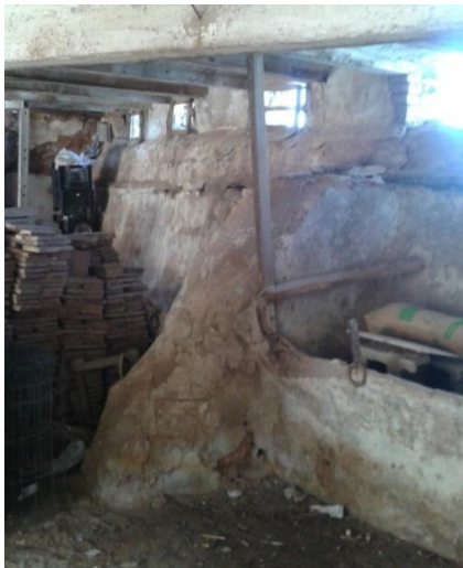
Ilustración 49. Contrafuertes en muro de carga. Fuente: Propia autora
