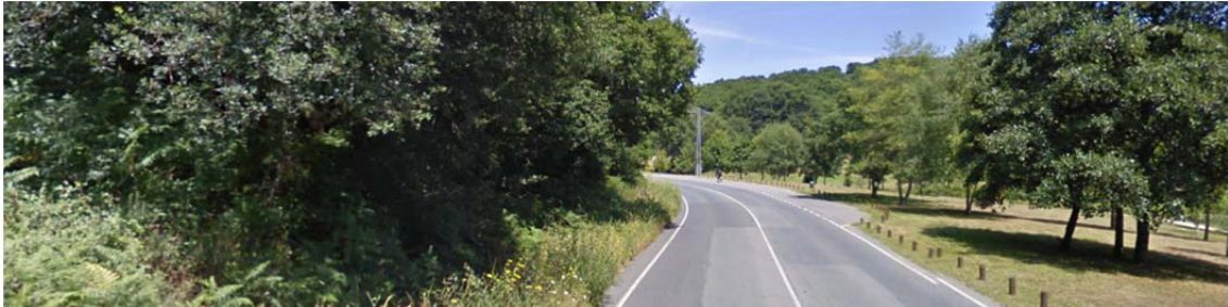
Figura 128: Caso analizado: vegetación en el interior de una curva en la carretera CP-29-25.
