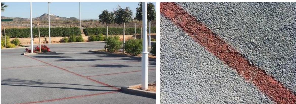
Figura 1. (a) Aparcamiento con pavimento permeable (Benaguasil, Valencia). (b) Detalle del hormigón poroso.
