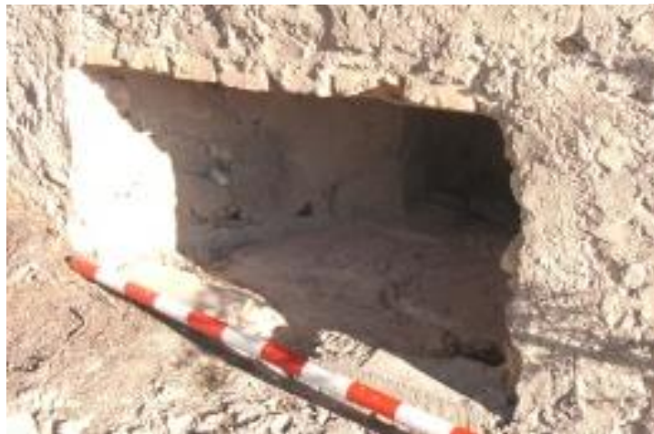
Figura 47. Dintel de tronera constituido de ladrillos macizos colocados a tizón en La Vallesa.
