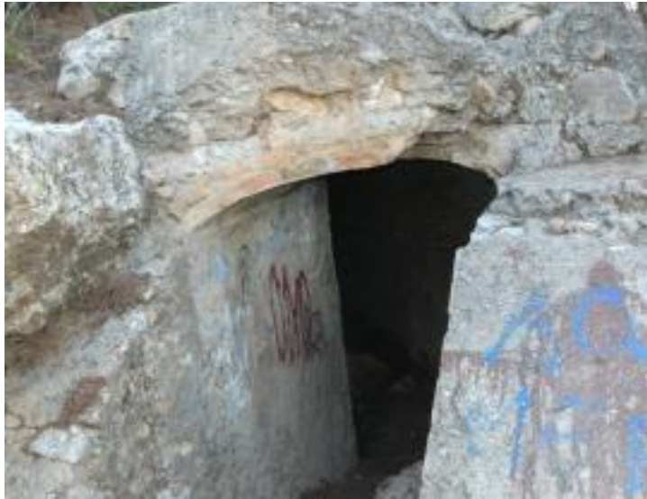
Figura 46. Acceso a casamata abovedado con arco de cañón de plementería tabicada en La Vallesa.
