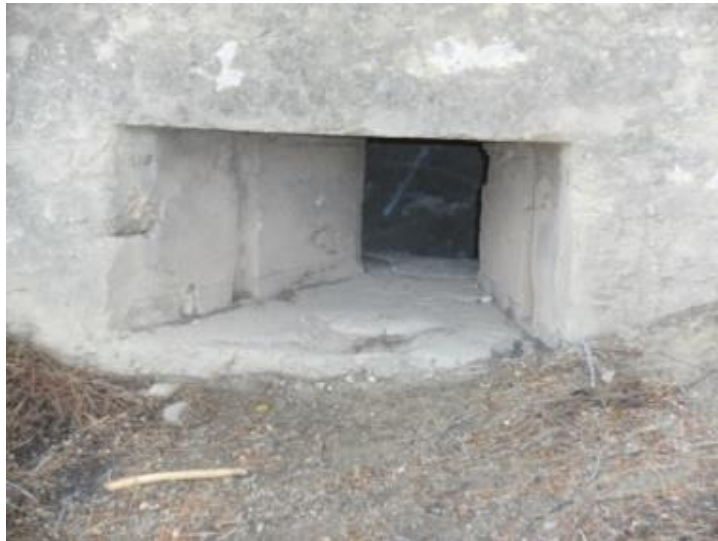
Figura 48. Tronera de casamata con hendiduras en La Vallesa.
