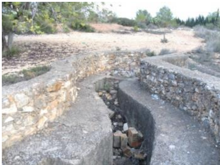
Figura 73. Parapeto ondulado con aspillera en La Vallesa.
