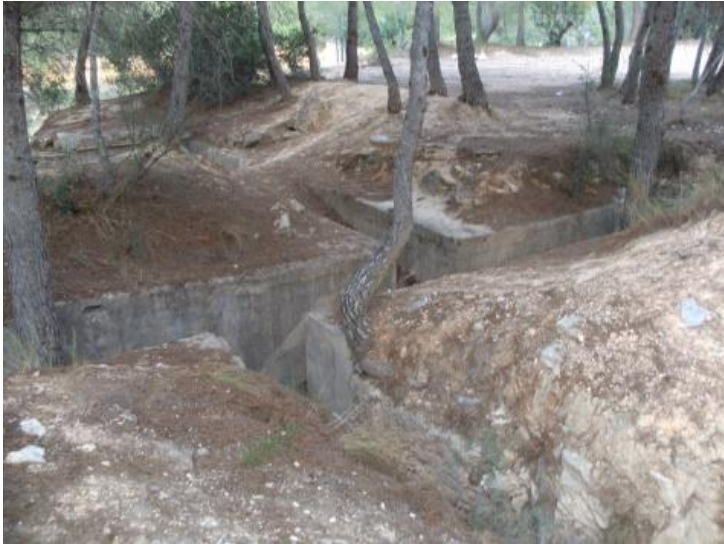
Figura 87. Vegetación alta y raíces presionando una trinchera de La Vallesa.
