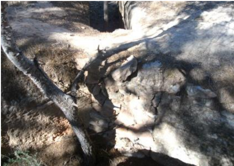
Figura 35. Desagüe en trinchera en La Vallesa.
