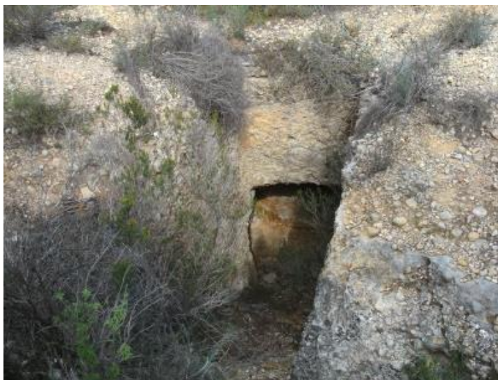
Figura 59. Estructura subterránea en el km 11 de la CV-35.
