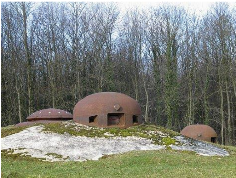
Figura 24. Cúpulas blindadas de diversos búnkeres de la línea Maginot (Winters, 2008).
