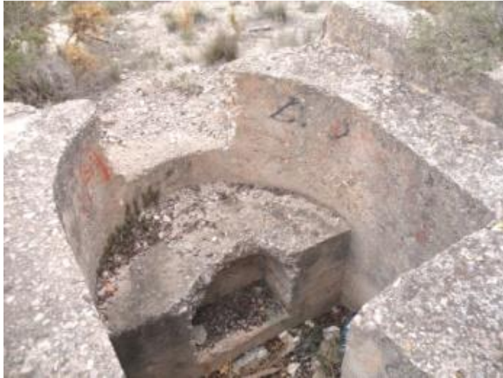
Figura 71. Casamatas en Paterna con troneras, hornacinas, y elemento de apoyo.
