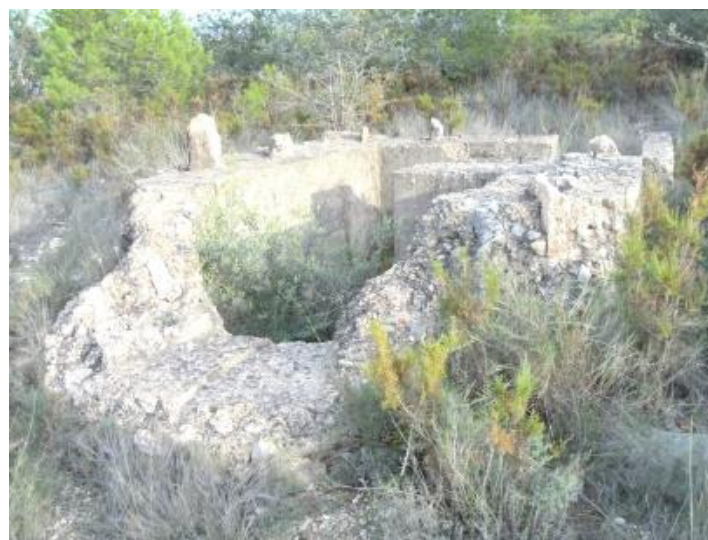
Figura 55. Casamata con piedras sobresalientes en la parte superior en el km 11 de la CV-35.
