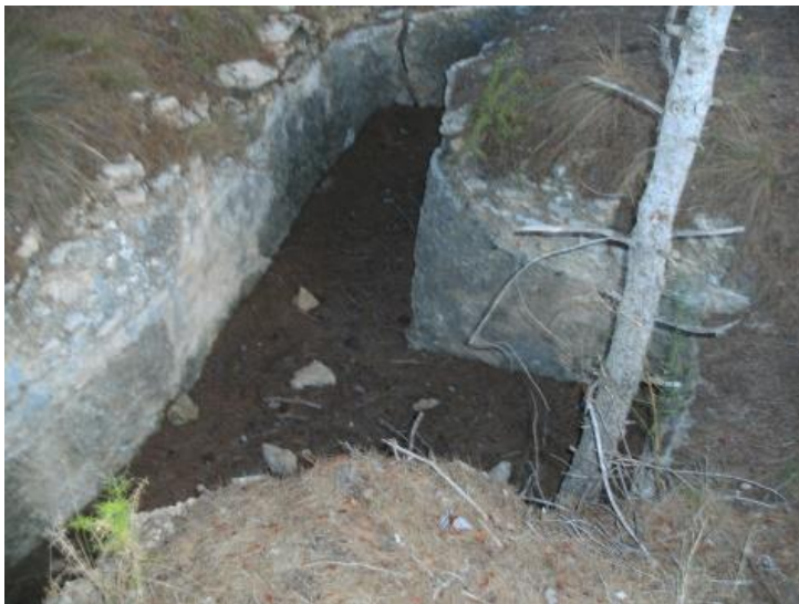
Figura 90. Grieta en trinchera de La Vallesa.
