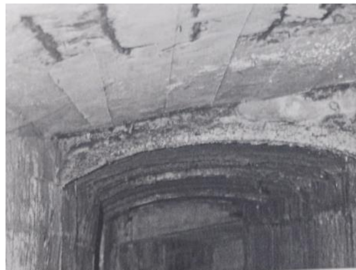
Figura 81. Techo adintelado de la galería de Vallepín (Sáez, 2010).
