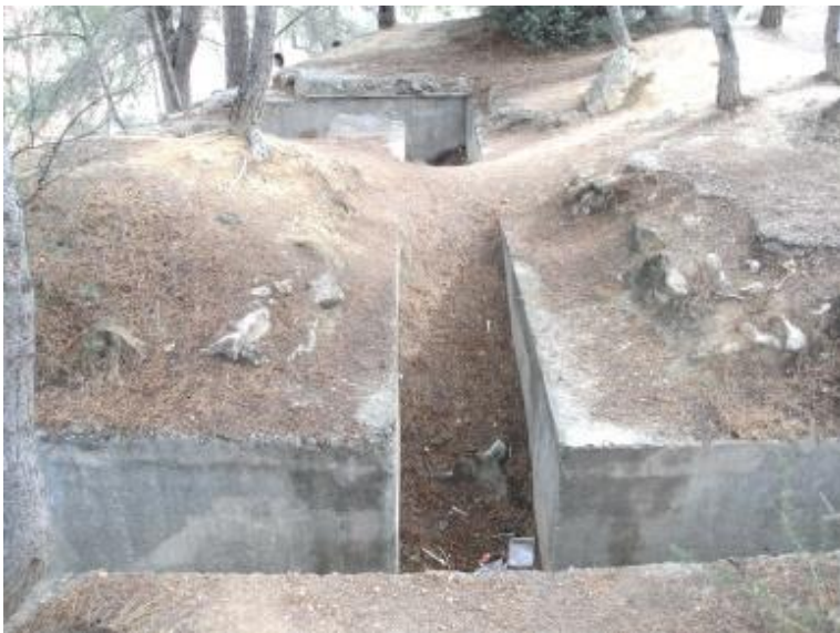
Figura 37. Trinchera revestida recta con ramal perpendicular a otro.
