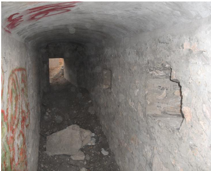
Figura 84. Galería aspillerada con presencia de patologías de origen natural y antrópico en La Vallesa.
