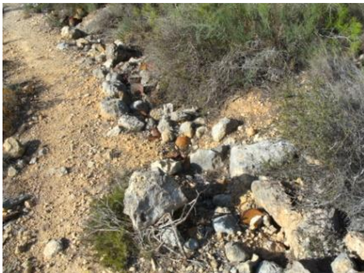
Figura 97. Zanja enterrada y con presencia de desechos en el Barranc d'en Dolça.
