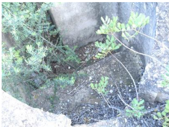
Figura 53. Mueble de obra para apoyo de arma bajo tronera en casamata en el km 11 de la CV-35.
