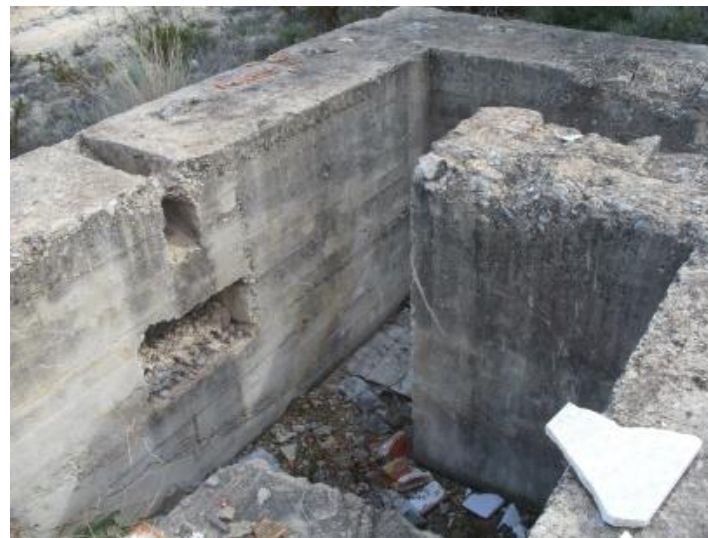
Figura 54. Casamata con nichos para almacenaje de munición en el km 11 de la CV-35.
