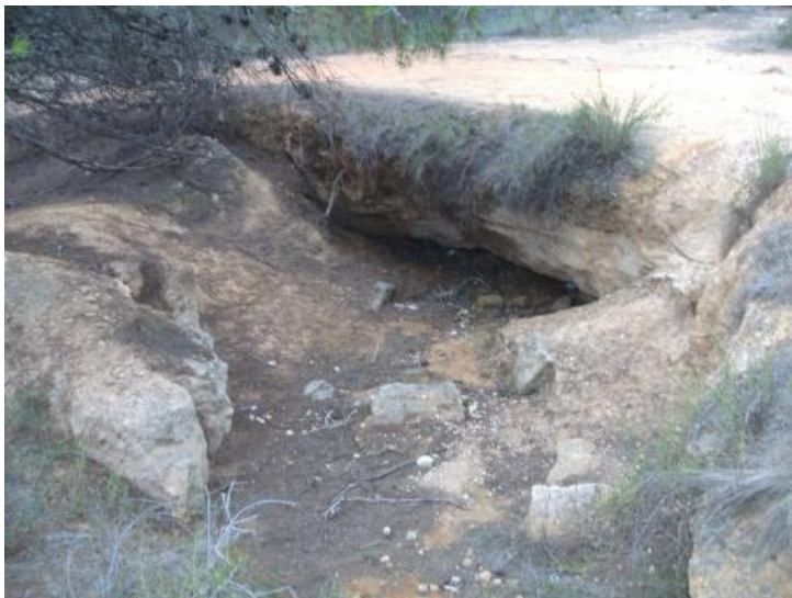
Figura 88. Abrigo bajo parapeto con manchas de humedad en La Vallesa.
