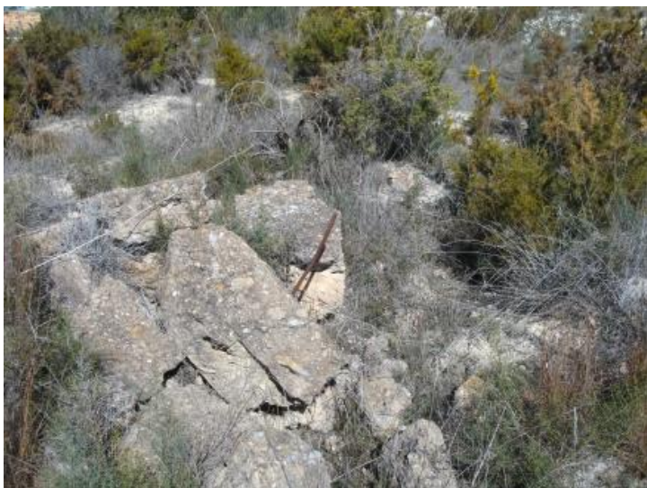
Figura 66. Escombros de hormigón con presencia de armaduras de acero.
