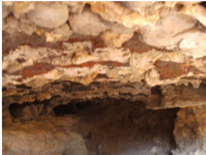
Figura 51. Techo de corredor con restos de corteza de árbol en La Vallesa.
