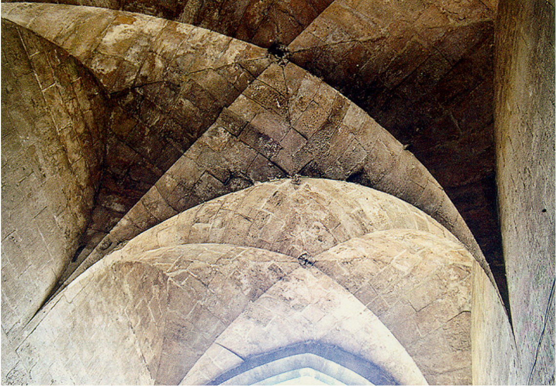
Bóveda Torres de Quart
