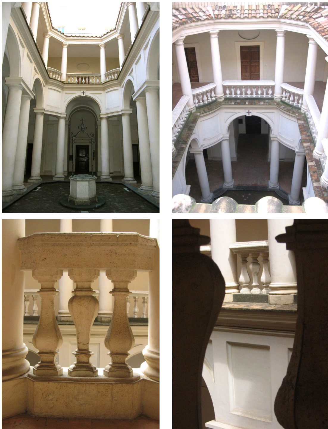
Fig. 41. Imágenes del claustro y detalles de la balastrada.
