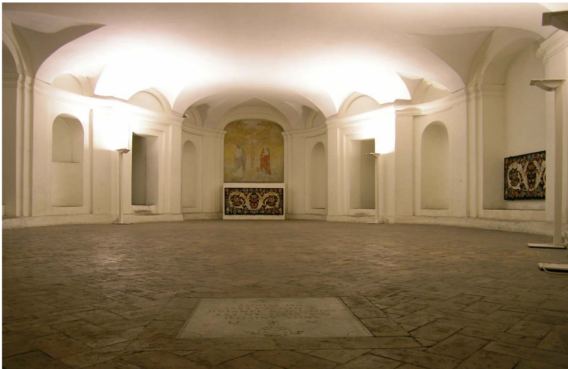
Fig. 40. La cripta sotterranea.
