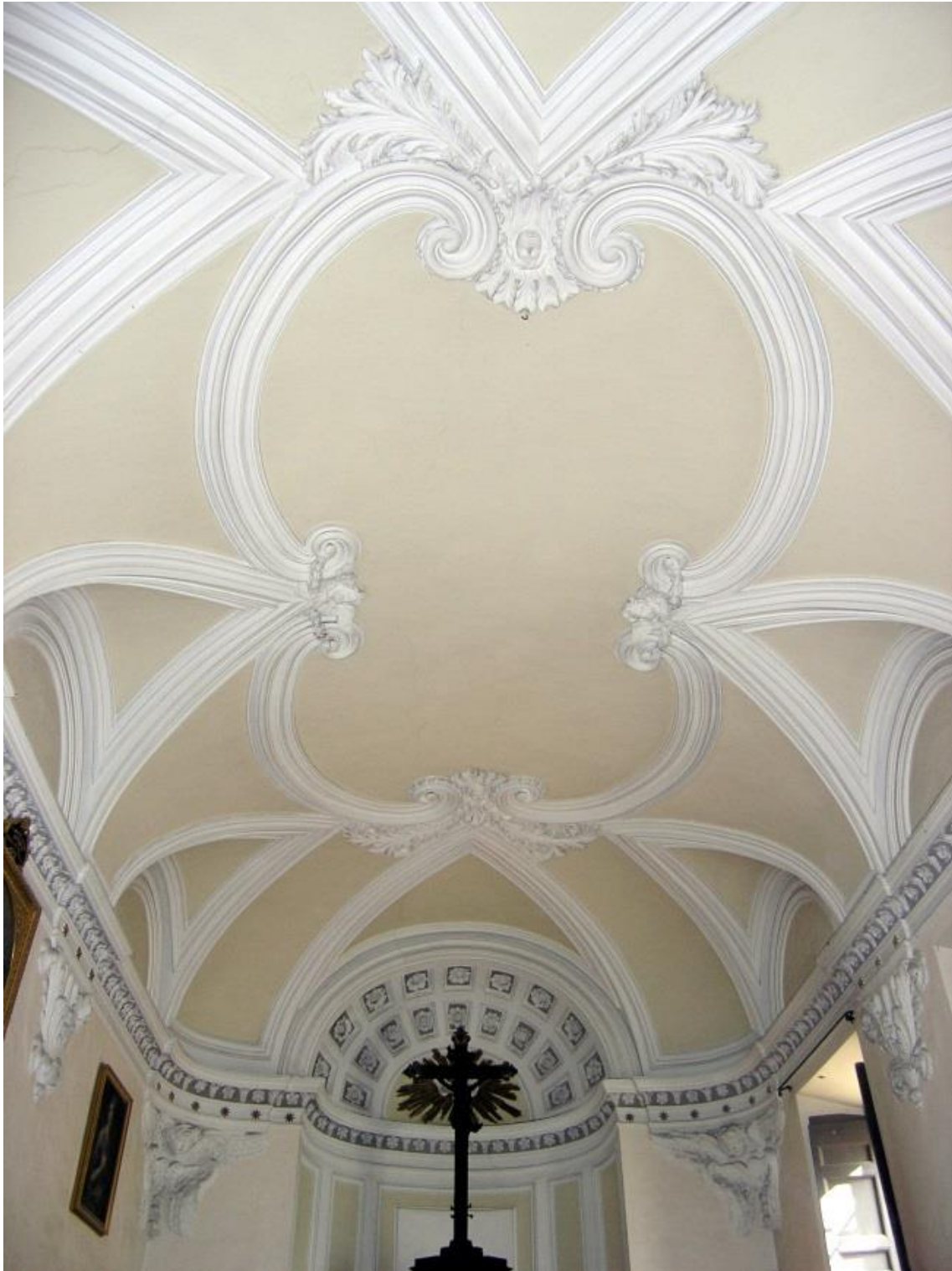
Fig. 95. Bóveda de la nueva sacristía.
