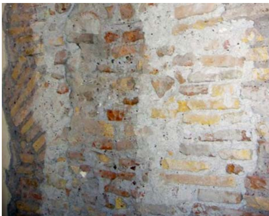
Fig. 115. Detalle del muro de ladrillo de la primera planta de la fábrica setechentesca. A la izquierda se puede apreciar el arranque de uno de los arcos de descarga.
