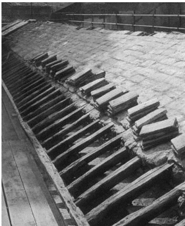
Fig. 143. Vista de una cubierta con tejado impanellato.
