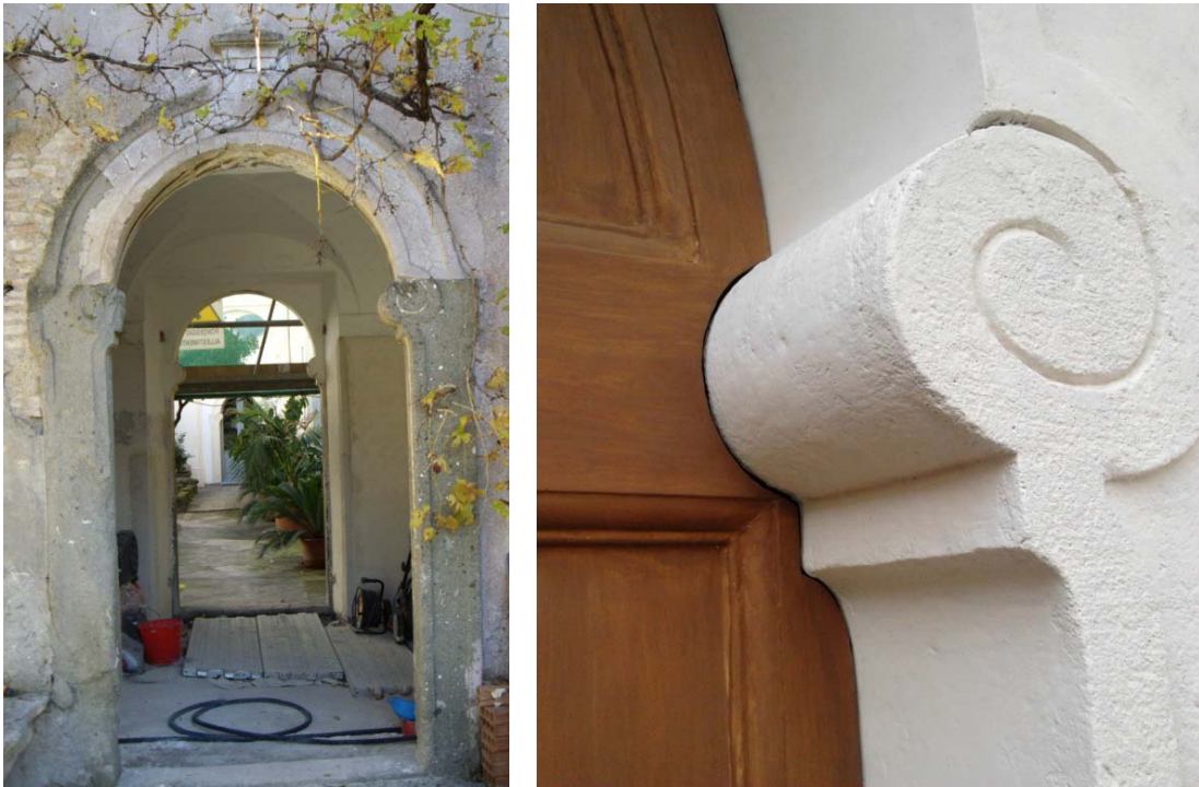
Fig. 119. Jambas de peperino de las puertas de paso a la fuente-pasaje y detalle de la voluta de peperino enjalbegado que imita el color del travertino.
