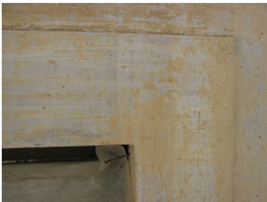
Fig. 170. Restos de la cola de preparación y de la imbiancatura en la fábrica setechentesca.
