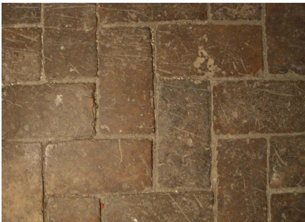
Fig. 153. Imagen del enladrillado rodado al agua sin recortar.
