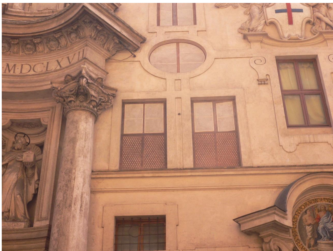
Fig. 42. Vista dell'incontro tra la facciata della chiesa e del chiostro.
