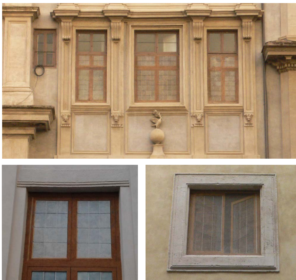
Fig. 171. Trampantojos de la fachada del palacio Pamphili en plaza Navona (arriba), de la fuente-pasaje (abajo izquierda) y del Colegio de Propaganda Fide (abajo derecha) donde se observa el color celestino aplicado a los fondos de los recuadros y la imitación de la carpintería de las ventanas.
