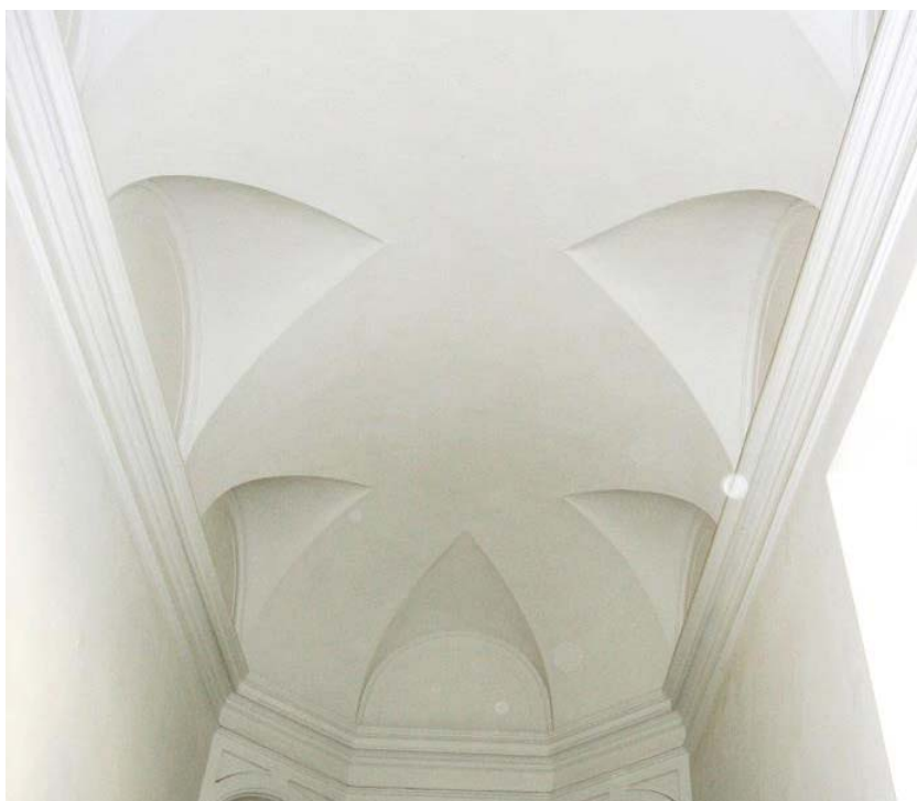
Fig. 51. Imagen de la bóveda de la antigua Sacristía, muy similar a la que ofrecía la bóveda del refectorio borromiano según los documentos de archivo.
