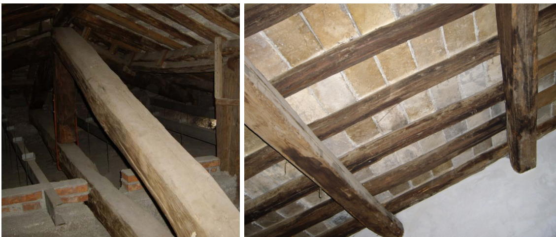
Fig. 141. Vista interior de la cubierta de la ampliación setechentesca.
