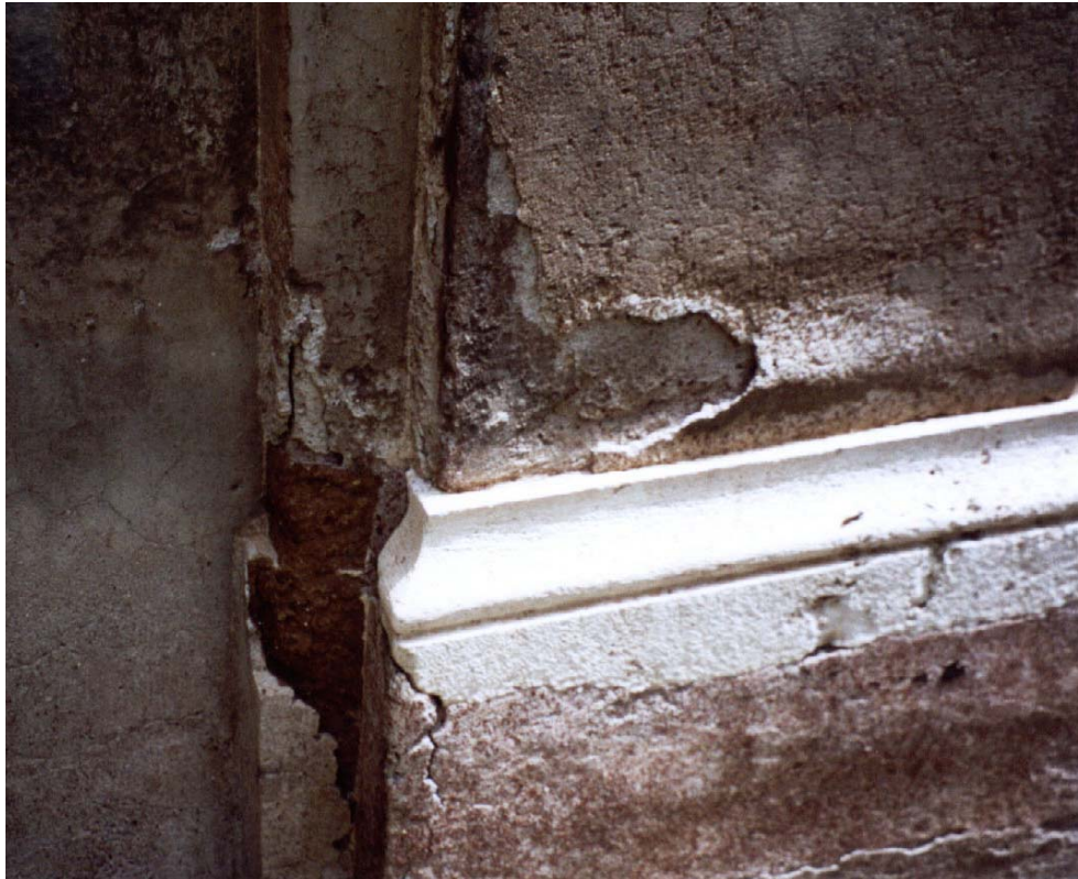
Fig. 118. Detalle de una de las bases de travertino de una de las pilastras de la fachada hacia el jardín de naranjos.
