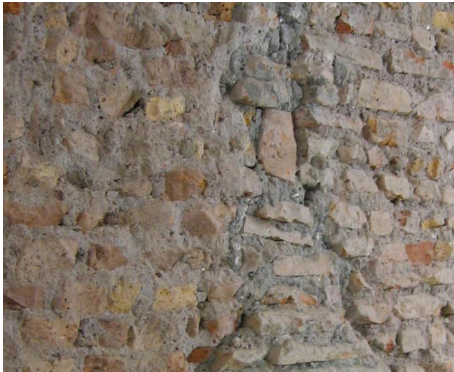
Fig. 112. Detalle del encuentro de los muros de tevolozza de la fábrica borrominiana y setechentesca en la fachada hacia vía Quattro Fontane.
