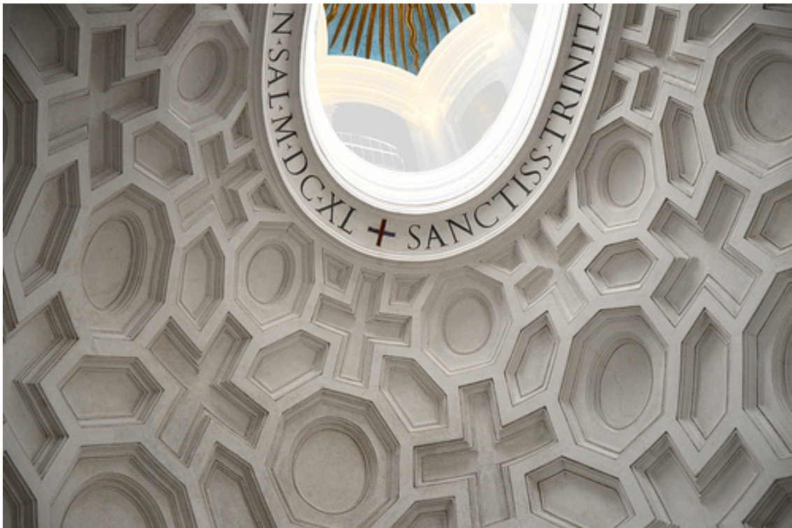
Fig. 39. Imagen de detalle de los casetones de la cúpula de la iglesia.
