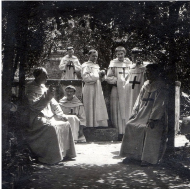
Fig. 180. Imagen del jardín nuevo con su fuente central, antes de que los terrenos que ocupaba fueran vendidos al Ufficio Italiano dei Cambi .
