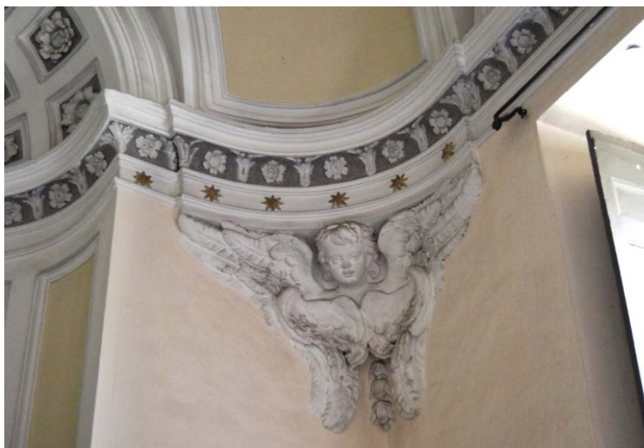
Fig. 97. Detalle del querubín en esquina.
