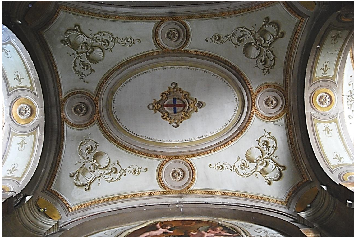
Fig. 129. Vista cenital de la bóveda vaída del vestíbulo borrominiano en la actualidad. En el proyecto original no estaba decorada y, al igual que el resto de los ambientes del cuarto, estaba sencillamente pintada de blanco.
