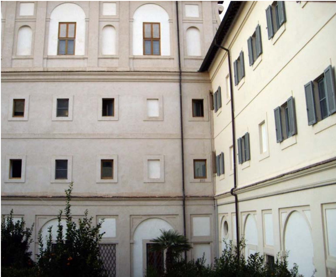
Fig. 74. Incontro tra la facciata del quarto del dormitorio e l'ala dell'ampliamento parallela a via Quattro Fontane.
