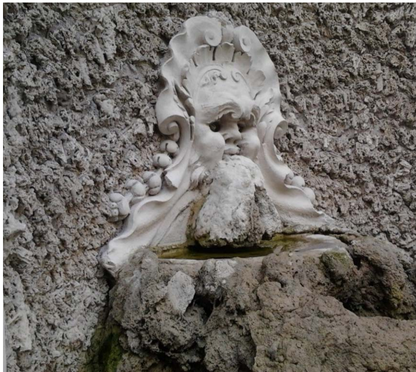
Fig. 91. Dettaglio del mascherone centrale e dei tartari della nicchia.
