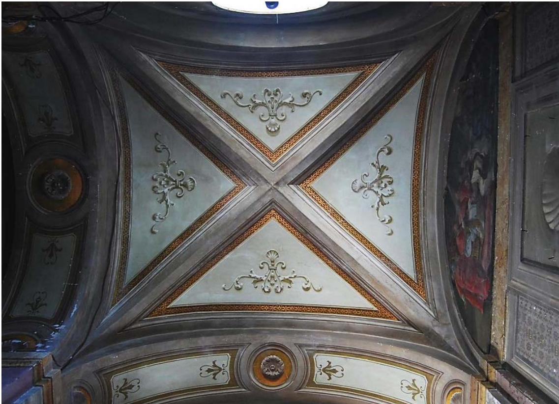
Fig. 130. Vista cenital de la bóveda de arista del nuevo vestíbulo en la actualidad. En el proyecto original no estaba decorada y, al igual que el resto de los ambientes del cuarto y de la ampliación, estaba simplemente pintada de blanco.
