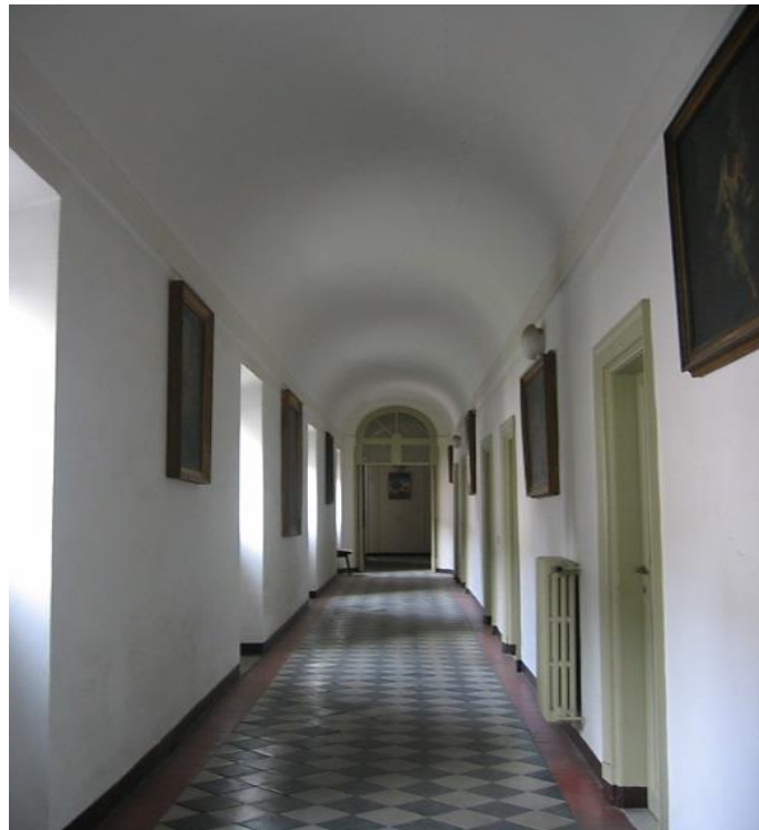
Fig. 135. Corredor del brazo de la fábrica setecentescas paralelo al cuarto del dormitorio cubierto con bóveda de cañón.
