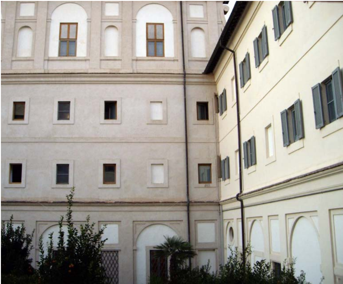
Fig. 74. Encuentro de la fachada del cuarto del dormitorio y el ala de la ampliación paralela a la vía Quattro Fontane.
