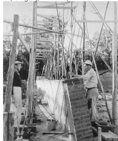
Construcción de la Iglesia de la Atlántida, Uruguay, E. Dieste, 1952
