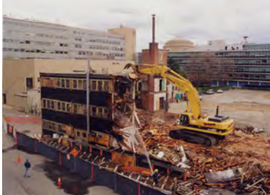
Demolición del Building20, MIT, 1998
