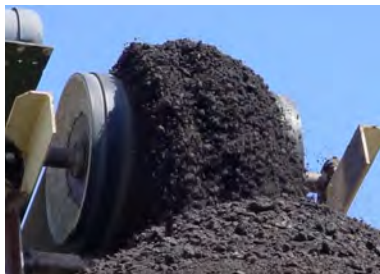
Machaqueo de hormigón demolido para reutilización 'in situ'
