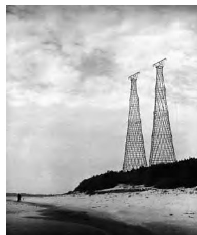
Torre eléctrica en el Río Oká, V. Shujov, 1927-29
