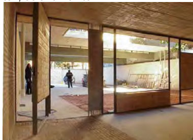
Centro Rehabilitación Fundación Teleton, Solano Benítez
