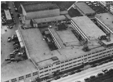
Legendario Building 20 , del MIT, antes de su demolición
