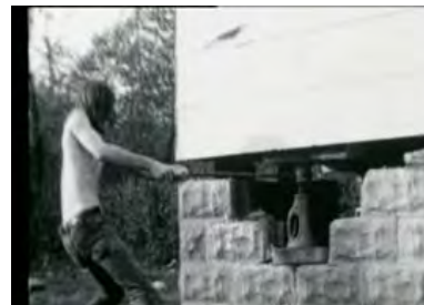
Descalzando una cimentación en un Split-
