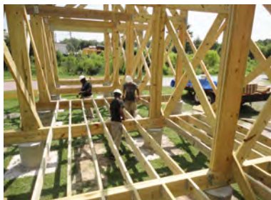
Studio H . Construcción del Windsor Supermarket, Bertie County, EEUU
