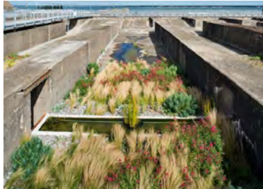
Jardines sobre las cubiertas de los restos de la base de submarinos alemanes en Saint-Nazaire, G. Clement
