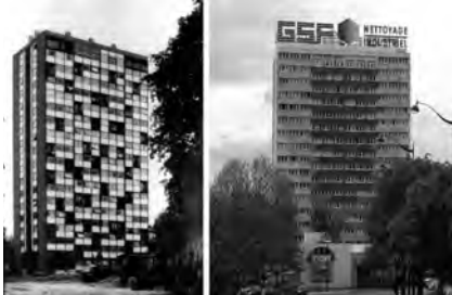
Tour Bois le Prêtre, Estado original
