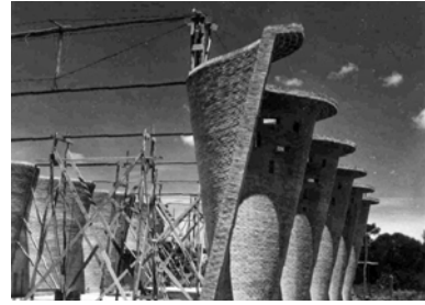
Construcción de la Iglesia de la Atlántida, Uruguay, E. Dieste, 1952
