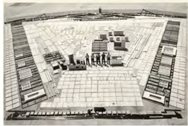
Diseño para el montaje/desmontaje: Lustron House, Vivienda prefabricada desmontable de paneles de acero esmaltado, tiempo de ejecución medio 360 h. Lustron Corporation, 1948-50
