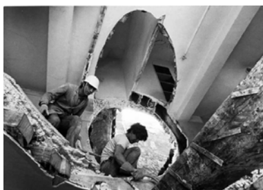
Demolición de forjados en Conical Intersect ,
