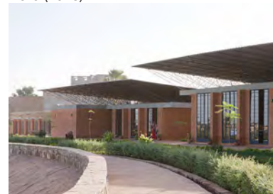
Centro para la arquitectura de tierra, Mali, F.D. Kéré (2010)
