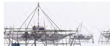
Estructuras de pesca Bagang, Indonesia
