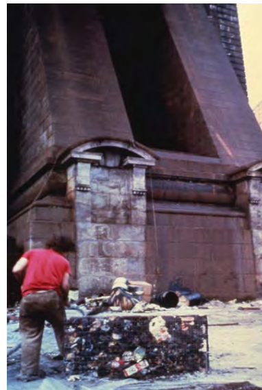
Construyendo un muro con basura en Garbage Wall , 1970
