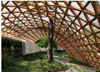
Centro Rehabilitación Fundación Teleton, Solano Benítez
