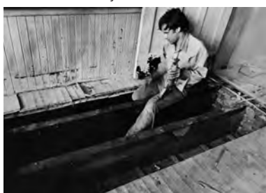
M-C demoliendo el suelo en una de sus
