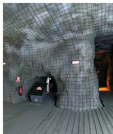
Habilitación de museo en Antiguos Refugios de la Guerra Civil en el Castillo de Cartagena, con criterio de consolidación y mínima intervención, M. Lejárrega, 2002-04
