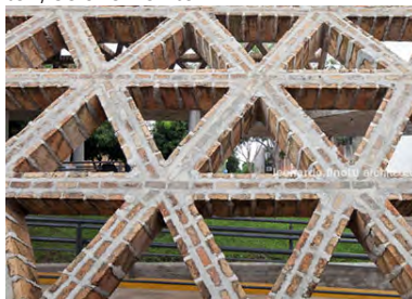
Centro Rehabilitación Fundación Teleton, Solano Benítez
