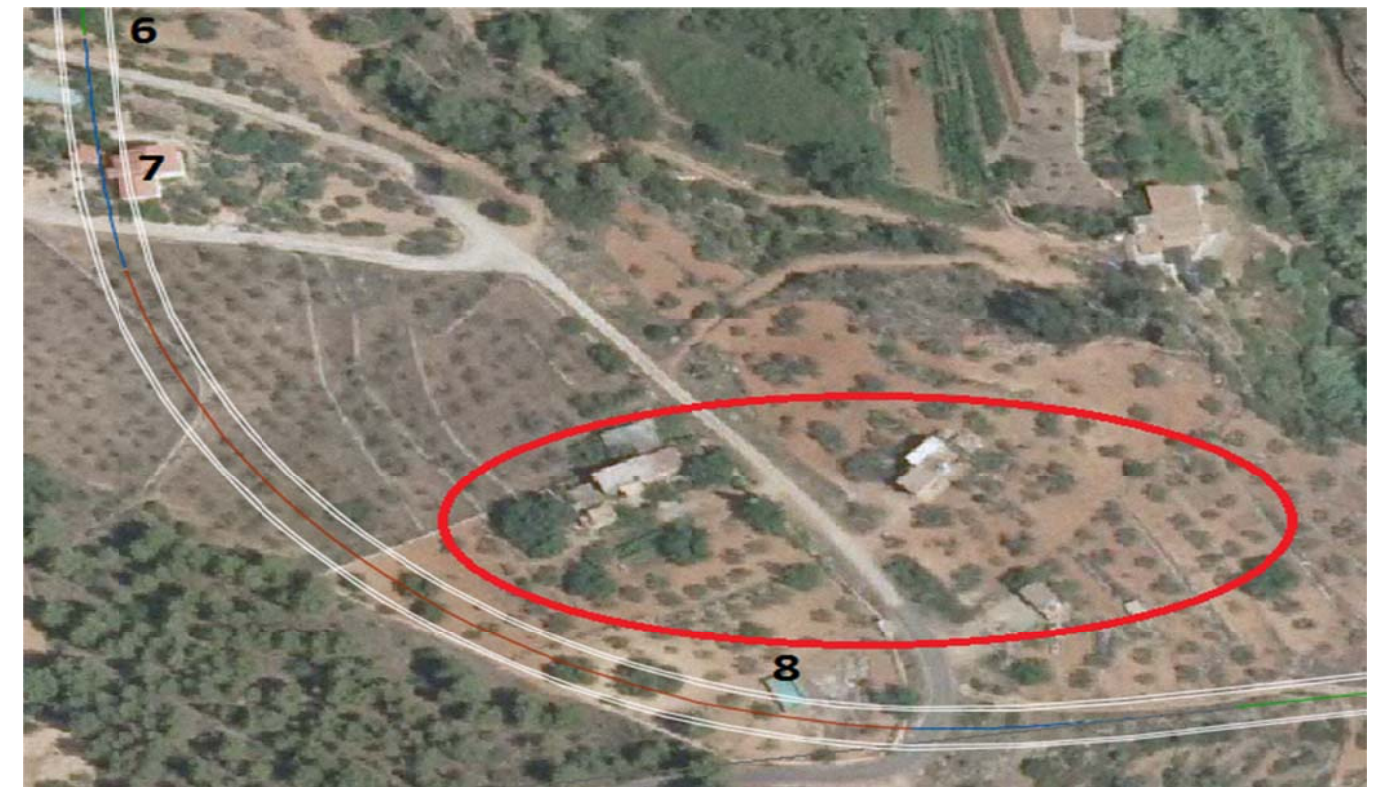
Fig. 71 Viviendas aisladas entre los puntos 7 y 8 de la variante
