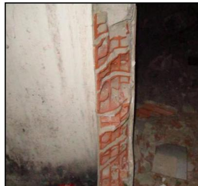
Figura 85. Foto de la sección de una de las particiones interiores. (Fuente: propia)
