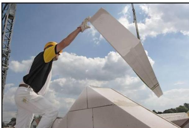
Figura 81. Ejemplo de solución de cubierta con placas Ytong. (Fuente: [www.ytong.es](http://www.ytong.es))
