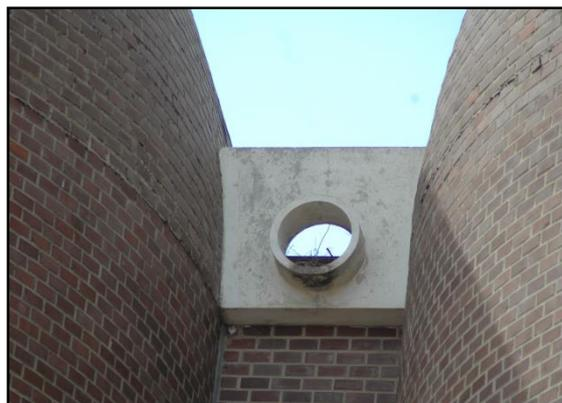
Figura 88. Fotografía de unas de las gárgolas y el tubo de evacuación de aguas.
