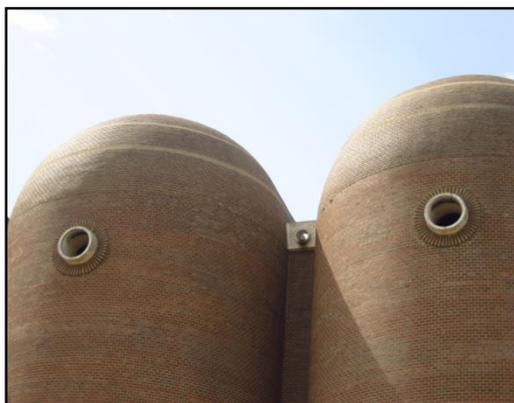
Figura 87. Fotografía de los lucernarios de ventilación y las gárgolas para la evacuación de aguas.
