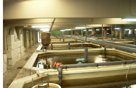
Figura 81. Tanques de engorde de anguila de Valenciana de Acuicultura, s.a.
