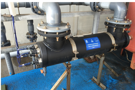
Figura 80. Filtro UV de una granja de preengorde de la C. Valenciana.
