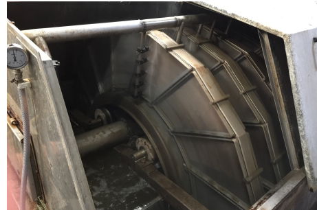
Figura 82. Filtro mecánico (de disco) de Valenciana de Acuicultura, s.a.
