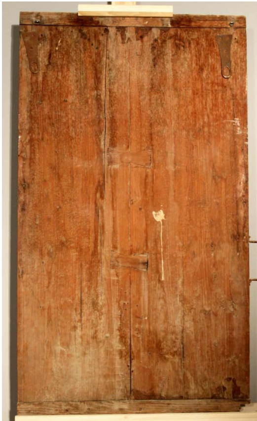
A l'esquerra, part posterior del relleu central del Retaul de les Santes Càndia i Còrdula. Observem els dos travessers als extrems i les dobles cues de milà a les unions dels dos taulons. A la dreta, detall del travesser inferior vist per davant (Fotografies: EADT)
