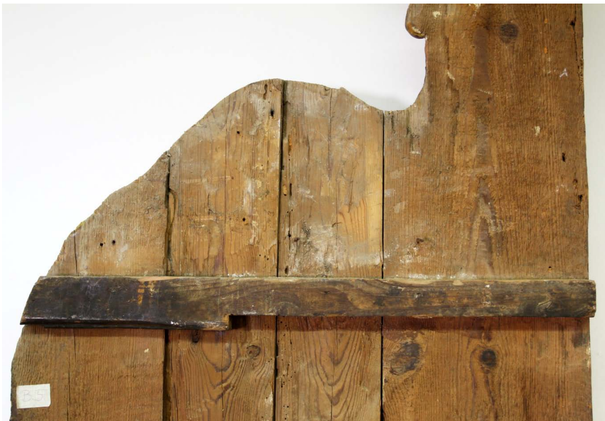
Travesser que reforça les fustes del relleu lateral del Retaule de les Santes Càndia i Còrdula. (Fotografia: EADT)
