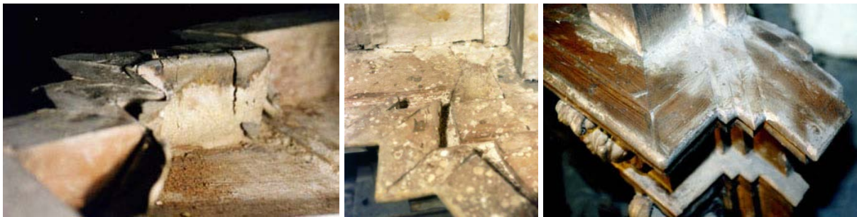
Cornises amb encaixos de biaix dels retaules de Sant Joaquim, del Roser i de Sant Pere, respectivament
