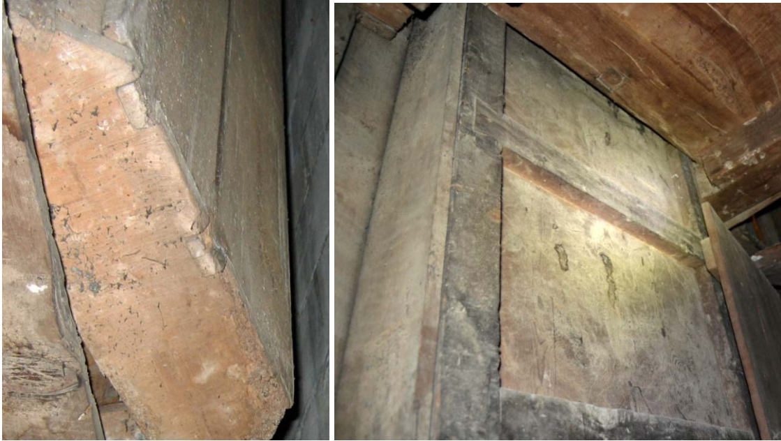
Dos exemples de caixes del Retable de Sant Ruf. A la dreta, caixa gran amb unions en cudornella. A l'esquerra, caixa del manifestador amb cudornelles semicobertes a mitja fusta i bastidor de reforç
