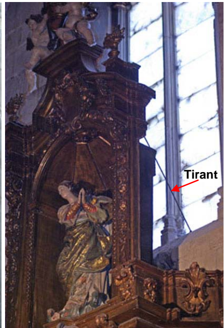
Tirant metàl·lic que aferma l'àtic del Retaule de Sant Pere
