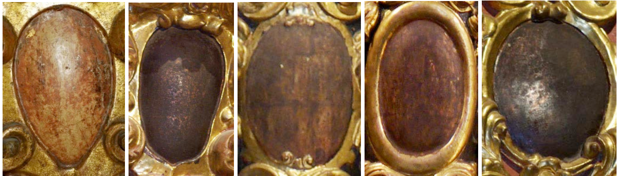
Tipus de medallons colrats del Retaule de les Ànimes. D'esquerra a dreta: colradura desapareguda del sotabanc, medalló del banc, medalló de l'imoscap de la columna del carrer lateral, medalló de la columna del carrer principal, medalló del carrer lateral del cos principal.
