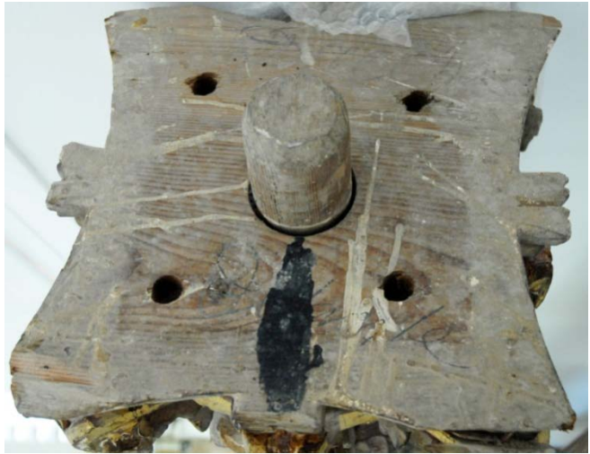
Espigues rodones de columnes a la base inferior (esquerra) i superior (dreta). Encerclada en blanc es mostra la marca del torn. (Fotografies: EADT)
