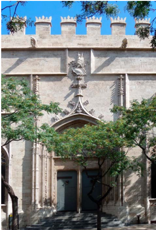
Imagen 2 FACHADA PRINCIPAL DE LA LONJA DE VALENCIA. Fuente propia.
