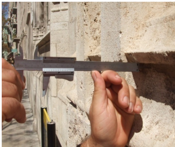
Imagen 6 UTILIZACIÓN DEL PIÉ DE REY SOBRE LA JAMBA. Fuente propia.
