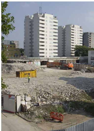
3.192_Demolición de Tavy Bridge
