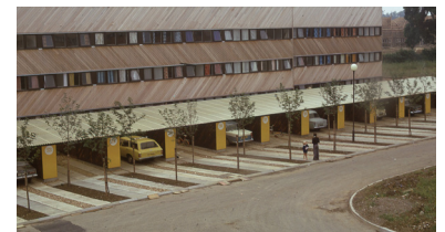
3.246_Fullers Slade al terminar su construcción
