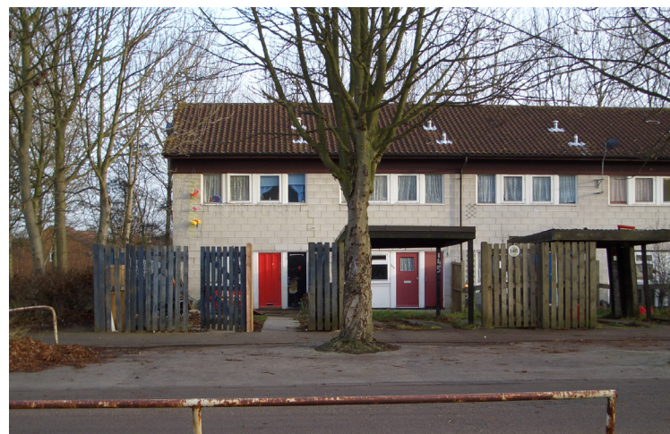
3.254_Viviendas cuyas cubiertas han sido modificadas.
