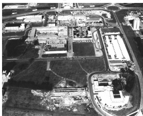
3.72_El centro de Harlow en construcción, 1959.
