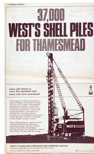
3.119_Empresa que realizaba los pilotes de Thamesmead
