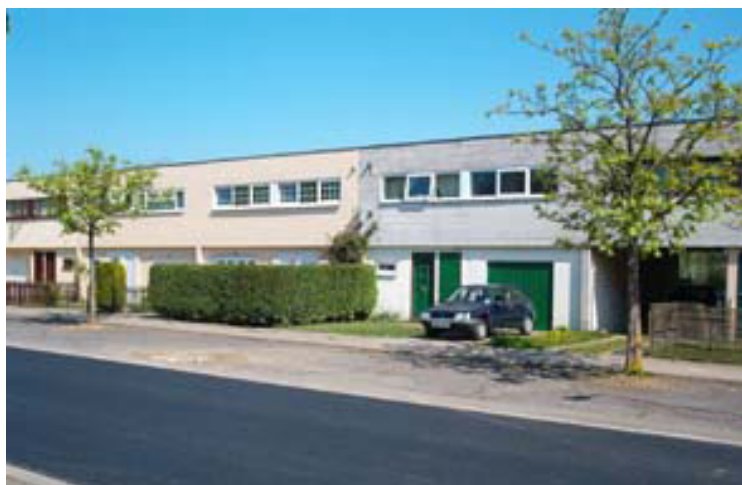
3.253_Viviendas que mantienen sus cubiertas planas.
