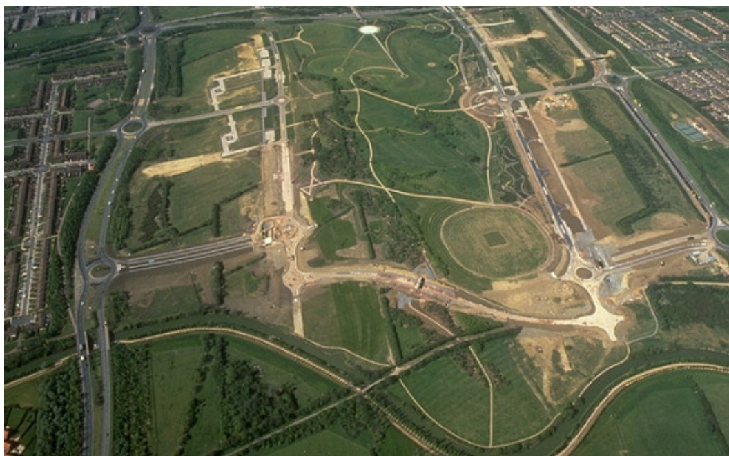
3.286_Construcción de las infraestructuras de la ampliación del centro urbano ocupando terrenos del Parque Campbell.
