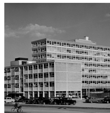
3.73_Vistas del centro urbano.
