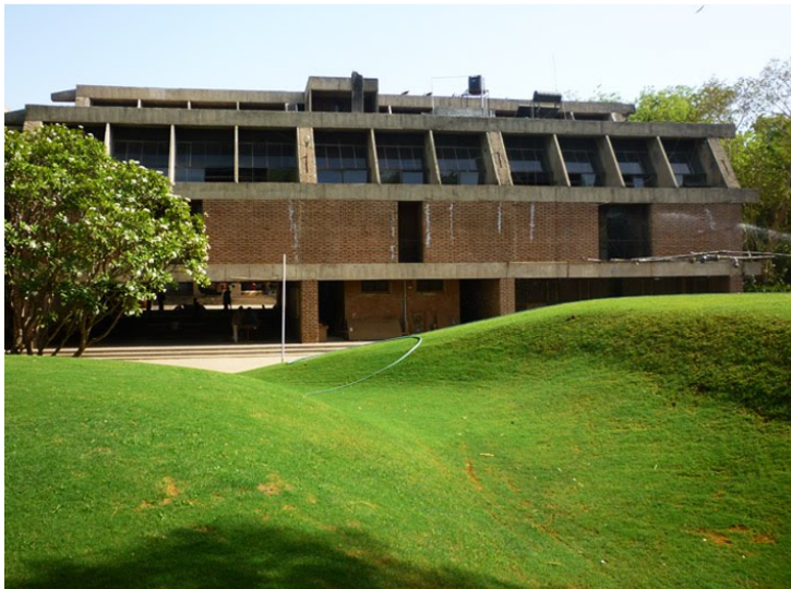
Escuela de Arquitectura CEPT. B. Doshi. 1962. Foto del autor. 2014.
