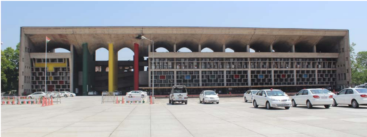
Fig. 55 Edificio destinado a la Corte Judicial en Chandigarh. Fotografía del autor. 2014.
