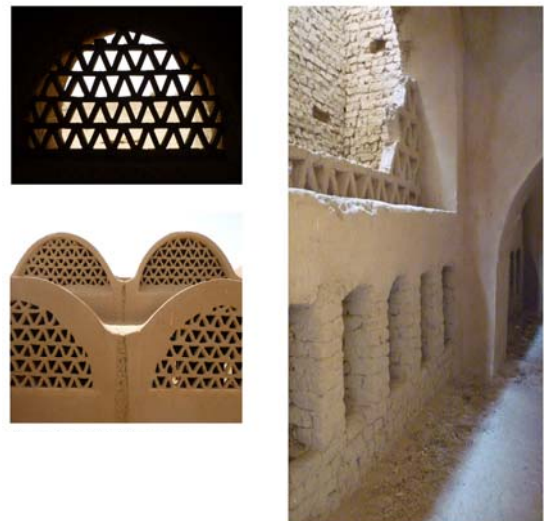
Fig.85 Canalización del Malqaf, el aire recogido en cubierta se impulsa hacia el interior del edificio. Fotografía del autor. 2010.
