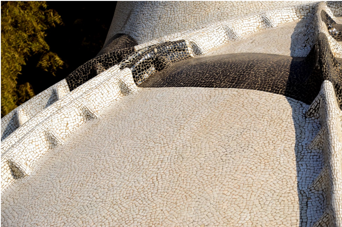
Fig. 35 Detalle de la cerámica que cubre la galería de arte Husain Doshi Gufa. Fotografía del autor. 2014.
