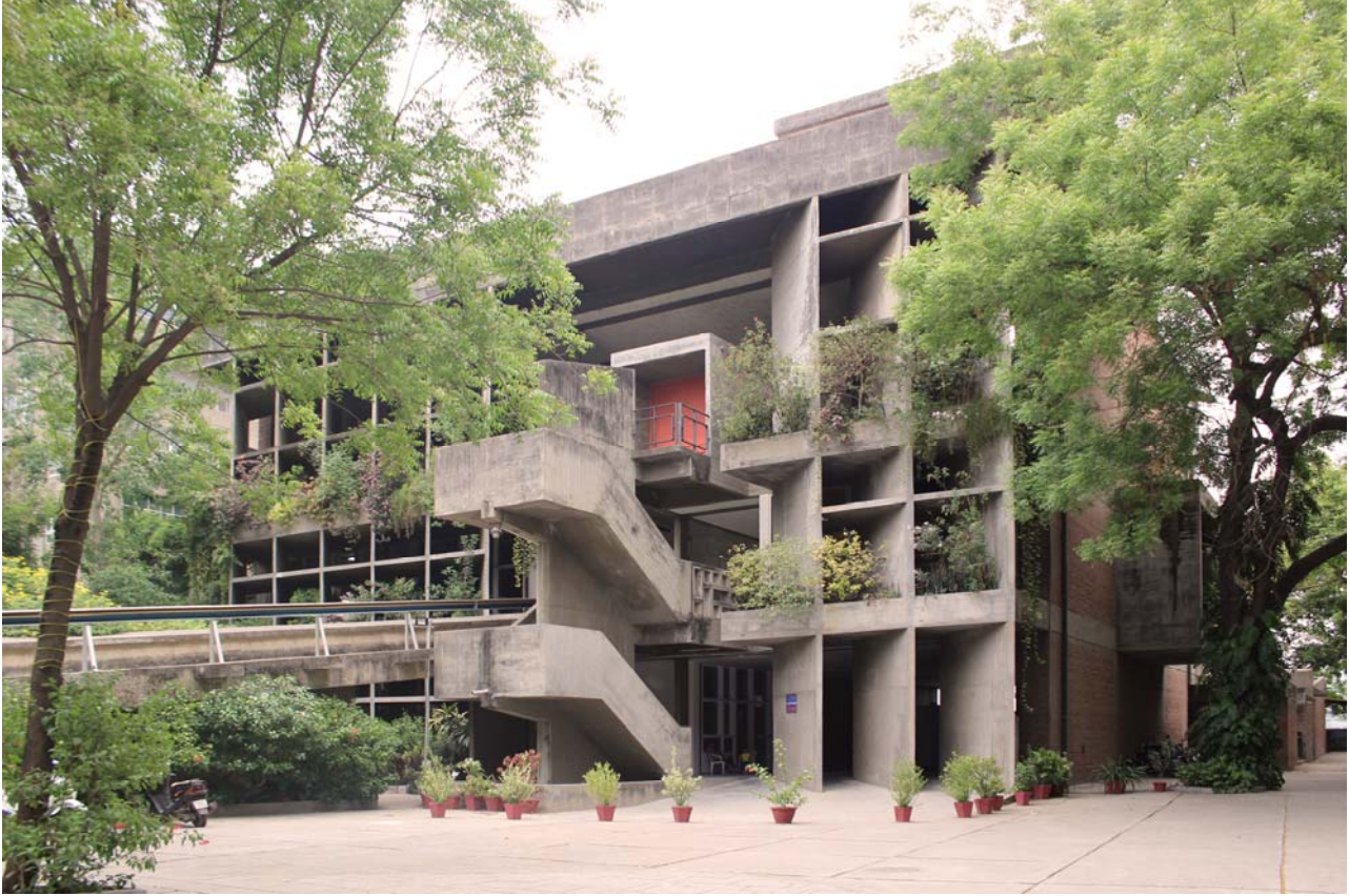
Asociación de Hilanderos. Le Corbusier. Fachada principal. Fotografía del autor. 2014.
