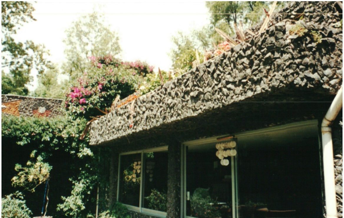
Fig. 70-71 Exterior dela casa de Colon Nancarrow. Proyecto de Juan O’Gorman. (1947) Fotografías cortesía de Víctor Jiménez
