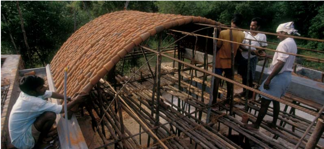
Construcción de una cubierta abovedada con piezas cerámicas. One Wall House . 2000. Auroville, India. Anupama Kundoo.
