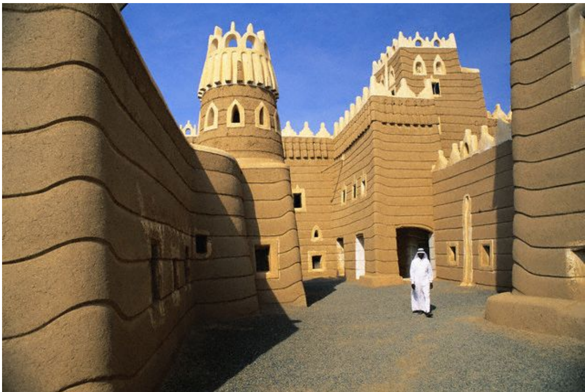
Fig.66 Fuerte de Najran (1942), construido con las técnicas tradicionales caracterizadas por la capa gruesa de revoco que impermeabiliza los muros.
