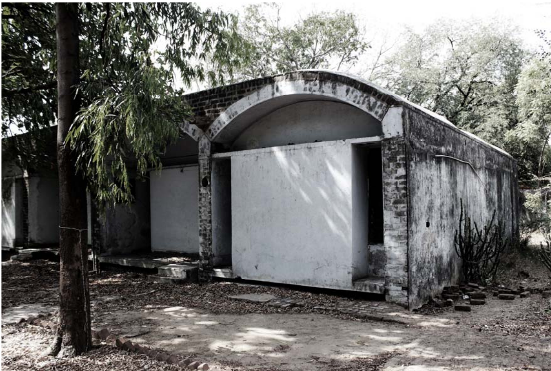
Fig.08 Viviendas para obreros realizadas para la empresa ATIRA. Ahmedabad B. Doshi. (1957) Fotografía del autor . 2014.
