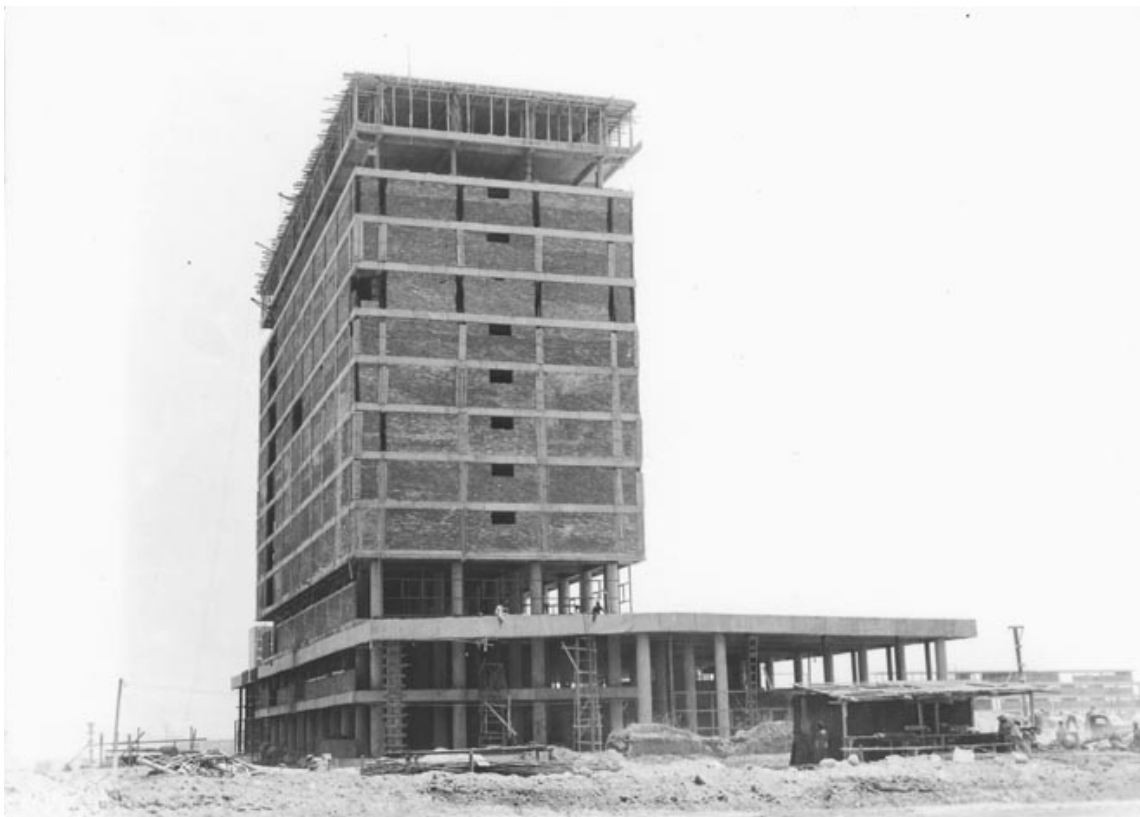
Fig. 15-16 Fotografías de la fase de construcción de la biblioteca de la UNAM. Proyecto de Juan O'Gorman. Fotografías de 1952. Archivo Histórico de la UNAM
