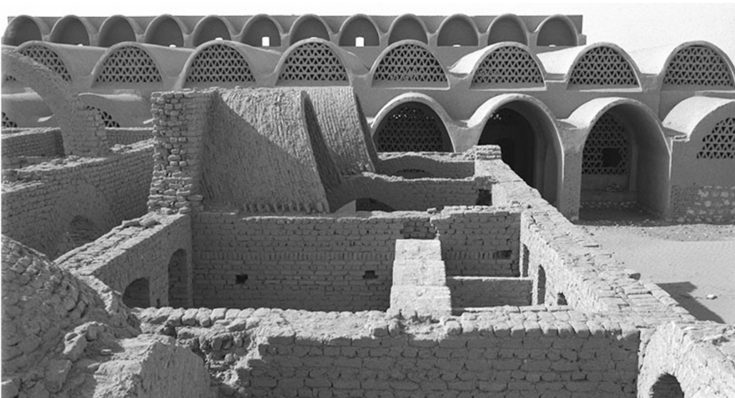
Fig.19 Mercado de Baris en construcción. El ladrillo, mucho más prensado y rico en arena, unido al profundo nivel freático, mantiene el edificio en perfecto estado.
