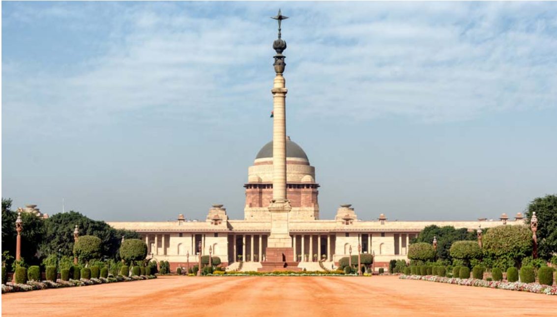
Palacio del Virrey de India en Nueva Delhi. Diseñado por Edwin Lutyens en 1912, combina perfectamente los órdenes clásicos con elementos de la tradición hinduista.
