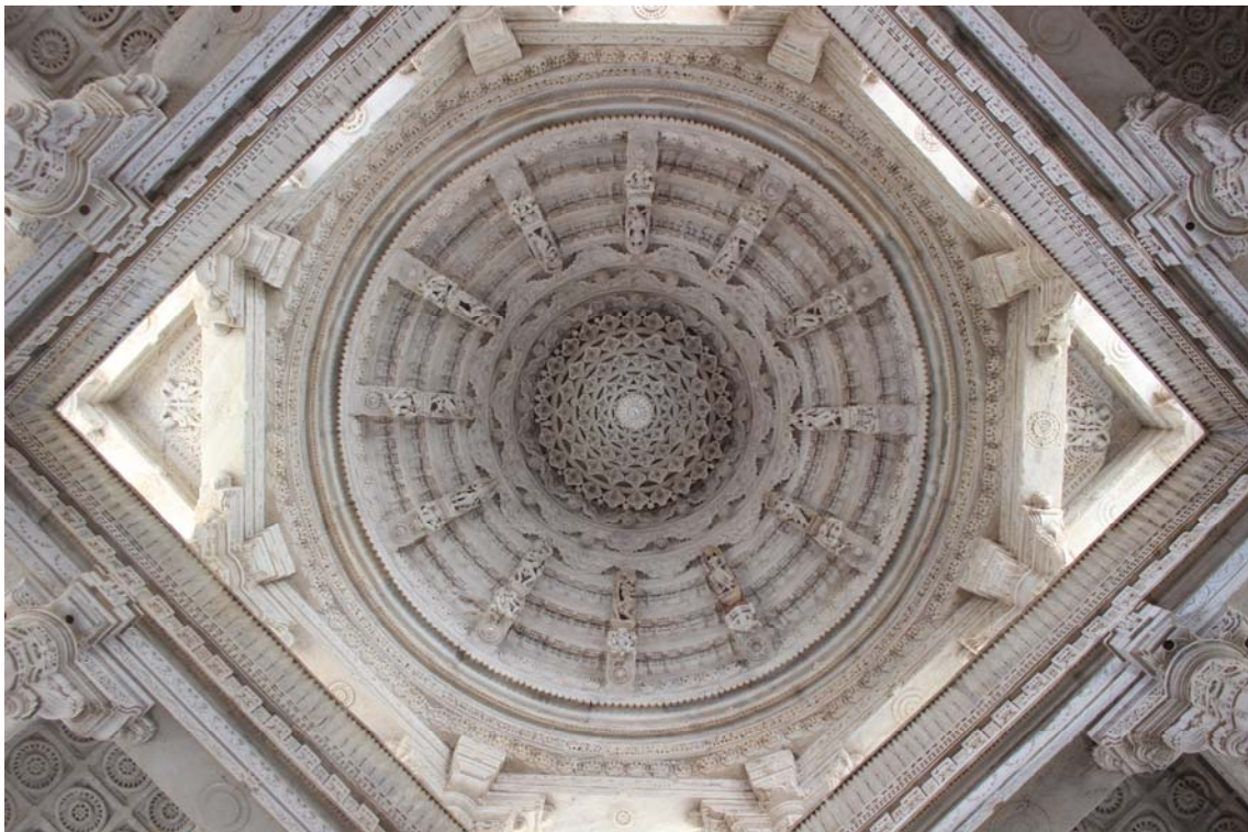
Templo de Jaina en Ranakpur. Construcción iniciada en el año 1437. Destaca por el labrado del mármol blanco que constituye el único material del templo. Fotografía del autor. 2014.
