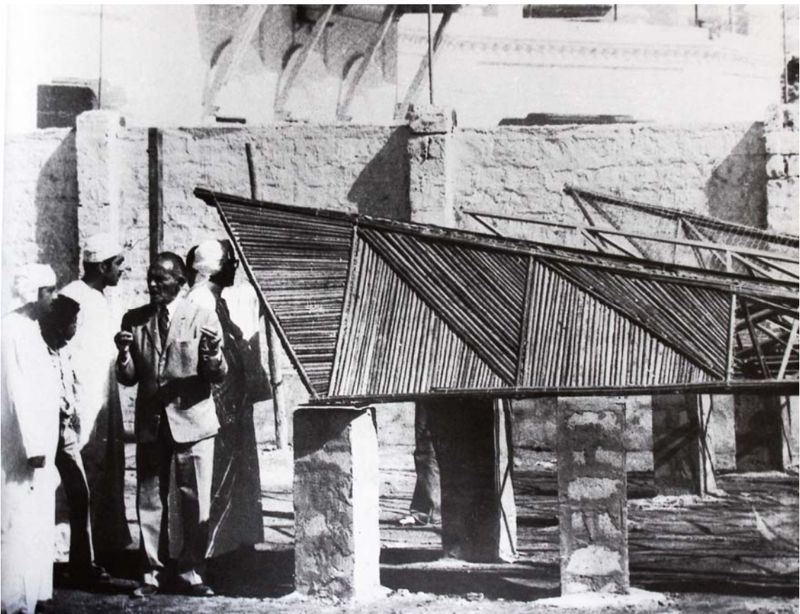
Fig.64 Fathy describe el uso de la estructura triangulada conocida como Baratsi a los operarios del proyecto del Mercado en Sohar, Oman. 1974
