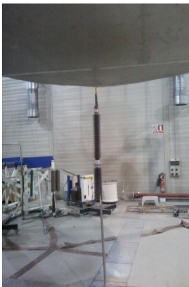
Figura 3.4. Fotografía del montaje realizado.
