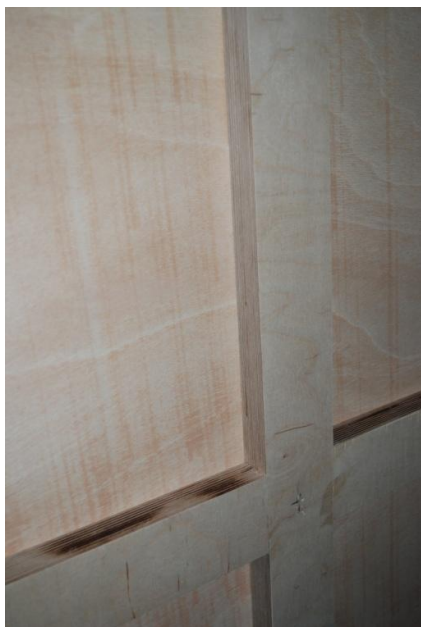
Figura 7.3. Detalle del reverso de las obras. Podemos observar la cruceta del bastidor realizada con tablero contrachapado.
