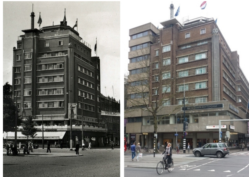
Arriba: Imagen de Bing maps de la calle Coolsingel, Derecha: Imagen del Hotel Atlanta en su estado original y actual. Extraída de http://gowiththevlo.nl/wp-content/uploads/2015/04/Hotel-Atlanta-Coolsingel-Rotterdam.jpg
