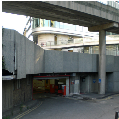
Arriba: Paso rodado bajo las plataformas. Sobre estas líneas: Entrada a aparcamiento bajo pasarela peatonal. Fotos de la autora, septiembre 2009.
