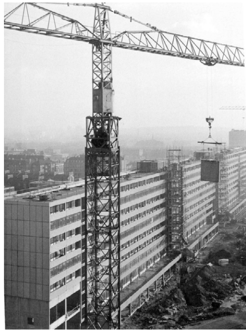
Aylesbury Estate en construcción. Foto de https://southwark-notes.files.wordpress.com
