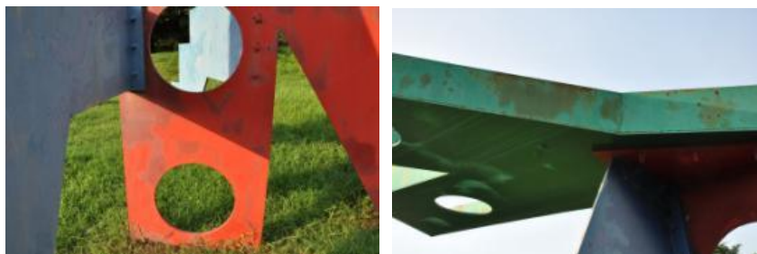
Figs. 120 y 121, Los detalles del deterioro de la obra.
