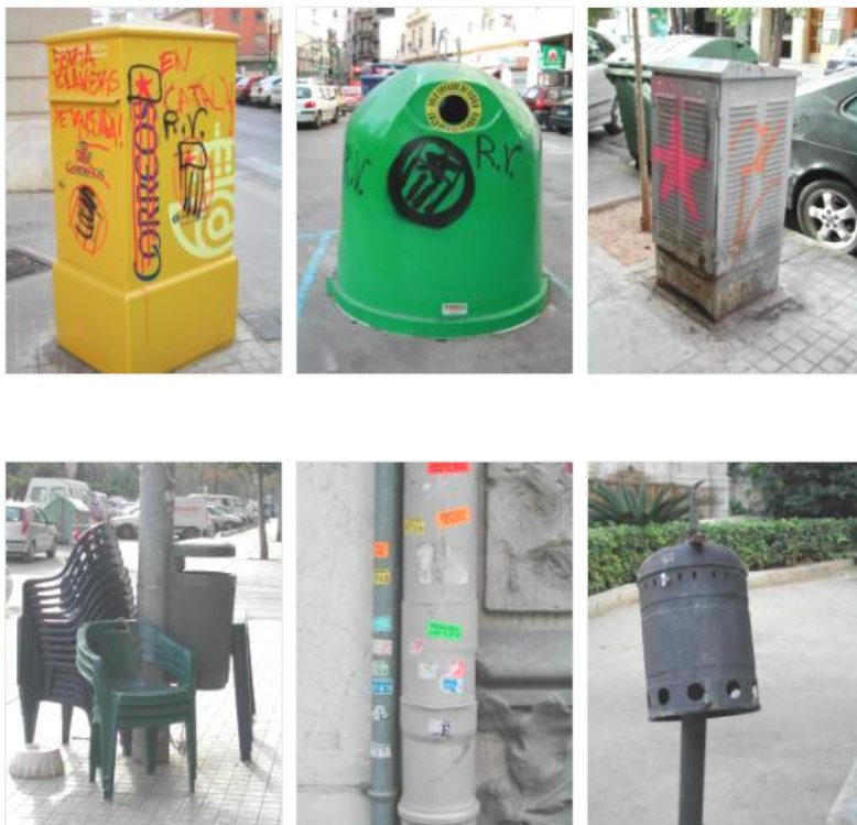
Figs. 13, 14, 15, 16, 17 y 18, Defectos y deterioros humanos.
