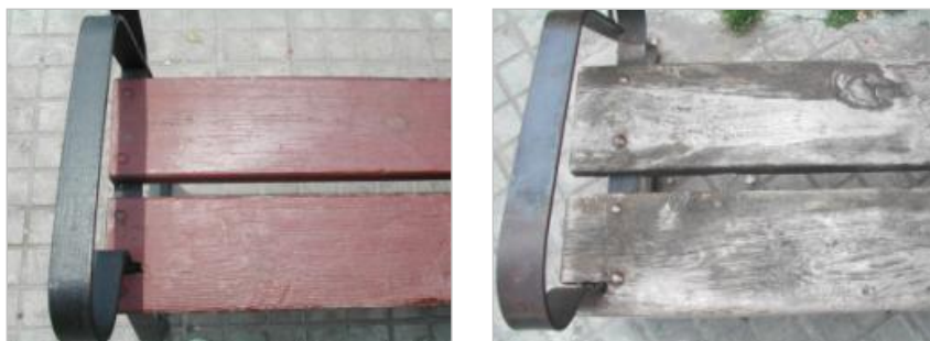
Figs. 71 y 72, Diferencia del mantenimiento y conservación
