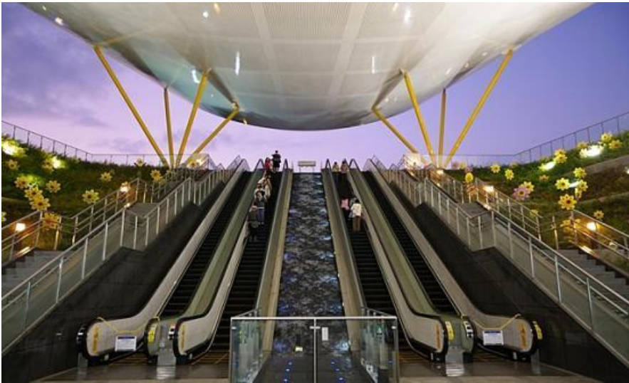
Fig. 88, La entrada de la Estación de Parque Central
