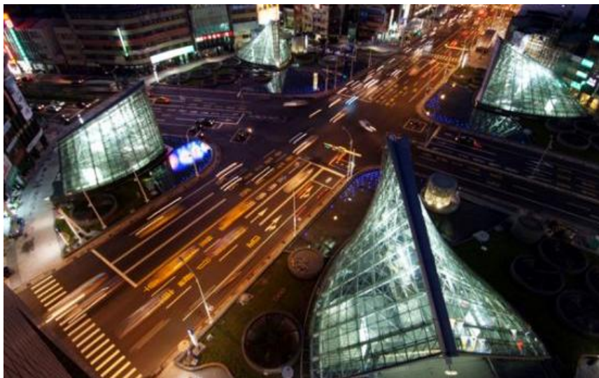
Fig. 92, La Estación de Bulevar de Formosa
