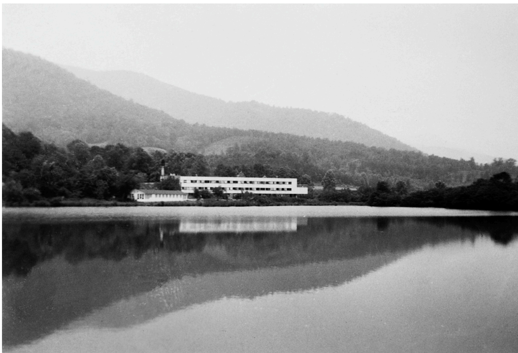
Figura 38: Vista panorámica de las instalaciones y el entorno de la Black Mountain College.
