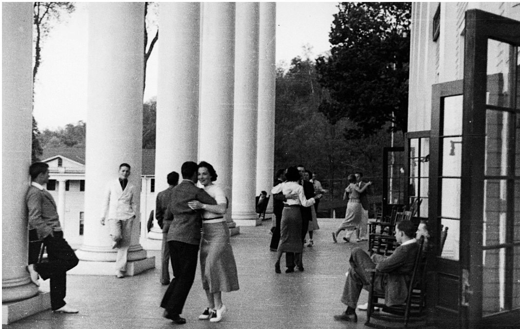
Figura 37: Estudiantes bailando en el porche del edificio principal.
