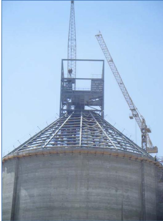
**Figura 3.18.** Ejecución de la cubierta y casetón superior de un silo cilíndrico para clínker.
