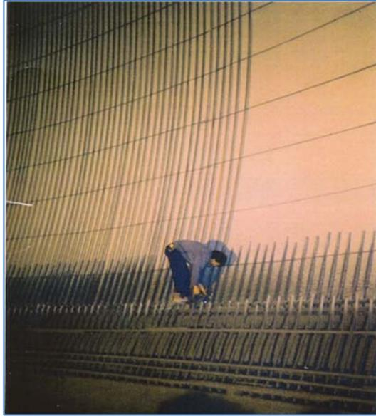
Figura 3.29. Ejecución del domo, ferrallado interior.
