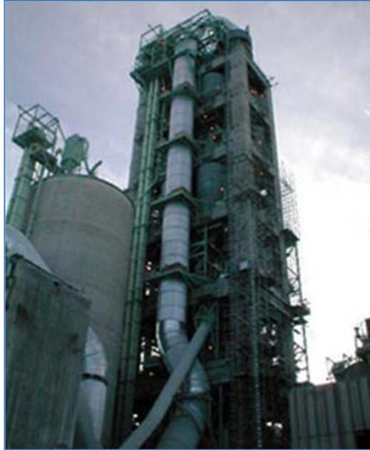
**Figura 2.9. Torre del precalentador de ciclones.**
