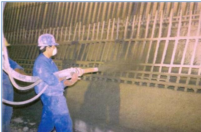
**Figura 3.28. Ejecución del domo, hormigonado.**
