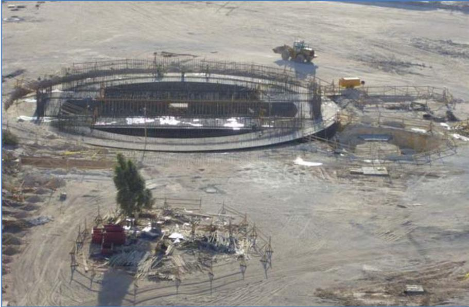
**Figura 3.16. Construcción de la cimentación de un silo cilíndrico para clínker.**
