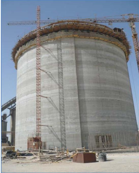
**Figura 3.17. Silo cilíndrico para clínker en construcción.**
