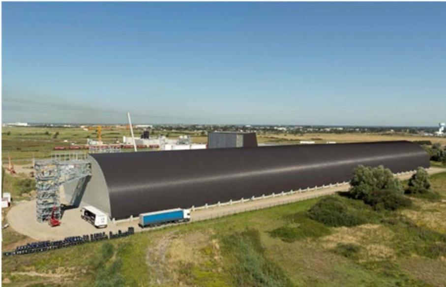
**Figura 3.19. Almacén longitudinal para clínker.**
