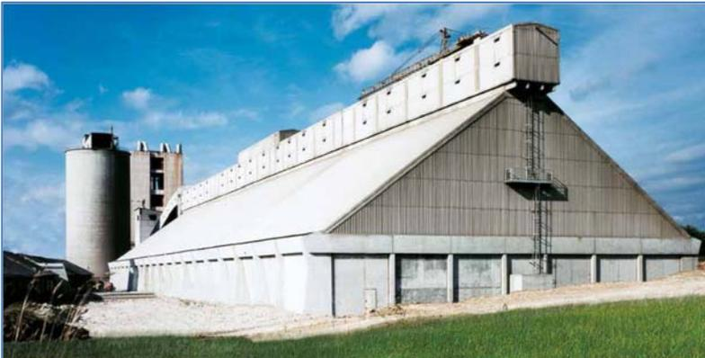
**Figura 3.21. Estructura de cerramiento del almacén longitudinal.**
