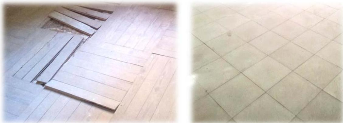
Fig. 4.7. Pavimento de madera y baldosa hidráulica. Orenes García, Matías J., 2012.
