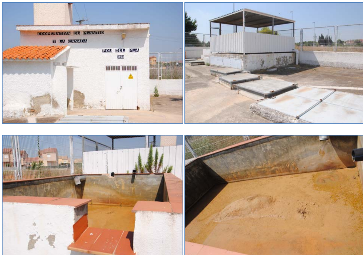
Ilustración 3 : Imágenes del Pozo del Pla y del desarenador
