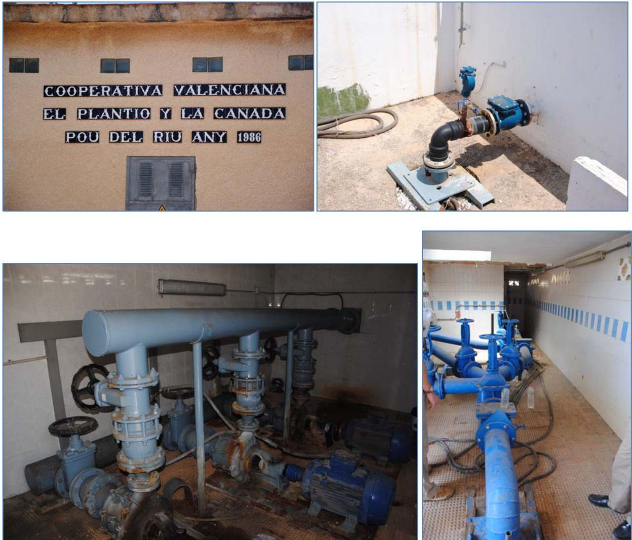
Ilustración 7 : Pozo y grupo de bombeo del Río y pozo de Despeñaperros (arriba derecha).
