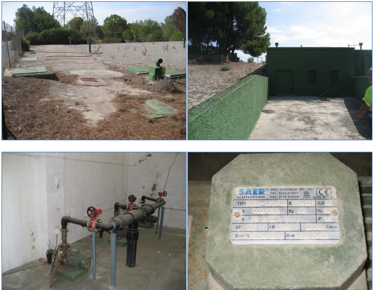
Ilustración 15 : Depósito y grupo de presión de Cumbres. En desuso / reserva.
