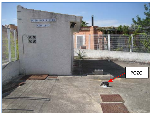
Ilustración 13 : Pozo de San Miguel. En desuso (sin tubería de conexión).
