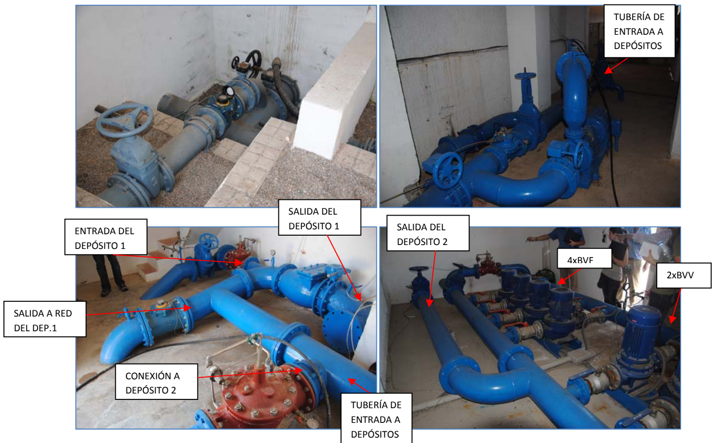
Ilustración 9 : Elementos y equipos correspondientes al depósito de la Conarda.
